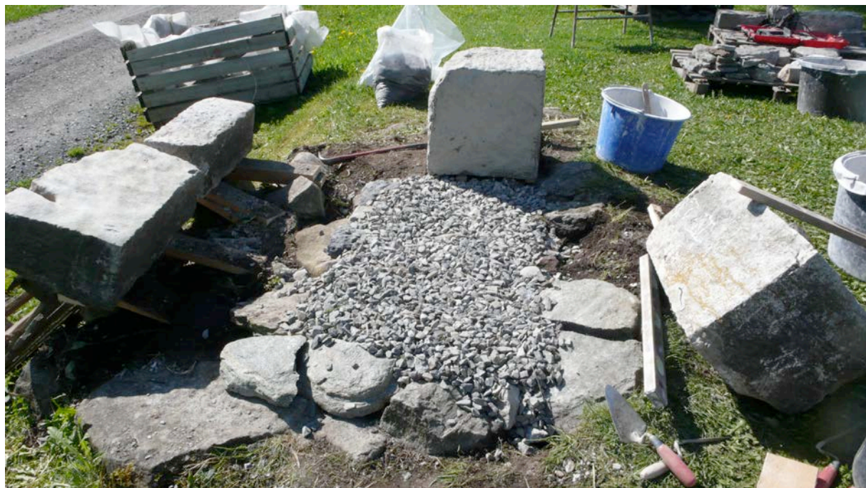
Fundamentet kultet. Sett fra nord.
