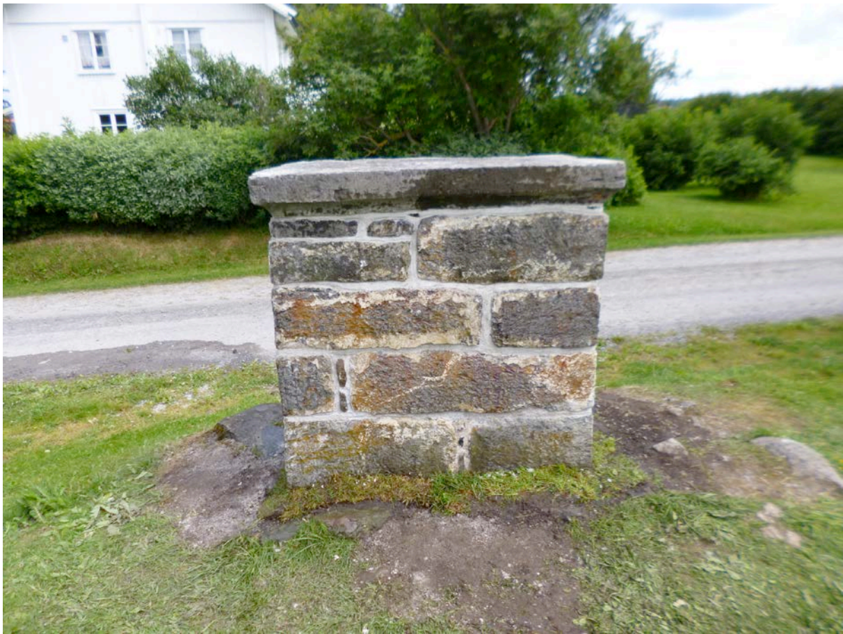
Ferdigstilt alter med gress ved foten. Sett fra vest.
