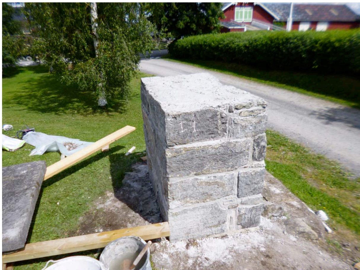
4 skift ferdig murt, klart for alterplaten.
