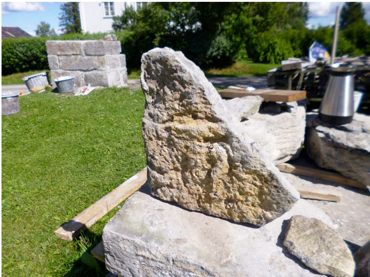
Ferdiglimt stein for øverste skift. Limt med Akepox 2010.
