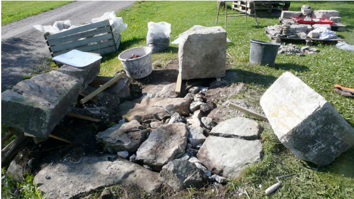
Fundamentet ferdig rensset for betong og jord. Steinsatt mellom større stein. Sett fra nord.
