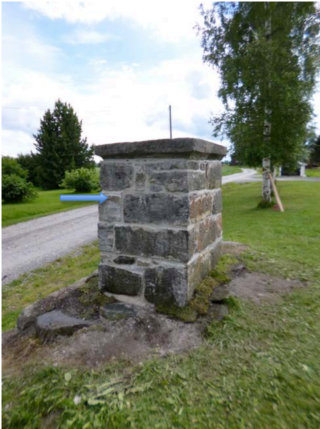
Alteret sett fra Nord. Blå pil tuktet stein.
