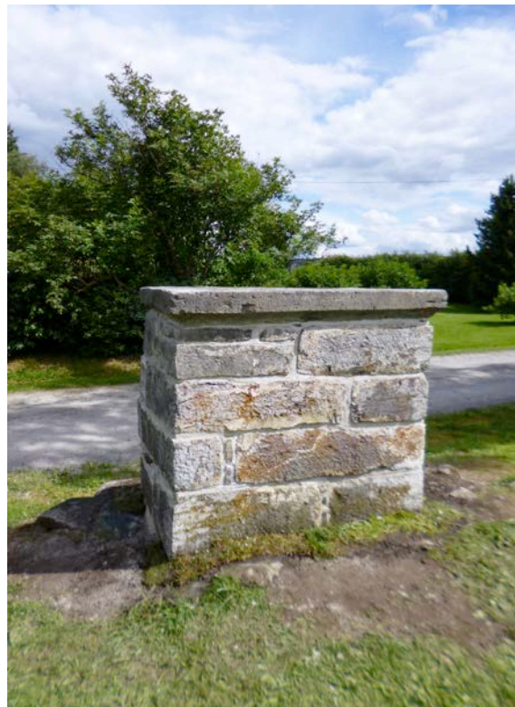
Alteret ferdig utbedret 29.06.16
