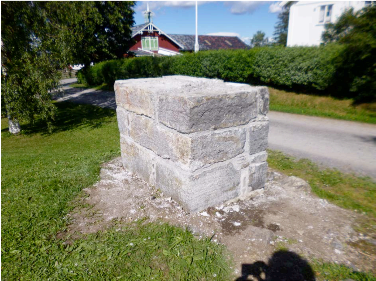
3 skift ferdig murt. Sett fra sørvest.
