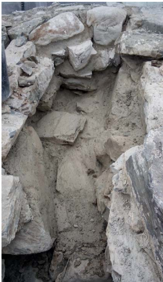
2011139_009 og 013 Bilder tatt under arbeid etter rensing. Murverket er gysert i bunn og toppdekket mures tilbake
