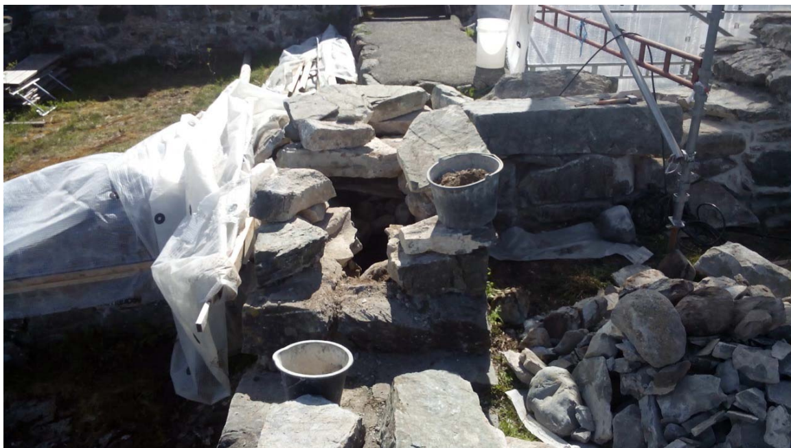
20061129_001 Bildet viser vestvegg i rom 116 og nordvegg i rom 103 under arbeidet med rensing av murkjerne for jord og oppløst mørtel.
