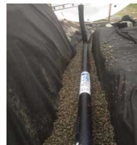
20061140_071 Oppmuring av terrasse og konservering av 1. skift. Klargjøring for duk, drenering og drenerende masser i bakkant av muren. Det er også tilført en del stein i bakkant av muren for å dimensjonere denne bedre. Muren er i dag ca 80 cm tykk mot tidligere 40 cm.
