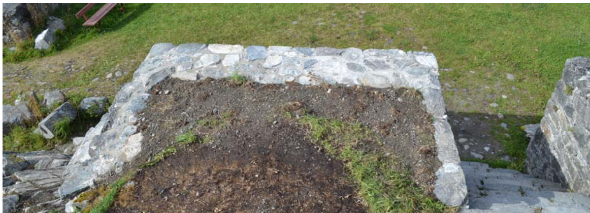
0102 og 0107 midlertidig arkivnummer. Terrasse ferdig murt
