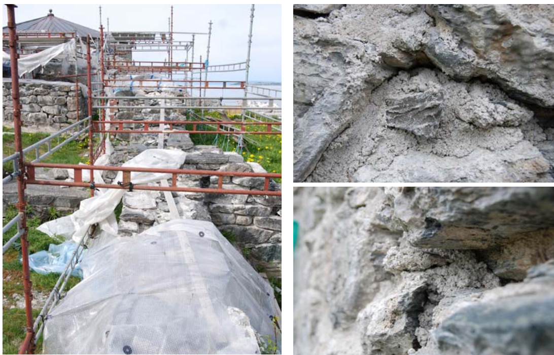
Foto til venstre fra 2011 viser tildekning og til høyre konserveringsarbeid med NHL 5. Ref. 20061122_001 og 002 til høyre. 20061123_012 til venstre.
