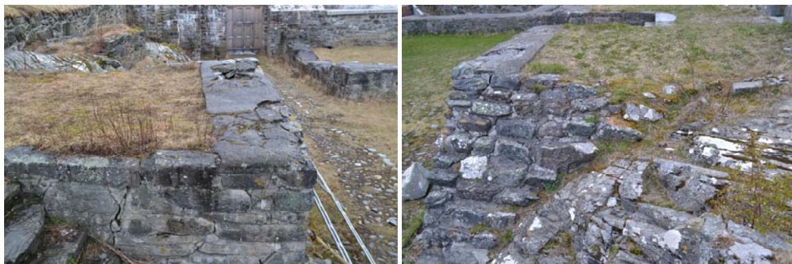
20061140_028 og 42. Østre side på bildet til venstre hvor trapp opp fra borggård går i dag. Bildet til høyre er avtrapping av mur mot vest.
