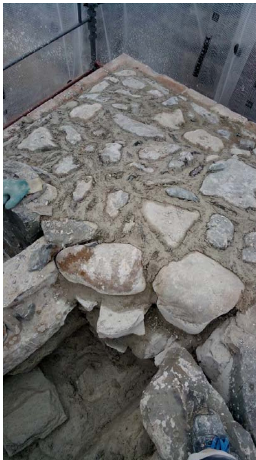
2011139_009 og 013 Bilder tatt under arbeid etter rensing. Murverket er gysert i bunn og toppdekket mures tilbake
