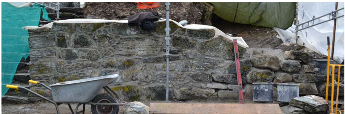
20061140_071 Oppmuring av terrasse og konservering av 1. skift. Klargjøring for duk, drenering og drenerende masser i bakkant av muren. Det er også tilført en del stein i bakkant av muren for å dimensjonere denne bedre. Muren er i dag ca 80 cm tykk mot tidligere 40 cm.
