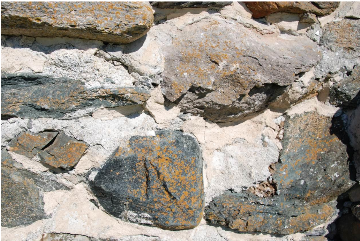
Restaurering med ”kalkmørtel” i realiteten en god kalksement og en moderne ikke fungerende jurakalk fra 1980-tallet.
