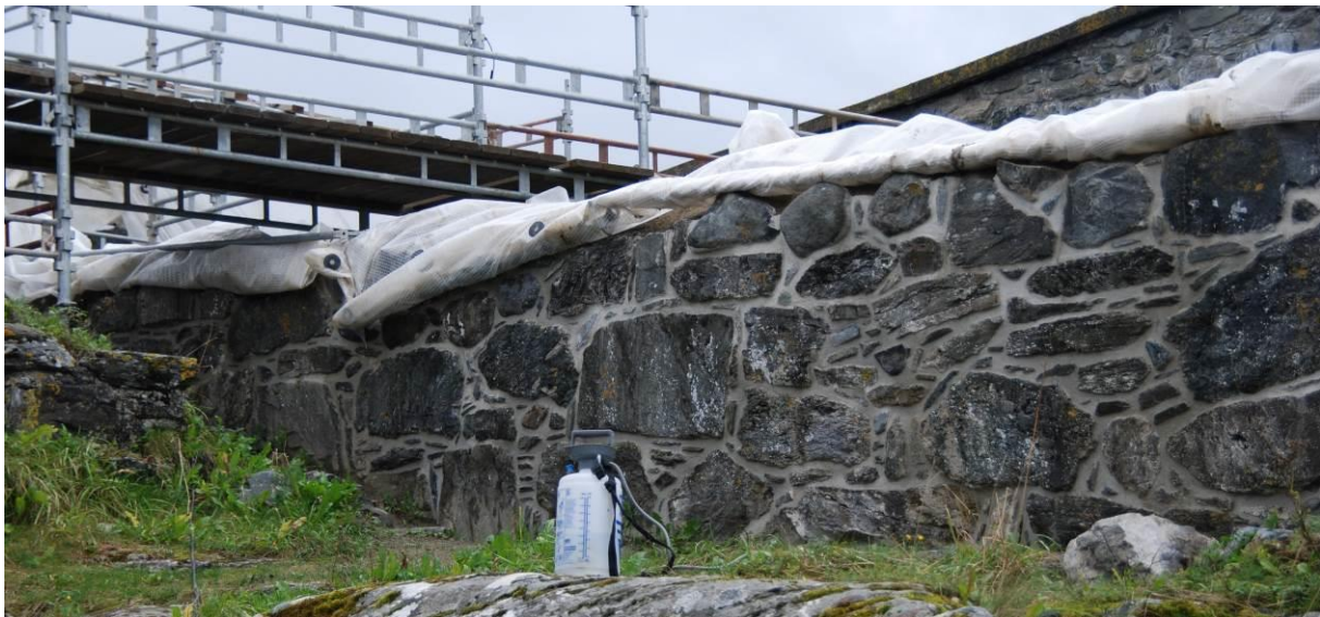
Ferdig spekket og pinnet murverk avdekt for ettervanning.
