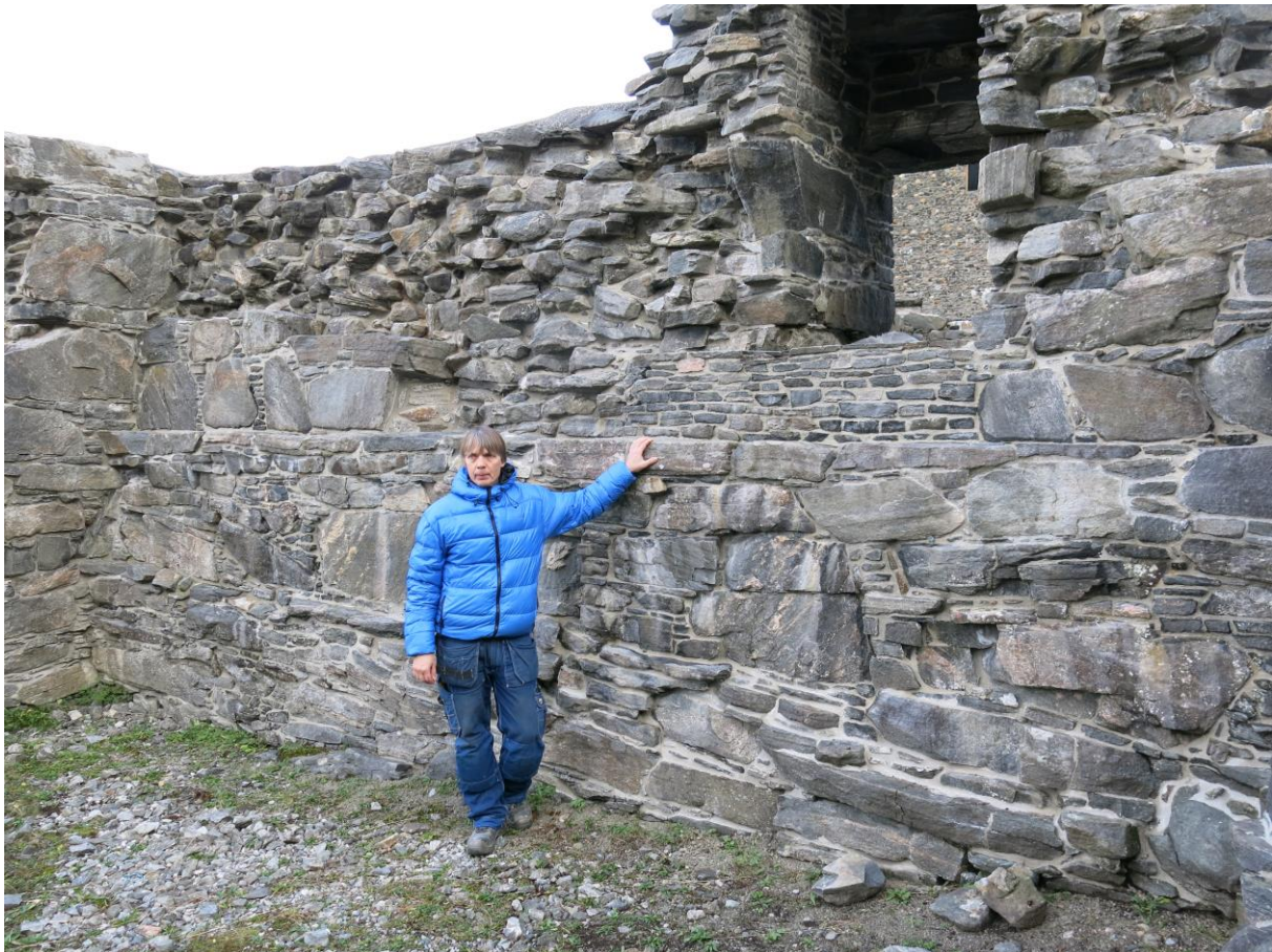
Forfatteren, Geir Magnussen, ved nykonservert murverk på Selje kloster i 2014. Foto: Riksantikvaren
