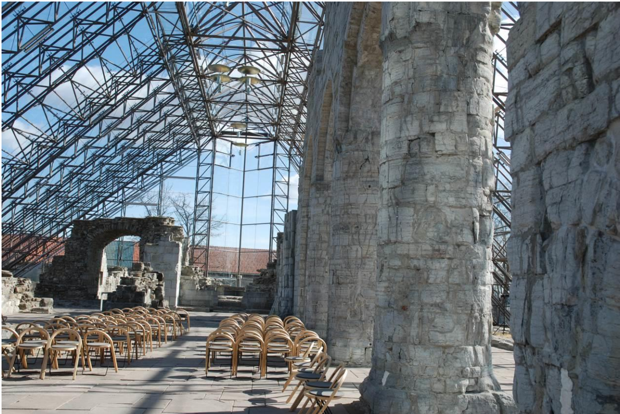
Ruinene av Domkirken på Hamar. Vil vernebygget ”låse tilstanden” og bevare ruinen for all fremtid?
