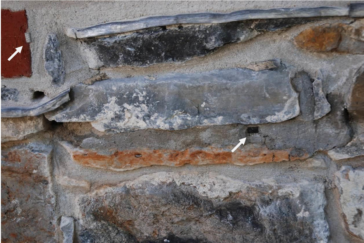
Ny og eldre merking av murverk. Årstallet er preget inn i metallstykkene.
