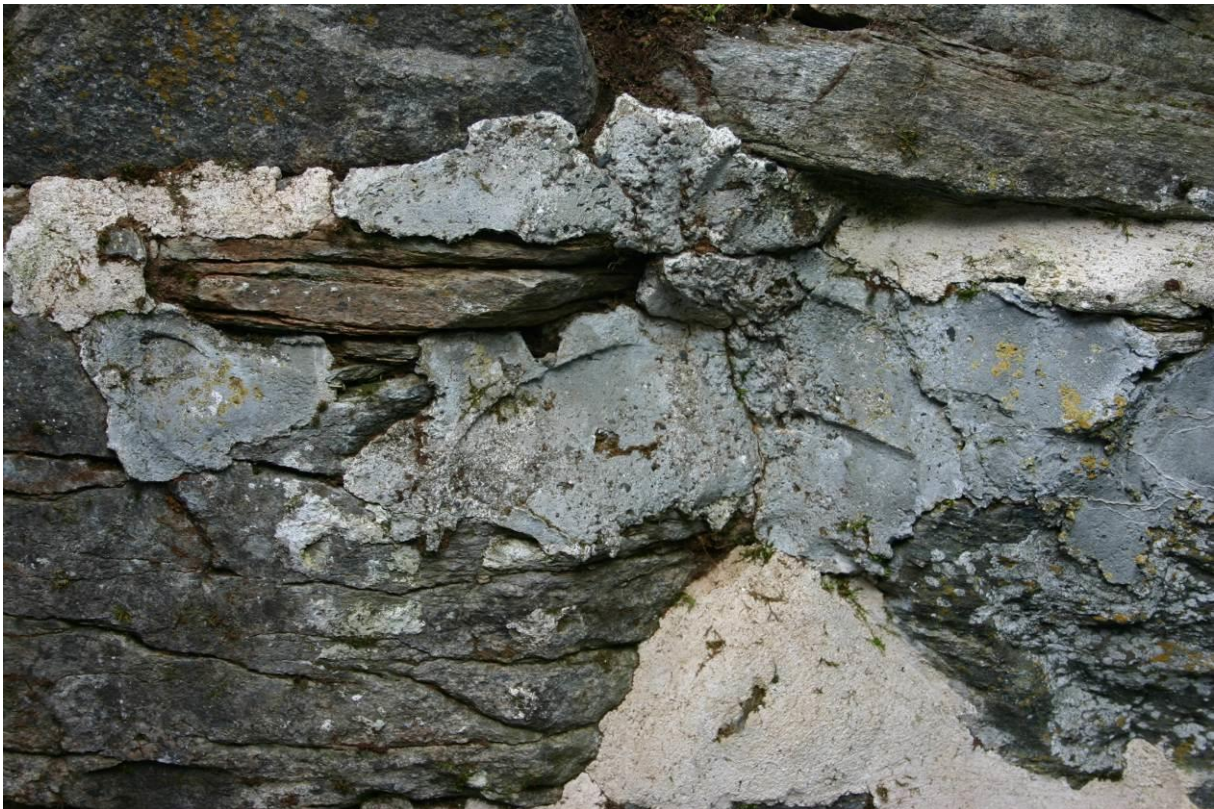
Blågrå sementrik mørtel fra omkring 1960- og 1980-talls ferdigmørtel med hydraulisk kalk som en bestanddel av bindemiddelet.
