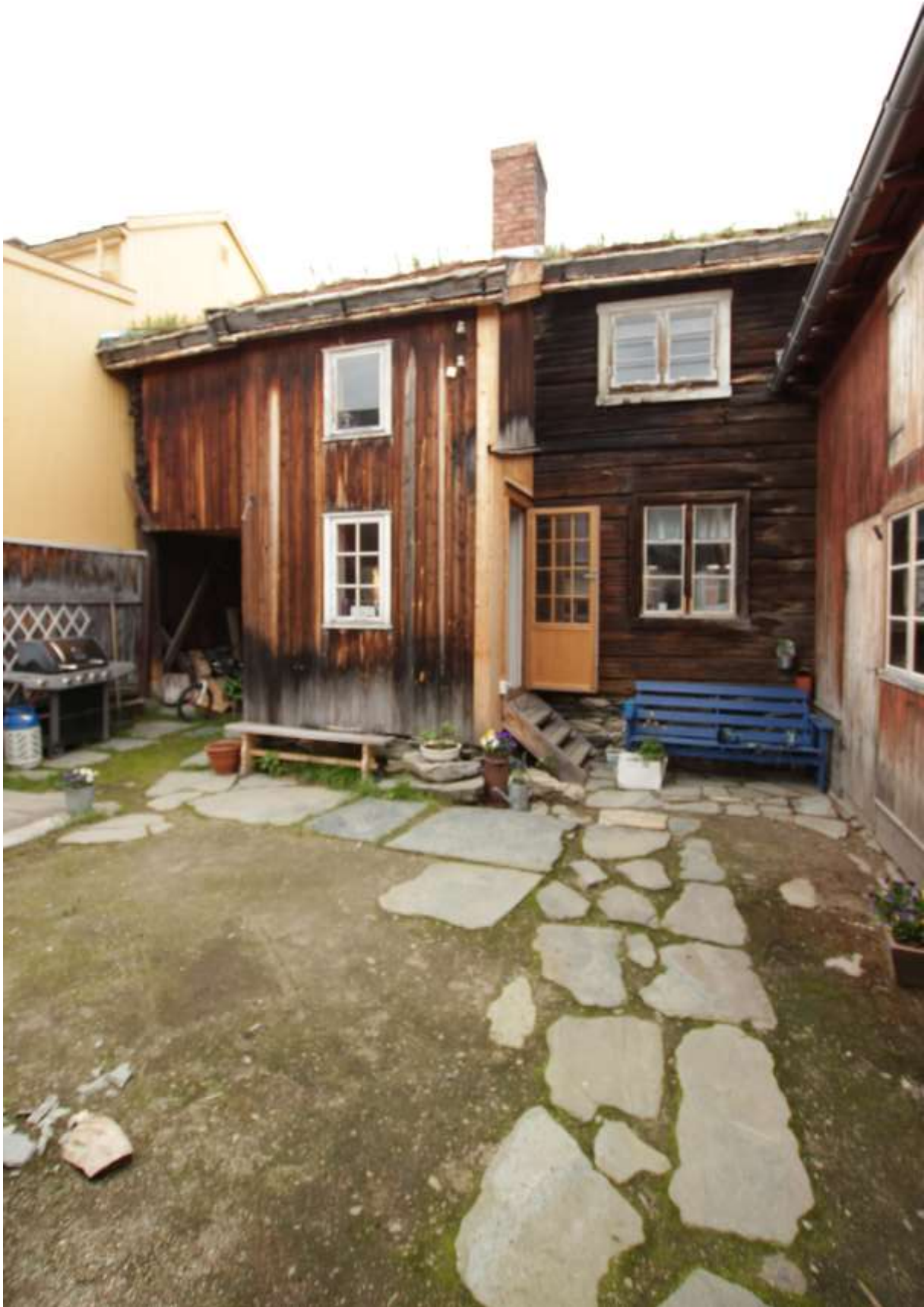
Figur 3. Røros. Nedre Flanderborg 1. Hovedbygningen sett mot nord. Foto J. Brønne. 13.6.16.
