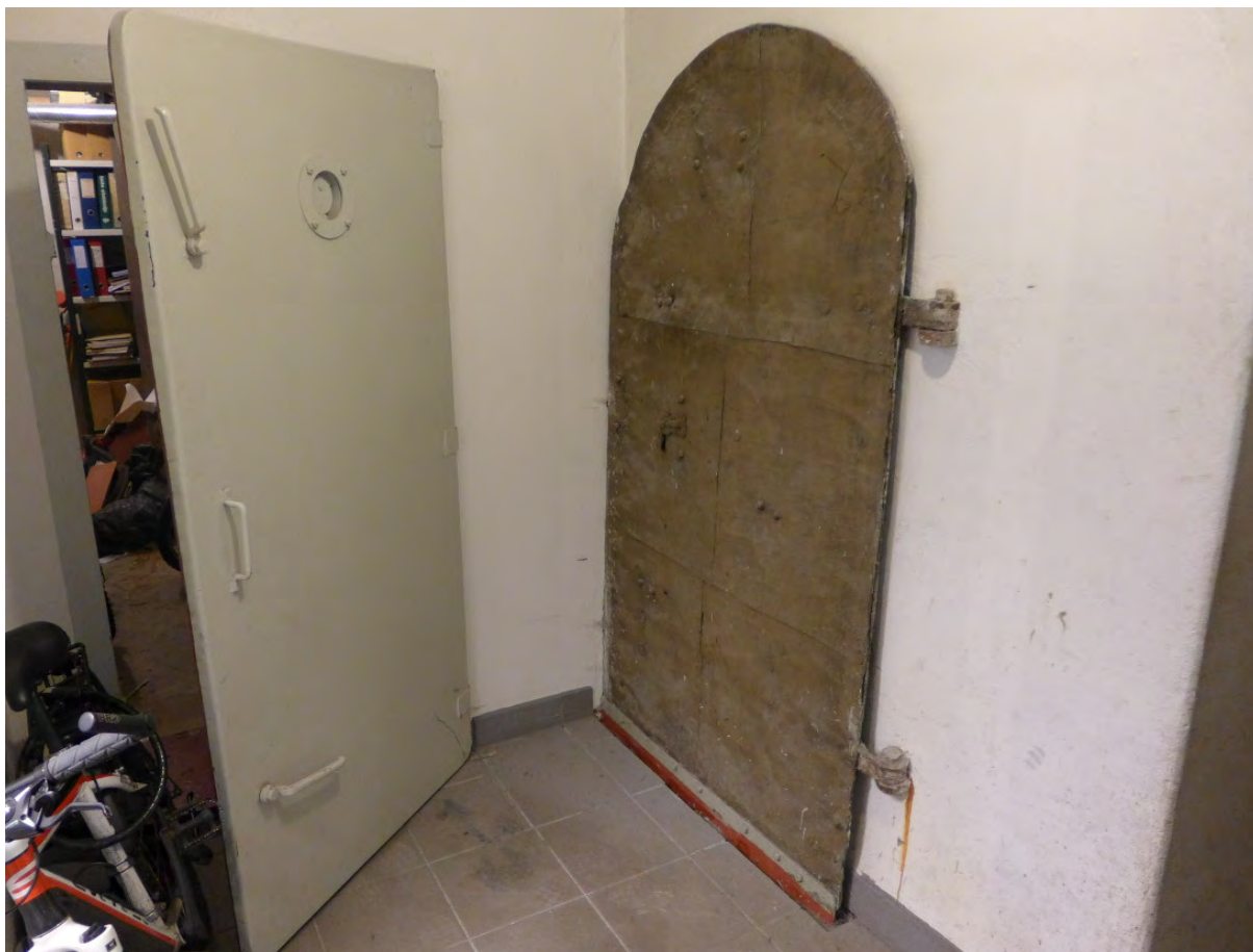
Figur 13. I kjelleren under den ombygde folkekjøkkenbygningen, er det bevart steinkjellere med hvelv. En gammel jernjør, fremdeles hengslet til vegg i en ombygget døråpning, vitner om at kjelleren trolig har vært benyttet som brannsikkert lagerrom (Foto: Byantikvaren 2015).
