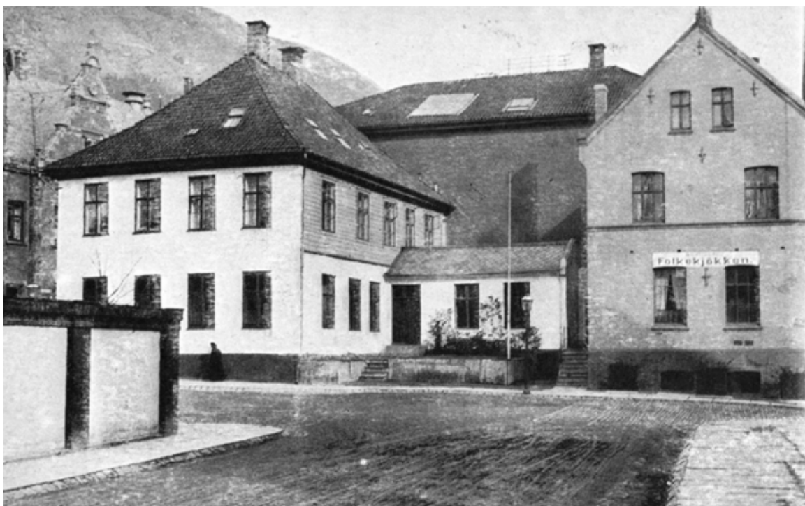
Figur 9. Nordfløyen i Magistratbygningen med bakbygningen mellom denne og Bergens Folkekjøkken. Bildet er tatt før ombyggingen i 1920-årene. Bygningen i bakgrunnen er den gamle politistasjonen (Kilde: http://fotomuseum.bergen360.no ).
