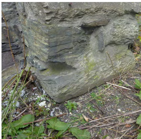
Figur 16. Pilaren øst i murlivet hviler på en profilert sokkelstein (Foto: Byantikvaren 2015).
