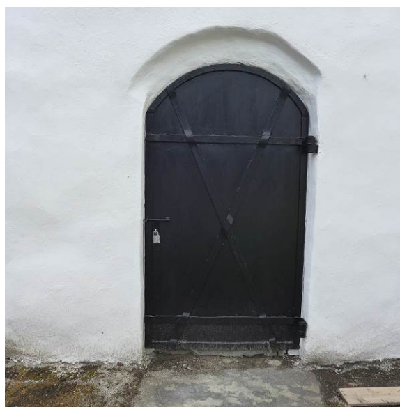
Fig. 21. Etter tiltak. Dørbladet er rustbehandlet og malt svart mens teglsteinsforingen er pusset inn med kalkpuss (foto: Byantikvaren 2015).
