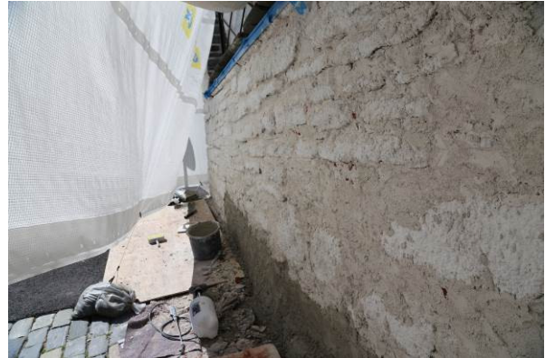
Fig. 7. Flere grunningslag ble påført (foto: Byantikvaren 2013).
