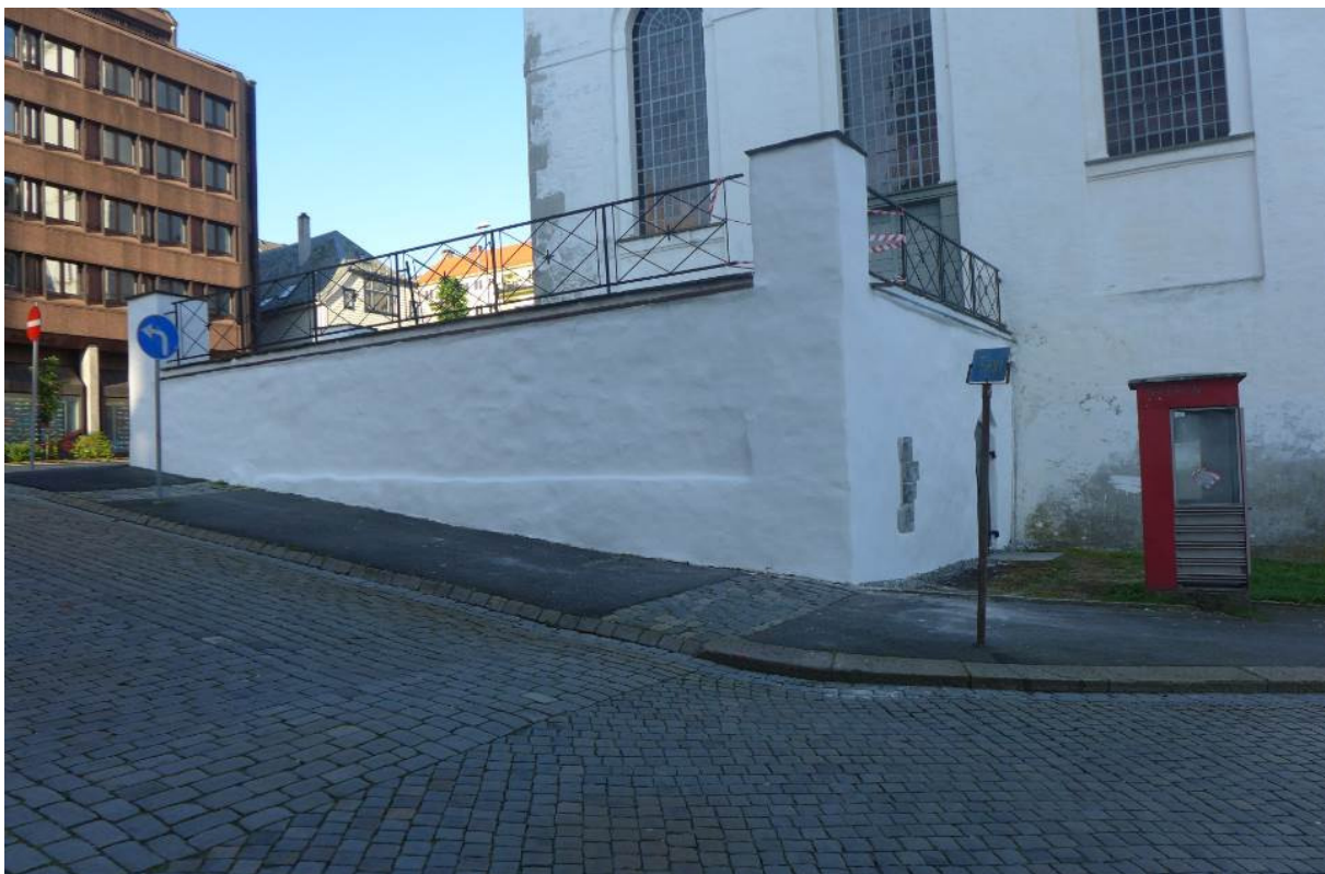
Fig. 8. Sørveggen i terrassen ferdig istandsatt. Veggene er pusset og hvittet med kalkprodukter. Merk brosteinsmarkeringen i fortauet og i gaten, som markerer middelaldermurer bevart i gategrunnen (foto: Byantikvaren 2015).
