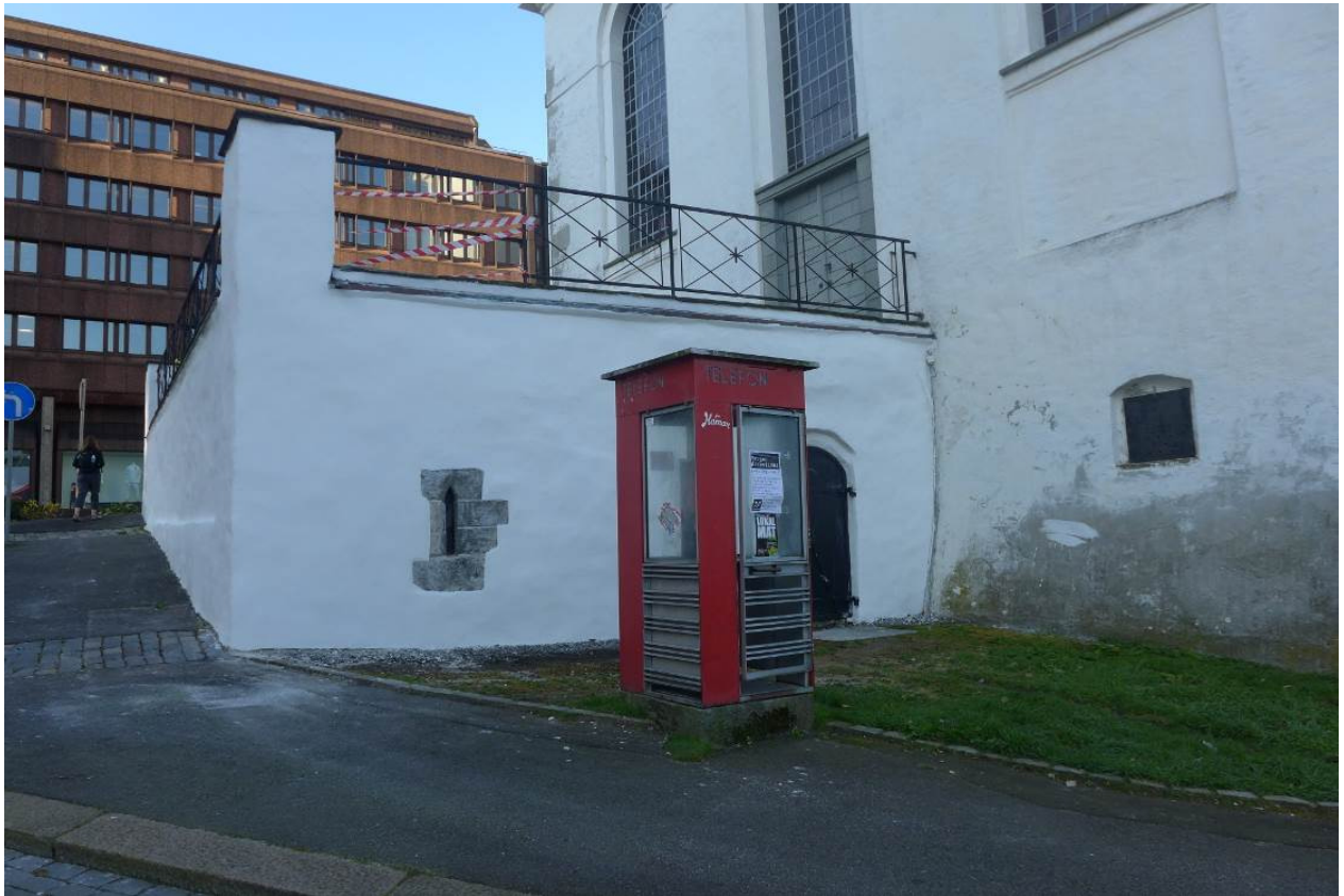
Fig. 9. Østveggen ferdig istandsatt (foto: Byantikvaren 2015).
