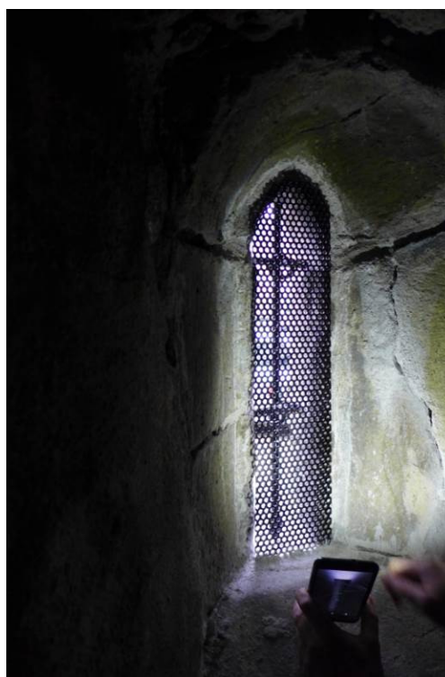
Fig. 23. Etter tiltak: Gitter på innsiden av vindussmyget (foto: Byantikvaren 2015).
