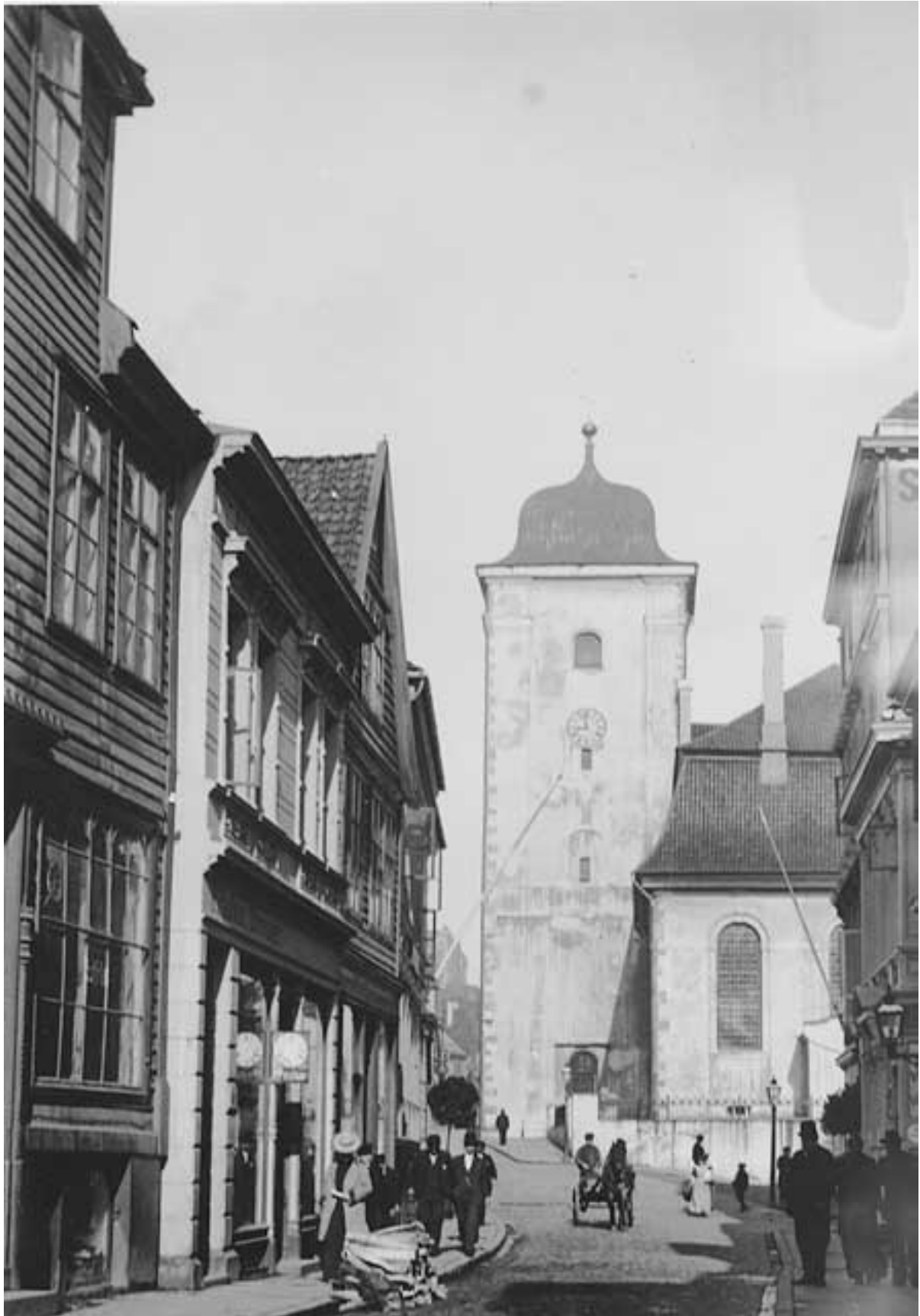
Fig. 1. Strandgaten og Nykirken med den hvitkalkede terrassen omkring århundreskiftet (foto: Lauritz Bekker Larsen, Billedsamlingen, UiB).
