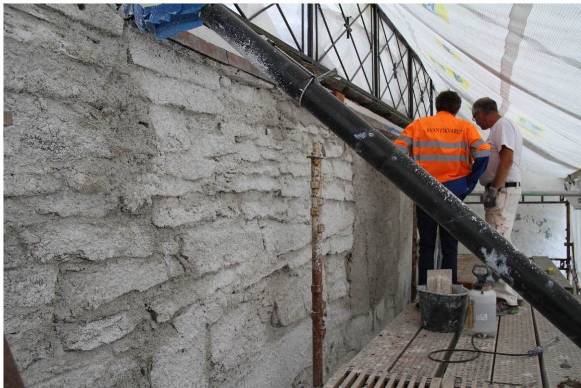
Fig. 13. Pusslag legges på i øvre del av østveggen (foto: Byantikvaren 2014).
