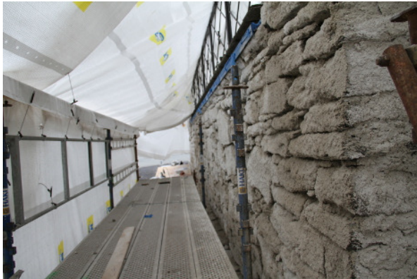
Fig. 6. Grunningslag med hydraulisk kalkmørtel påført på sørveggen (foto: Byantikvaren 2013).
