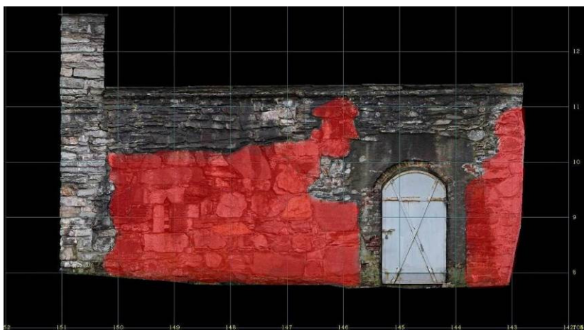
Fig. 12. Murverket merket med rødt vurderes som middelaldersk (Illustrasjon: Tilrettelagt fra fotogrammetri oppmåling).
