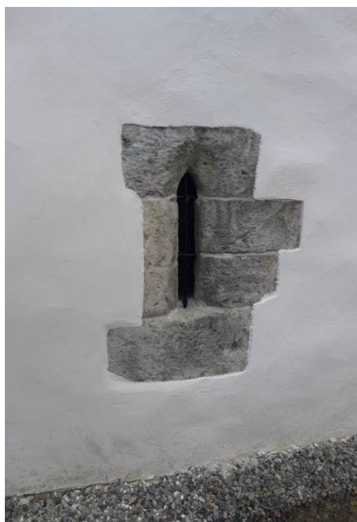
Fig. 22. Etter tiltak: Etter at murlivet ble pusset er vindussmyget mer synlig i murlivet, slik som tilfellet var i middelalderen (foto: Byantikvaren 2015).
