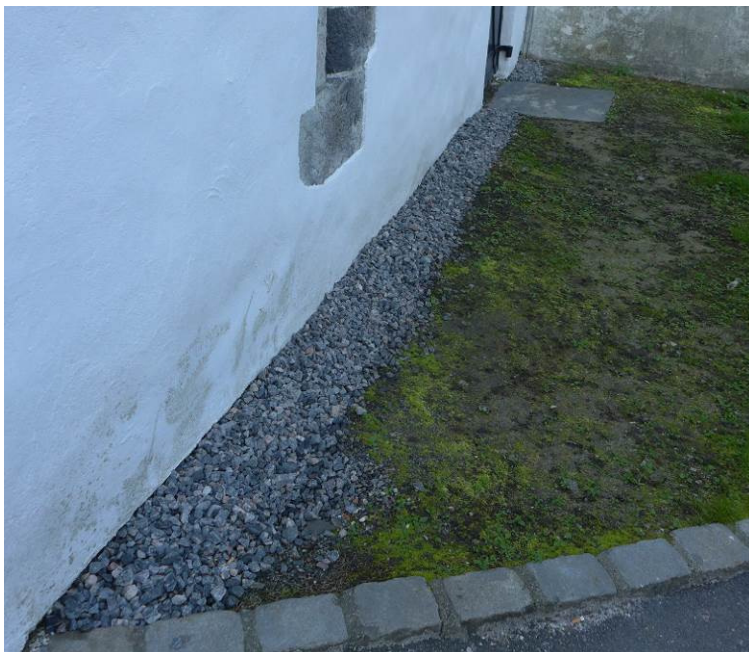
Fig. 15. Langs murfoten på østveggen ble det lagt singel for å forhindre regnsprut mot murlivet (foto: Byantikvaren 2014).
