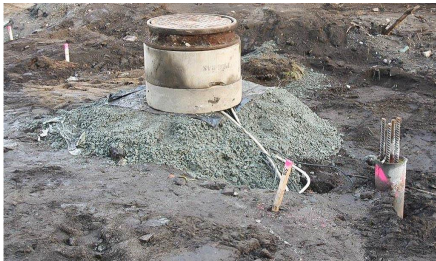
Figur 1b Tildekking av profil med Voltekst bentonittduk i profil sør hvor miljøovervåkingssensorer er satt inn (over) og beskyttelseskum for midlertidig skap med logger og sender (under). (Foto Anna Petersén NIKU)
