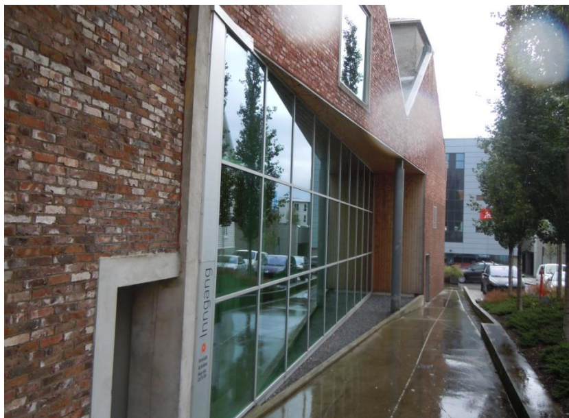
Foto 5.11: Oransjeriet, Stavanger, detalj: Nytt vindusfelt i hovedfasadens midtparti
