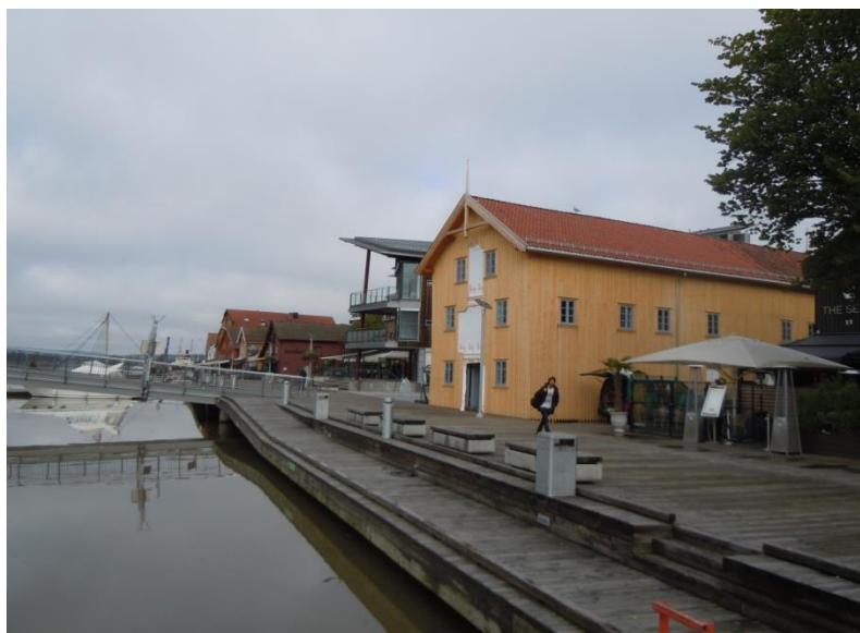
Foto 5.6: Bryggen i Tønsberg, Foyn-gården nordre sjøbod fra øst, under istandsettelse. Nytt bygg er bygget utenpå det opprinnelige sjøbodet
