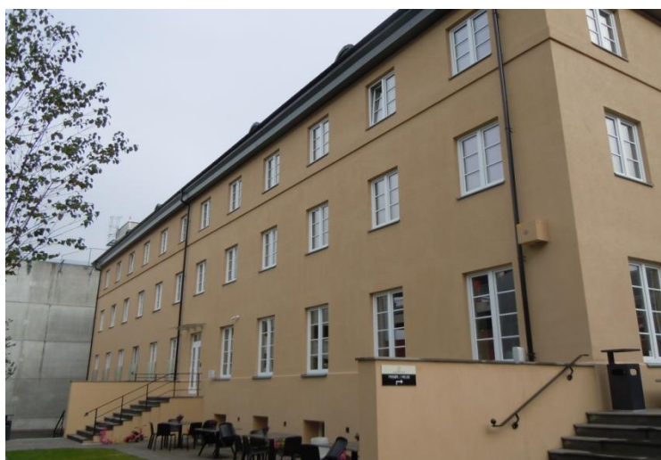
Foto 5.18: Wilhelmsen House, Tønsberg, fasade mot vest
