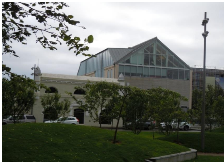
Foto 5.14: Borgen, Stavanger. Viser åpning og glassetting i gavl og mot sjøen
