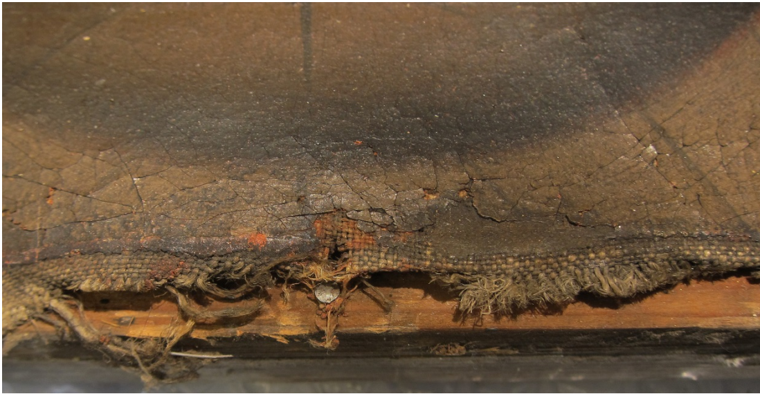
Fig. 11 Øvre oppspenningskant før behandling
