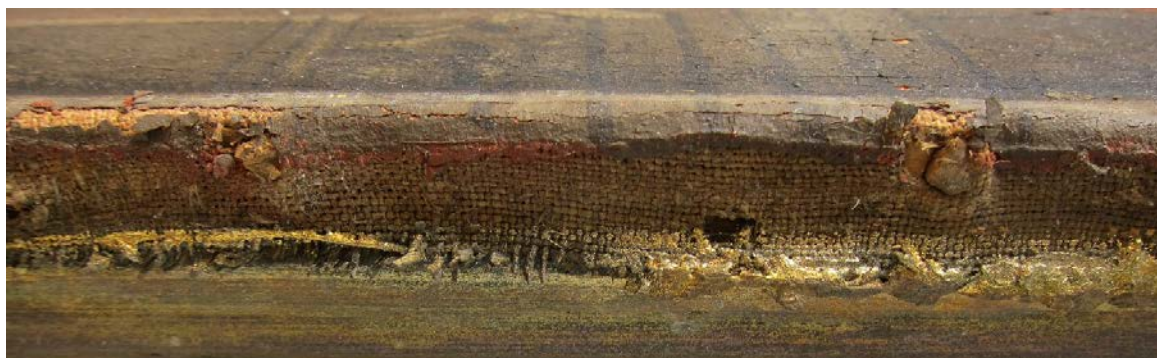
Fig. 9 Øvre høyre oppspenningskant
