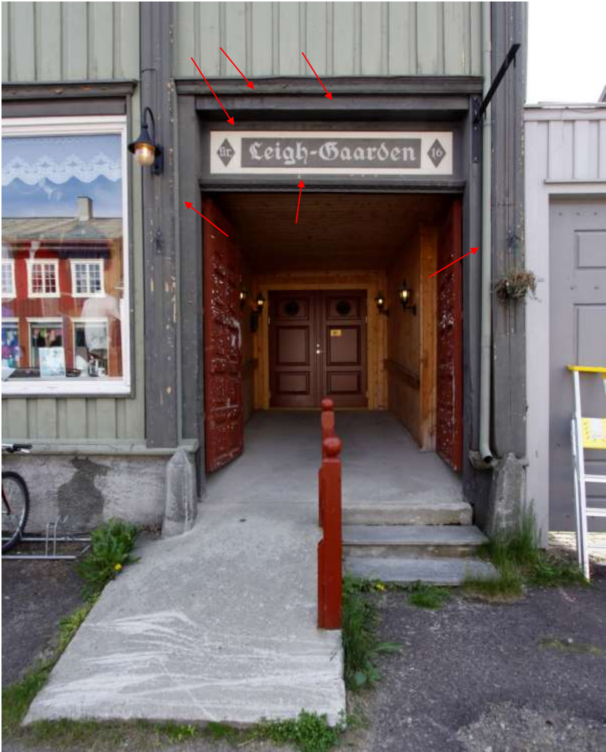
Figur 15. Røros. Engzeliushgården. Porten er åpen, og det støpte inngangspartiet er synlig. Opprinnelig har dette vært en kjøreport for hest og vogn/slede inn til gården. Døra innerst i portrommet leder til Kulturminnefondets kontorer. Foto: J. Brønne. 2012.
