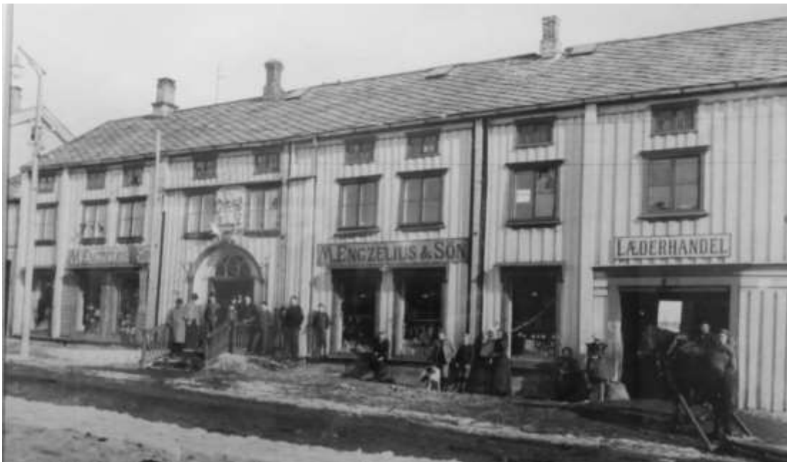
Figur 1. Røros. Engzeliusgården. Fasaden mot Bergmannsgata før ombyggingen i 1897. Bildet må være tatt i 1896 eller 1897. Røros fikk elektrisk gatebelysning i 1896. Hel til venstre i bildet står en av stolpene med den elektriske gatebelysningen. Rørosmuseets billedsamling.
