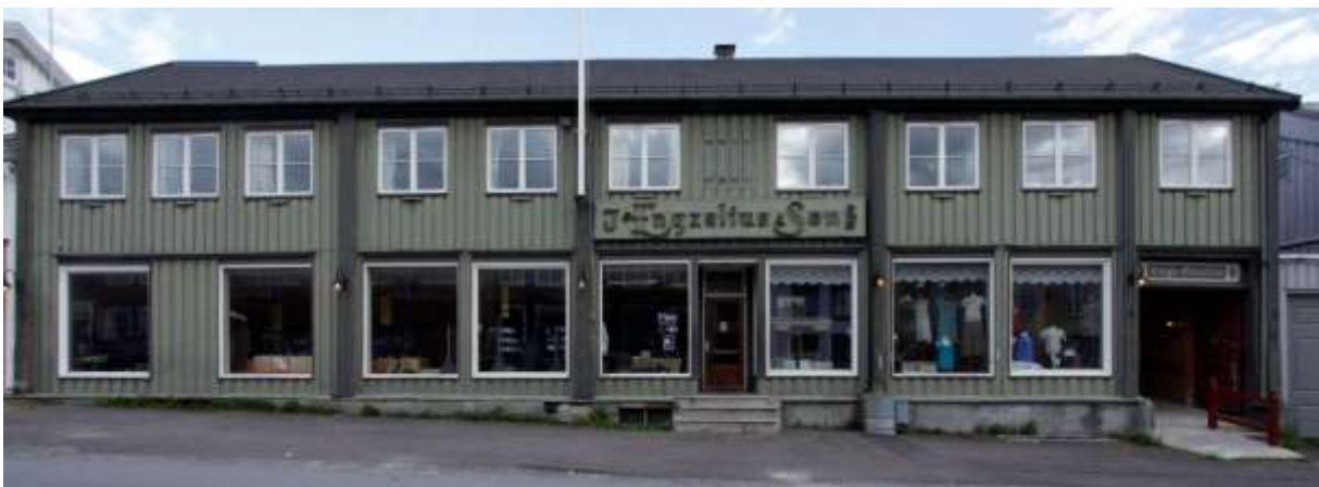
Figur 12. Røros. Engzeliusgården. Noen lykter av samme type som de forrige fra tidlig 1900- tall er satt tilbake på fasaden. Våpenskjoldet er tatt ned for fargeundersøkelser og restaurering. Foto: J. Brønne. 2013.
