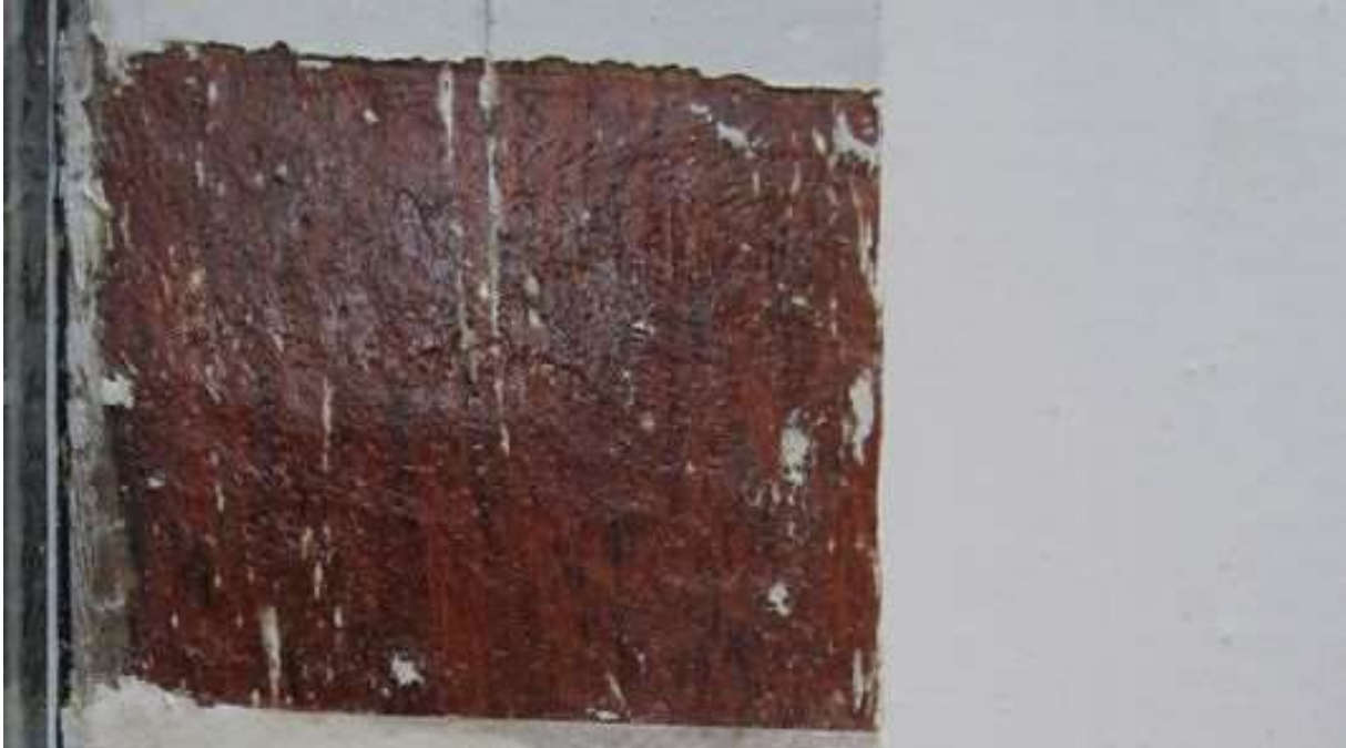
Figur 19. Røros. Engzeliusgården. Innfestingen av vinduet. Avdekket felt med opprinnelig overflatebehandling. Oljelasert mahogni. Foto: J. Brønne. 2012.
