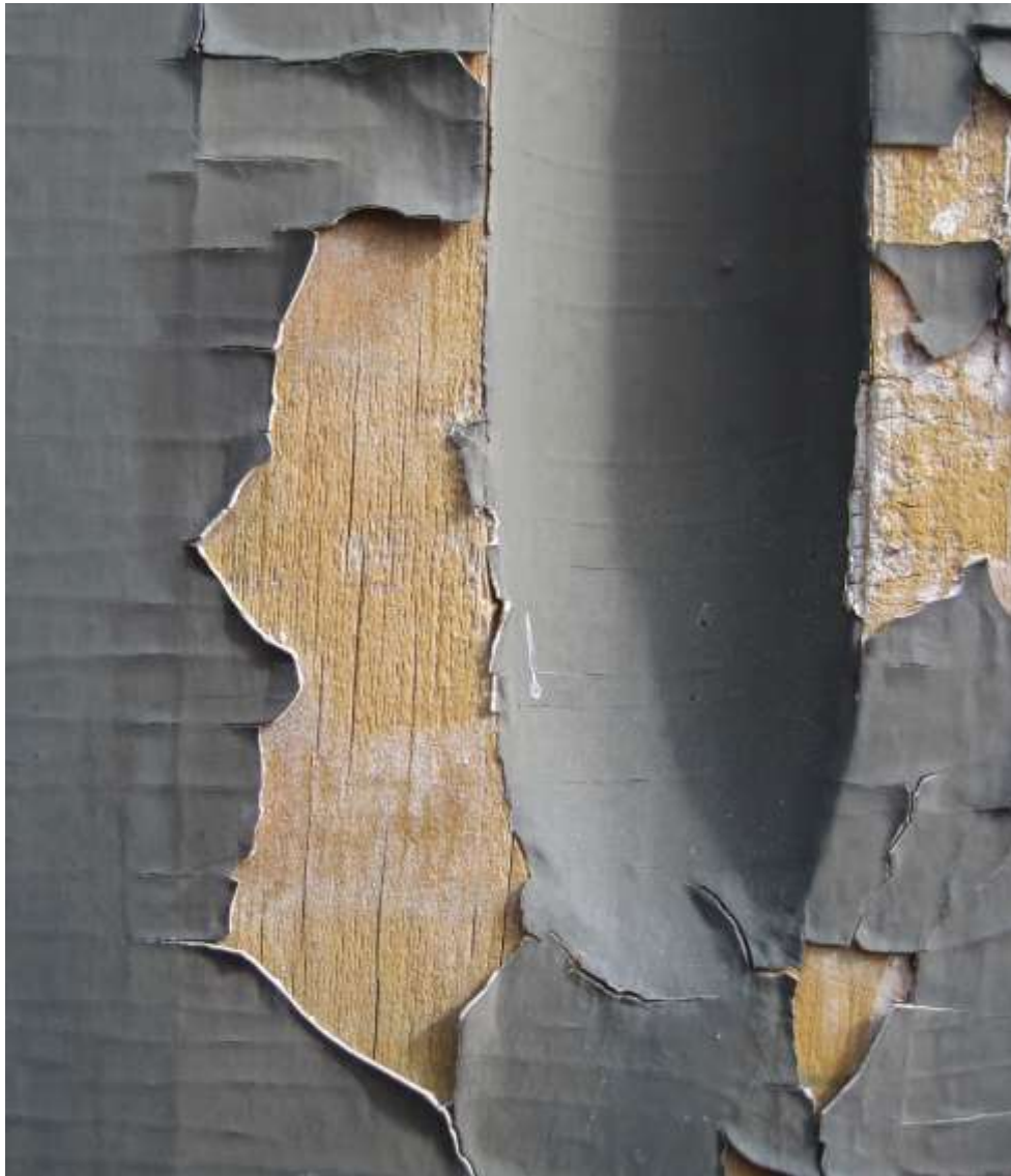
Figur 18. Røros. Engzeliusgården. I opp- og avskallinger i malinglagene på lisenene kan vi se begge grunningslagene og sparkelen. Lag 1,2 og 3 i tabellen over. Foto: J. Brønne. 2012.
