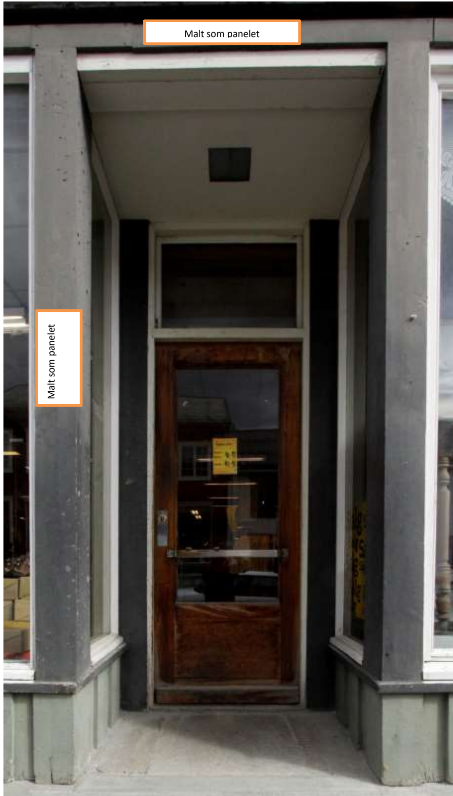
Figur 22. Røros. Engzeliussgården. Døra. Hele inngangspartiet er utformet med forbilder fra førkrigstidens funksjonalisme og den periodens utforming av detaljer. Døra har kun diverse lag med oljebaserte lakker. Foto: J. Brønne. 2012.
