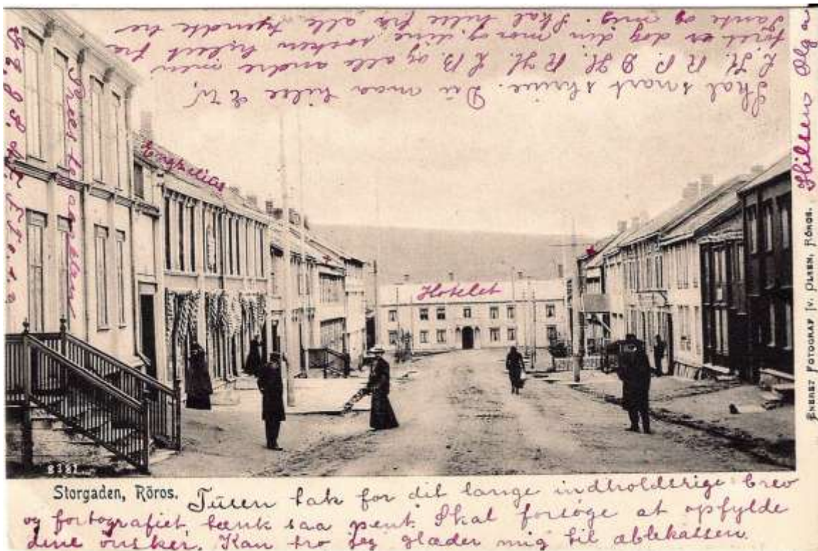
Figur 2. Røros. Engzeliustgården. Etter den fullstendige ombyggingen av fasaden i 1897. Fasaden ser ut til å være lys. Våpenskjoldet henger nå ca. midt på fasaden, ikke over en av dørene. Postkort. Poststemplet 18.9.1904. Jon Brønnes postkortsamling.
