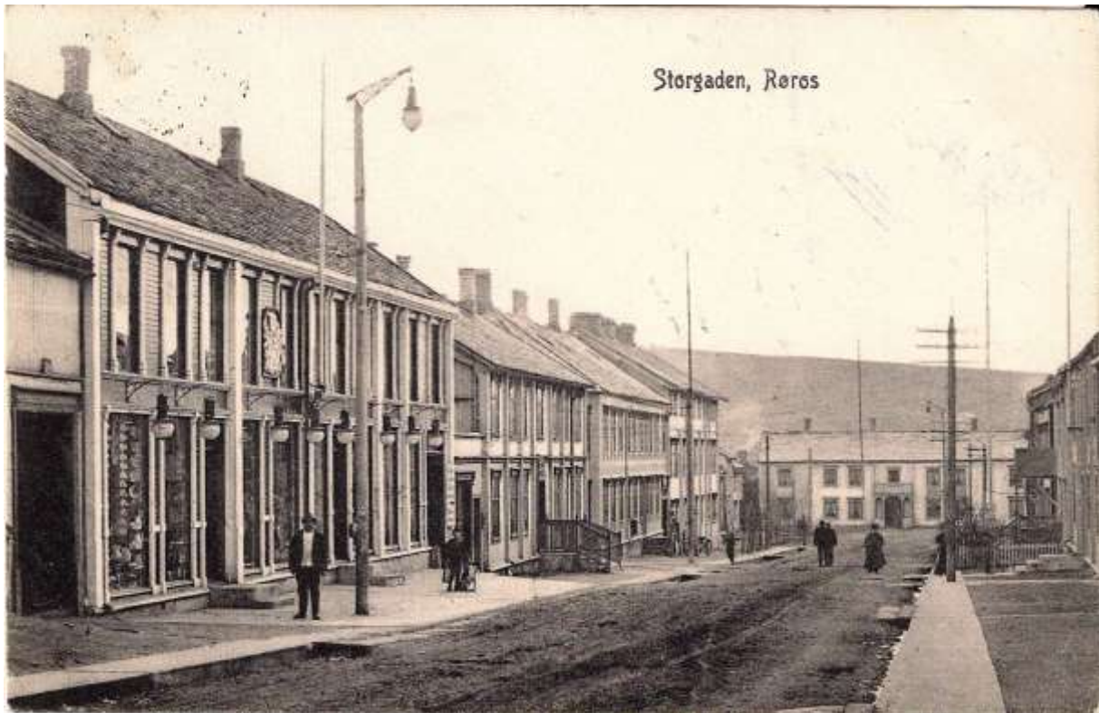
Figur 4. Røros. Engzeliusgården. Postkort. Poststemplet 25.12.1909. Fasaden er mørk, med lysere markeringer. I tillegg til stolpen med elektrisk gatebelysning, har Engzeliusgården fått lamper med elektrisk belysning på hele fasaden. På grunn av lampene er det ikke lenger plass til markiser. Våpenskjoldet henger nå ca. midt på fasaden, ikke over en av dørene. Jon Brønnes postkortsamling.
