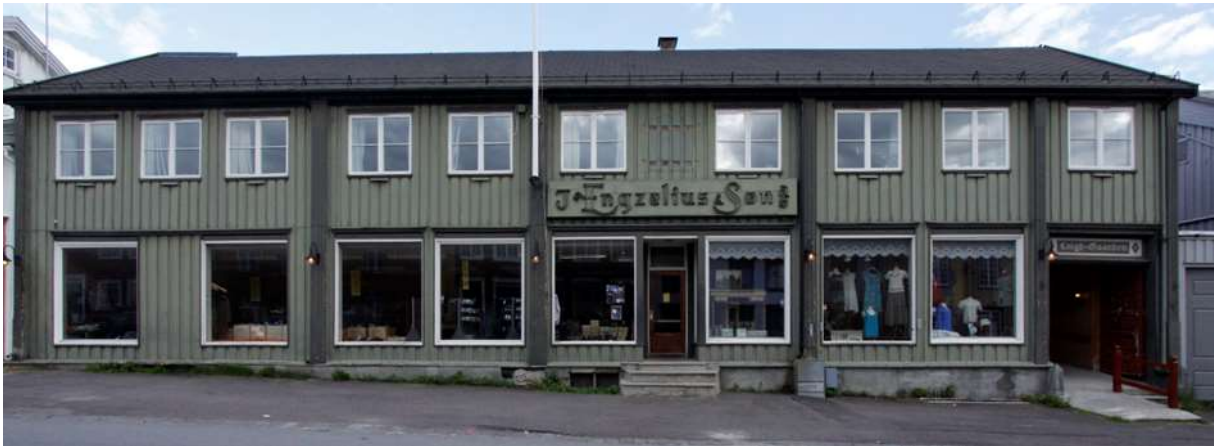
Figur 10. Røros. Engzeliusgården. Porten fra 1897 ble ikke byttet ut ved ombyggingen i 1949-50, men tekstfeltet over porten ble skiftet (Se fig 9). Noen endringer er utført etter 1949-50. Den nordlige døra i fasaden er fjernet og skiferen som lå på taket fra før 1896 ble i 1972 og erstattet av rød Eternit. (Se under) Foto: J. Brønne. 2013.
