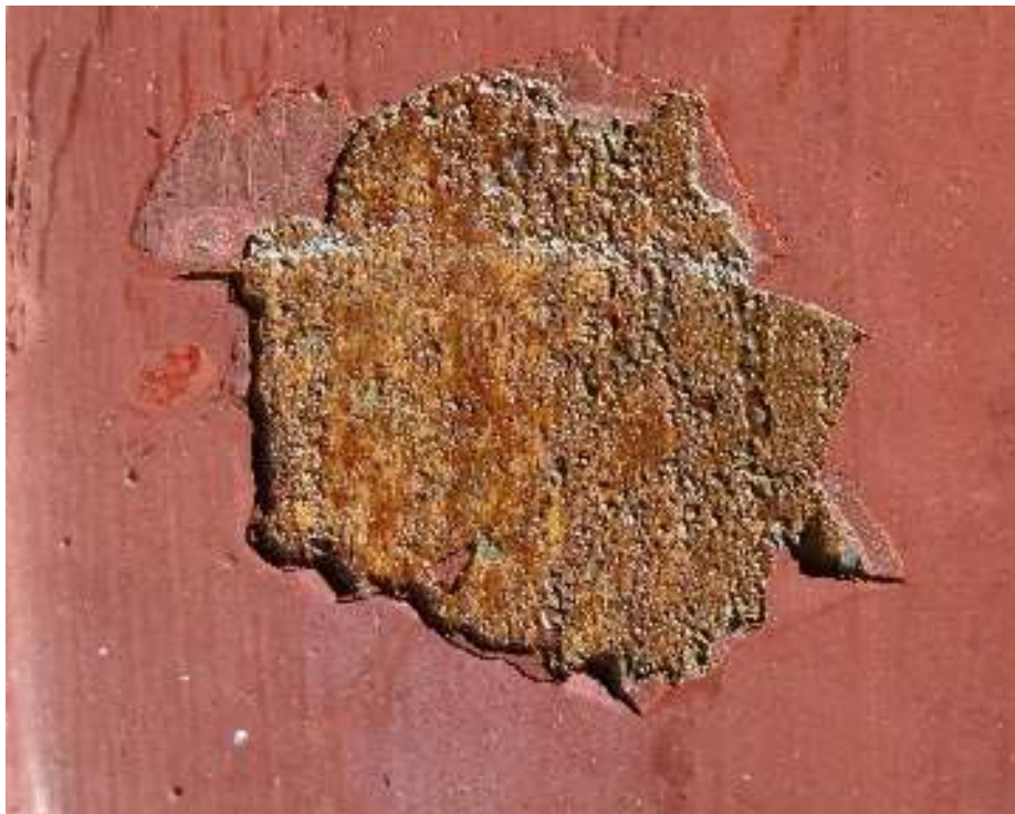
Figur 21. Røros. Engzeliusgården. Porten. Opprinnelig overflatebehandling, pigmentert olje. Foto: J. Brønne. 2012.
