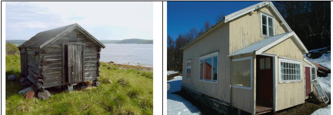
Figur 12. Stabbur i Sør-Varanger (t.v.), bolighus i Kåfjord (t.h.). Fra Sametinget: Orientering om automatisk fredete samiske bygninger, https://www.sametinget.no/Miljoe-areal-og-kulturvern/Samisk-bygningsvern/Orientering-om-automatisk-fredete-samiske-bygninger
