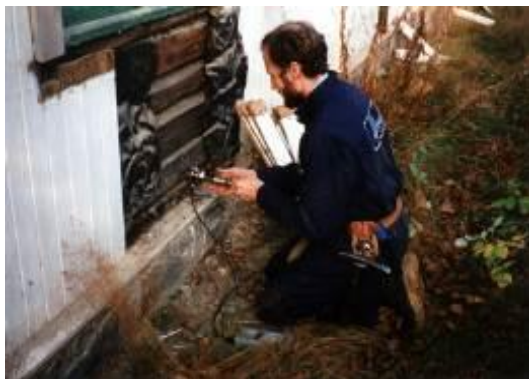
Figur 17. Konstruksjonsundersøkelser krever ofte inngrep i bygningen. Her fuktmåling med hammerelektrode i avdekket laftevegg.
