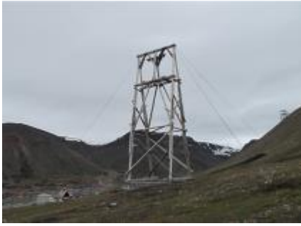
Figur 3. Taubanebukker med råteskader.
