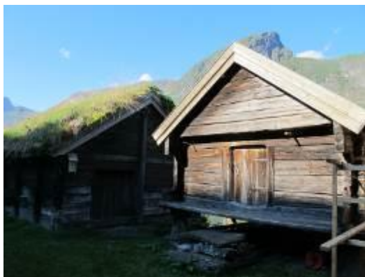
Figur 1. Soloppvarming i kombinasjon med morgendugg gir gunstige utviklingsmuligheter for husbukklarver på østvegg i forhold til nordvegg. På en solekspontert sør- eller vestvegg er det altfor varmt for larvene.
