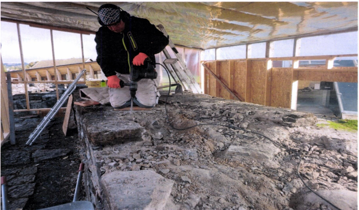
Søren meisler toppdekket i seksjon 3. Vernebygget står uten vegger til den støvete jobben er unnagjort.
