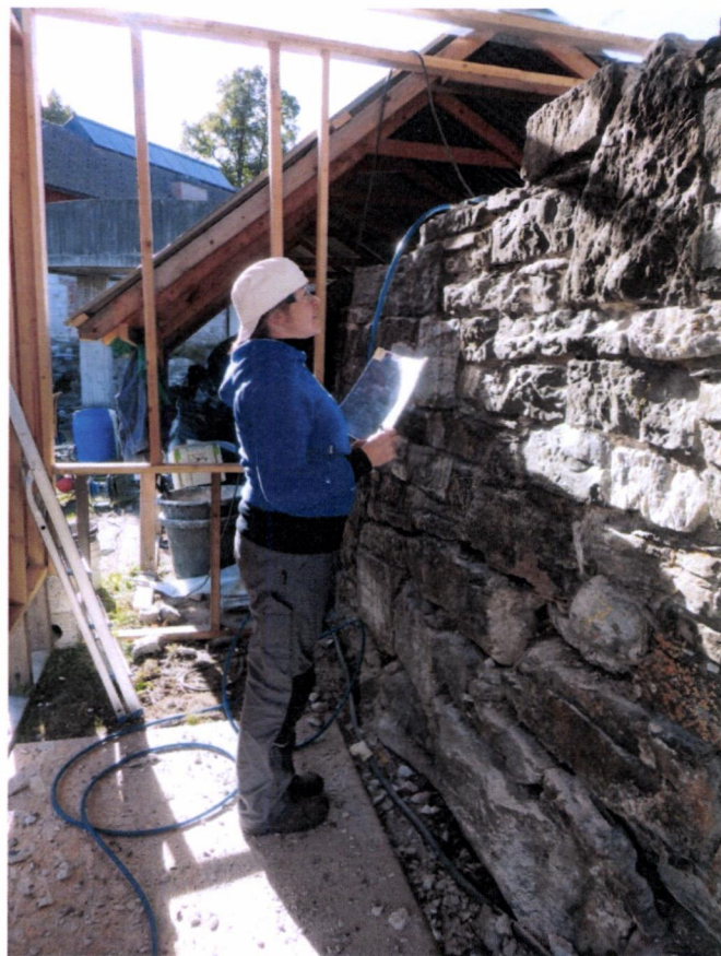
Anne K nummererer og lager fotokart over steinene i seksjon 3 av østre vange før demontering av vengene begynner.
