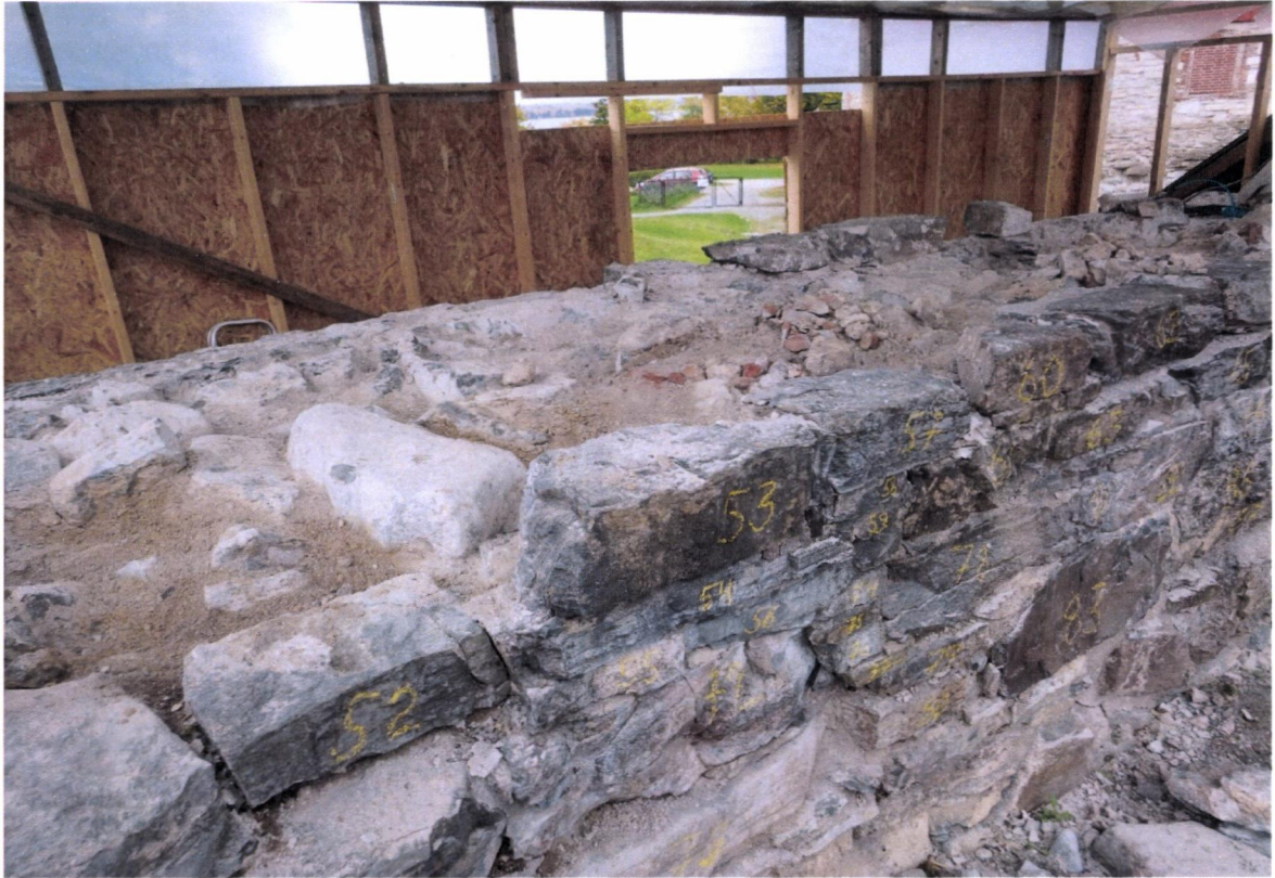
Kalkmørtel og murstein av middelalderformat kommer til syne i kjernen, som ligger høyt i murverket.
