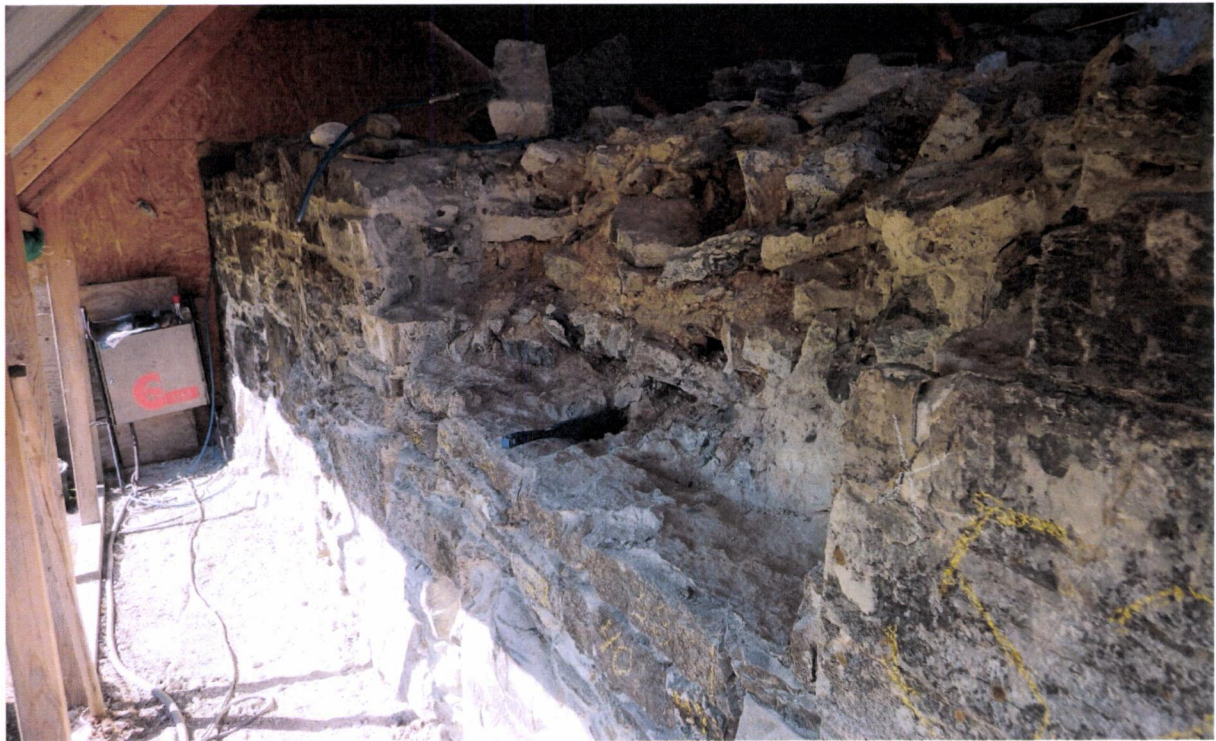
Den gjenoppmurte østsvangen i seksjon 2 er over 60 cm dyp, nesten helt ned til bakkenivå.
