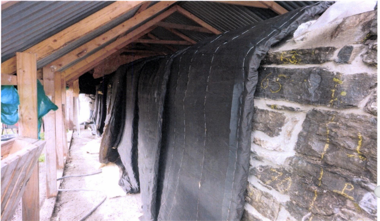
Den konserverte seksjon 2 er godt pakket inn og klar for vinteren!
