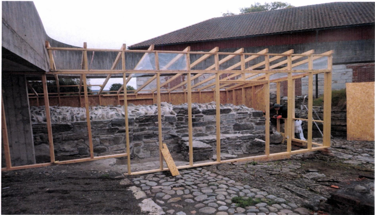
Demontering av vintervernebygget i seksjon 1 av ringmuren.
