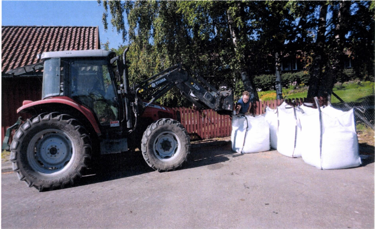
Museumsmurere gjør det meste selv! Etter mottakelse av sand til ruinprosjektet på Domkirkeodden måtte ti tonn sand omplasseres til egnet sted på museet!
