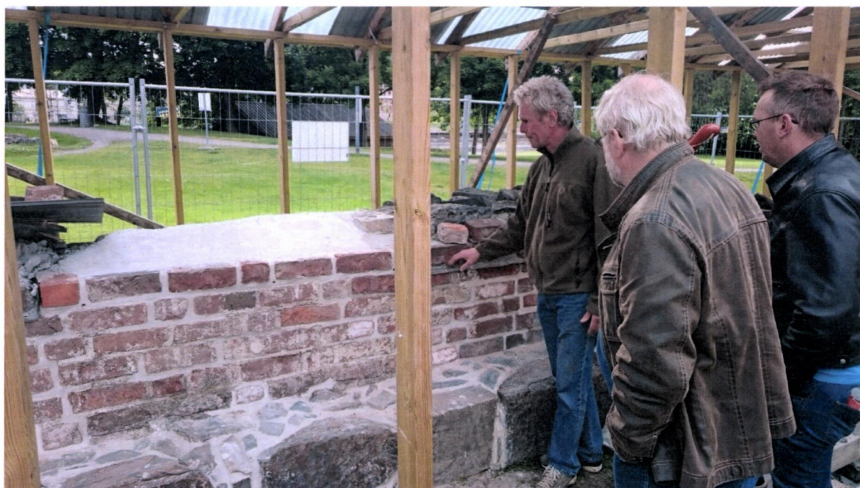
Befaring hos muremester Terje Berner i juni for å se på konserveringsmetoder ved skadet murstein.
