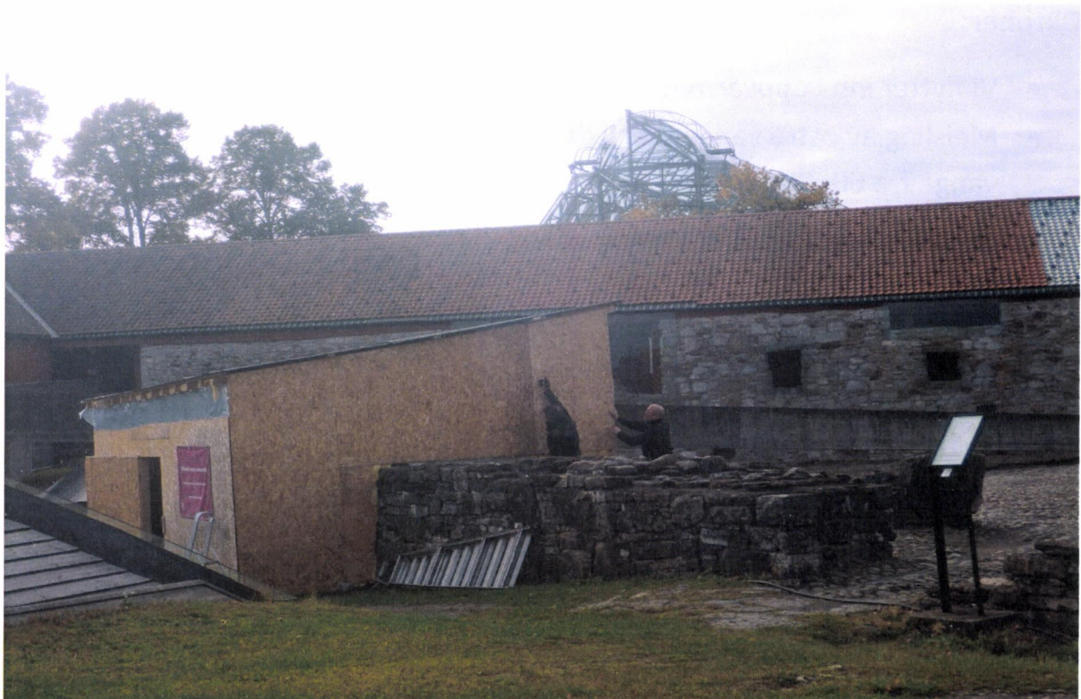
Vernebygget er flyttet og bygd om etter bakkenivået! Det står nå i seksjon 3, ca. 7,5 m nord for betongbrua. Ruinen har 1,20m høyde i vest inn mot borggården, men er ca. 2,50m høy på østsiden.
