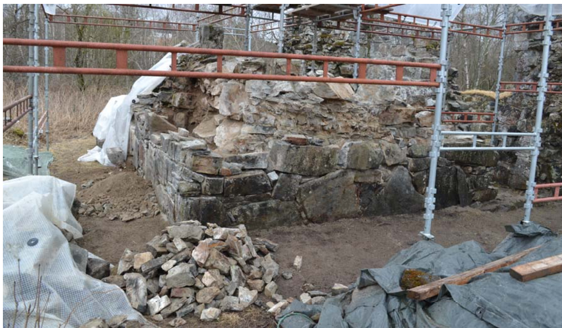
Foto 20050627_006 Munkeby klosterruin, nordre tverrskip under arbeid 2015
