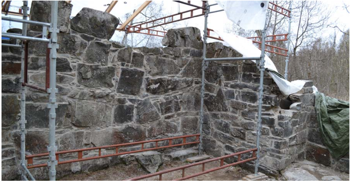
20050627_019 Nordre tverrskip's østre og nordre vegg innvendig ferdig spekket.
