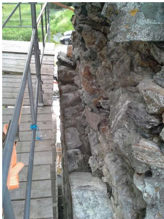
Foto 20050724_003 og 006 Bildet til venstre viser detalj under muring mot kjerne på vestre side av veggen. Bildet til høyre er under tilbake muring sett fra oven.
