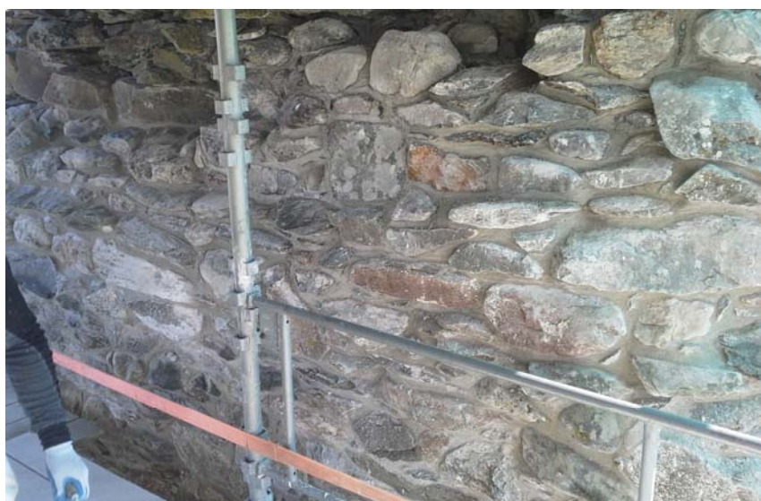
Foto 20050724_003 og 006 Bildet til venstre viser detalj under muring mot kjerne på vestre side av veggen. Bildet til høyre er under tilbake muring sett fra oven.
