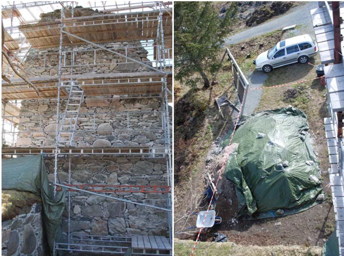
Foto 20050721_009 og 018 Hele veggen meislet og rengjort før demontering. Bildet til høyre viser oppløst fugemateriale og sementfuger som er fjernet i løpet av årene siden 2009.
