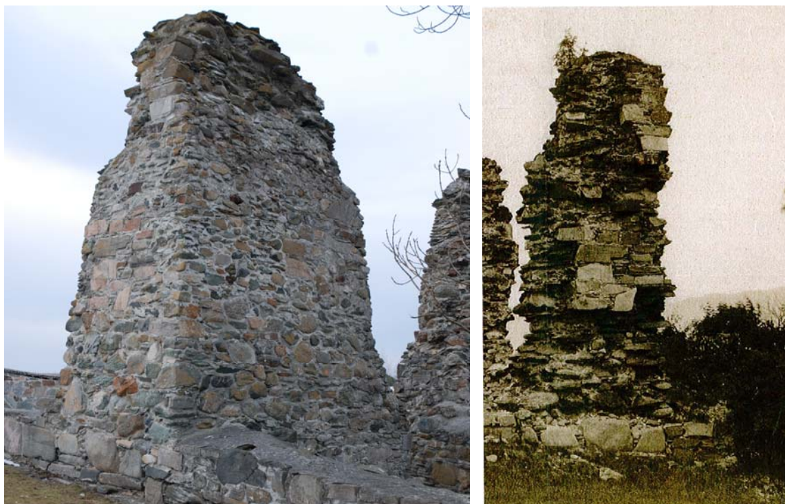
Tautra klosterruin: Bildet til venstre viser nord østre hjørne av koret før inngrep i 2010. De litt større og rødlige steinene i murverket ser ut til å være originale steiner, mens de mindre steinene er rekonstruert murverk. Bildet til høyre er fra riksantikvarens arkiv og viser et eldre foto av østsiden av samme vegg. Ut i fra bildet sees tydelig hvor deler av murverket er rekonstruert.
