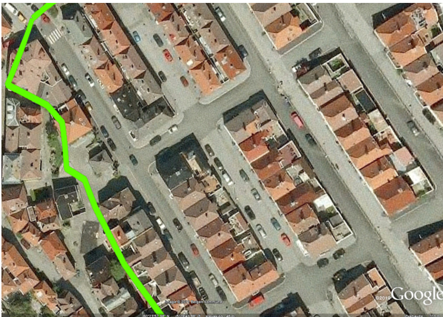
Rekehustypologi - Krohnengen/Wesselengen. Bilde fra Google.
