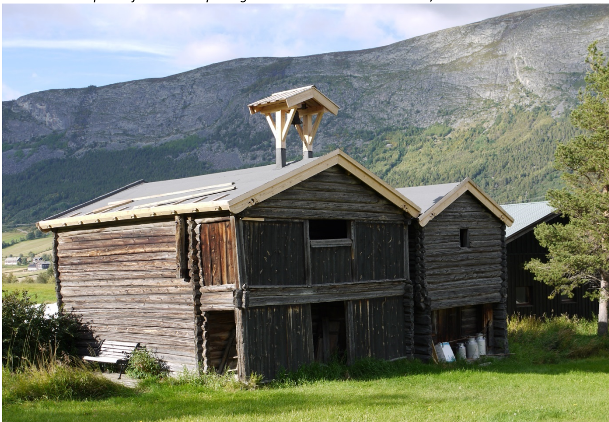
05130001049: Stabbur og loft er statusbygninger på gårdstunet og har gjennomsnittlig bedre vedlikehold enn de andre typene av mindre uthus som ligger i tilknytning tunet. Her er takene fornyet etter stormen Dagmars herjinger i Skjåk i julen 2011. Foto: Å. Dammann/NIKU 2012
