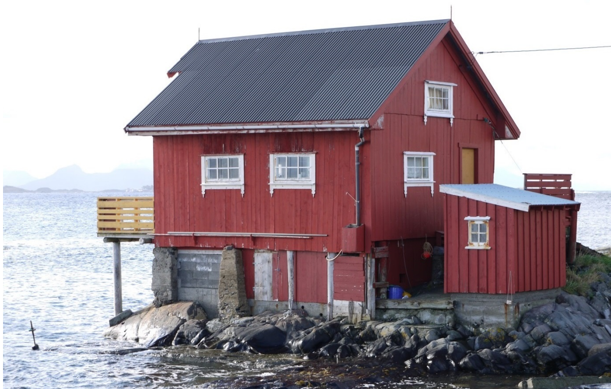
1548019063: Øyværene Søndre og Nordre Bjørnsund i Fræna kommune er fraflyttet, men bygningene i de tidlige fiskeværerne holdes i hevd som fritidseiendommer. Foto: K. Fageraas/NIKU 2010
