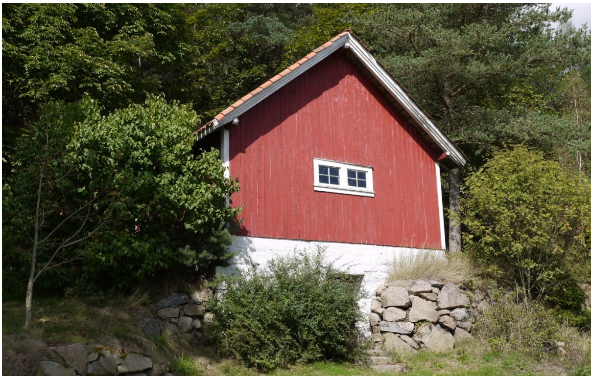
01150102014: Jordkjellere som ligger perifer på gården er utsatt for tap og forfall, mens kjellere som ligger i tilknytning til gårdstunet har større brukspotensial og dermed bedre odds for bra vedlikehold, slik som denne potetkjelleren i Sarpsborg kommune. Foto: Å. Dammann/NIKU 2014
