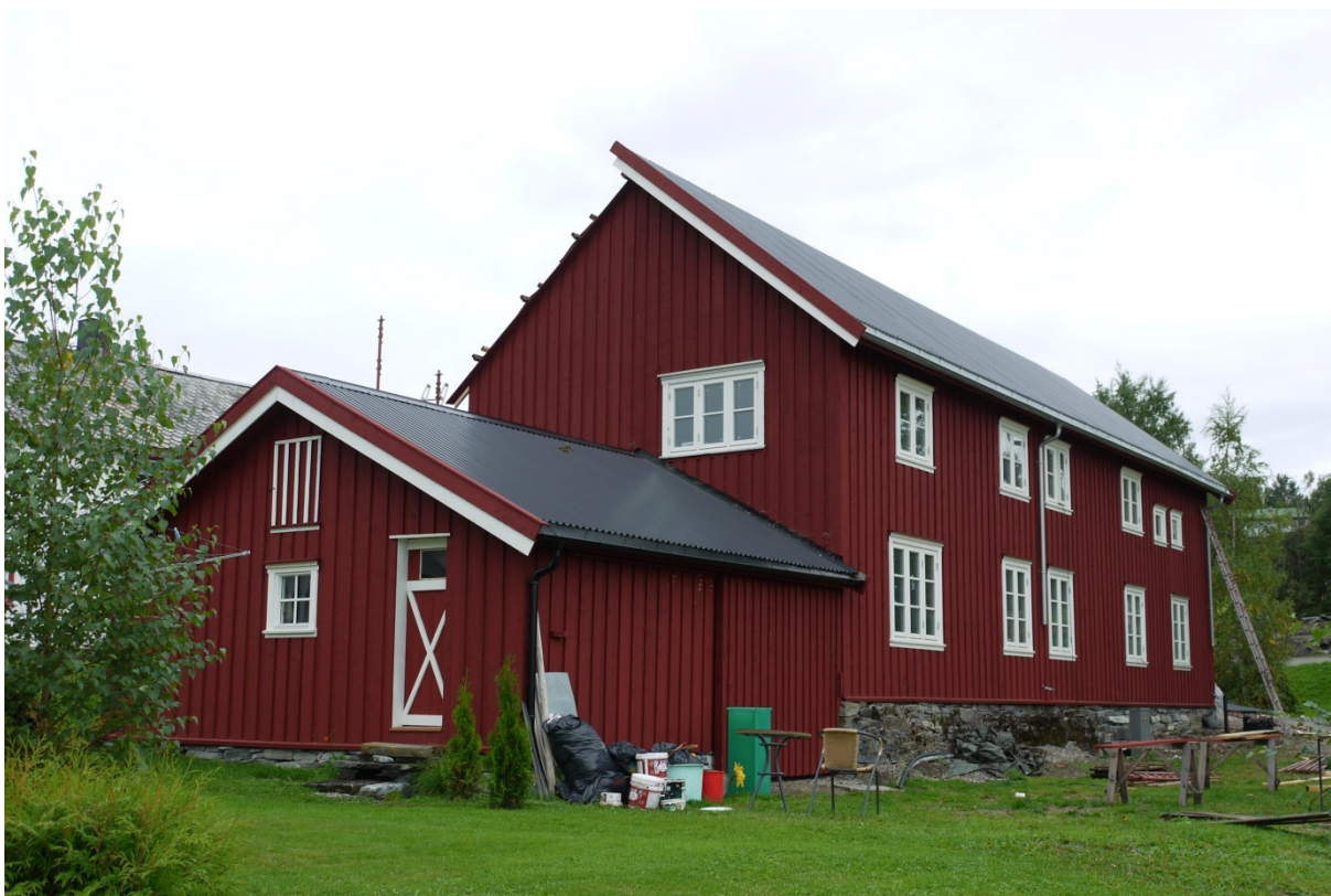
17360003026: Undersøkelsen viser en sammenheng mellom endringer og god bygningstilstand. En større andel av de endrete bygningene enn av de uendrete er i god stand (95 % mot 80 %). Mye bra vedlikehold inngår i kategorien C-endring, som her i Viosen i Snåsa. Foto: Å. Dammann/NIKU 2013
