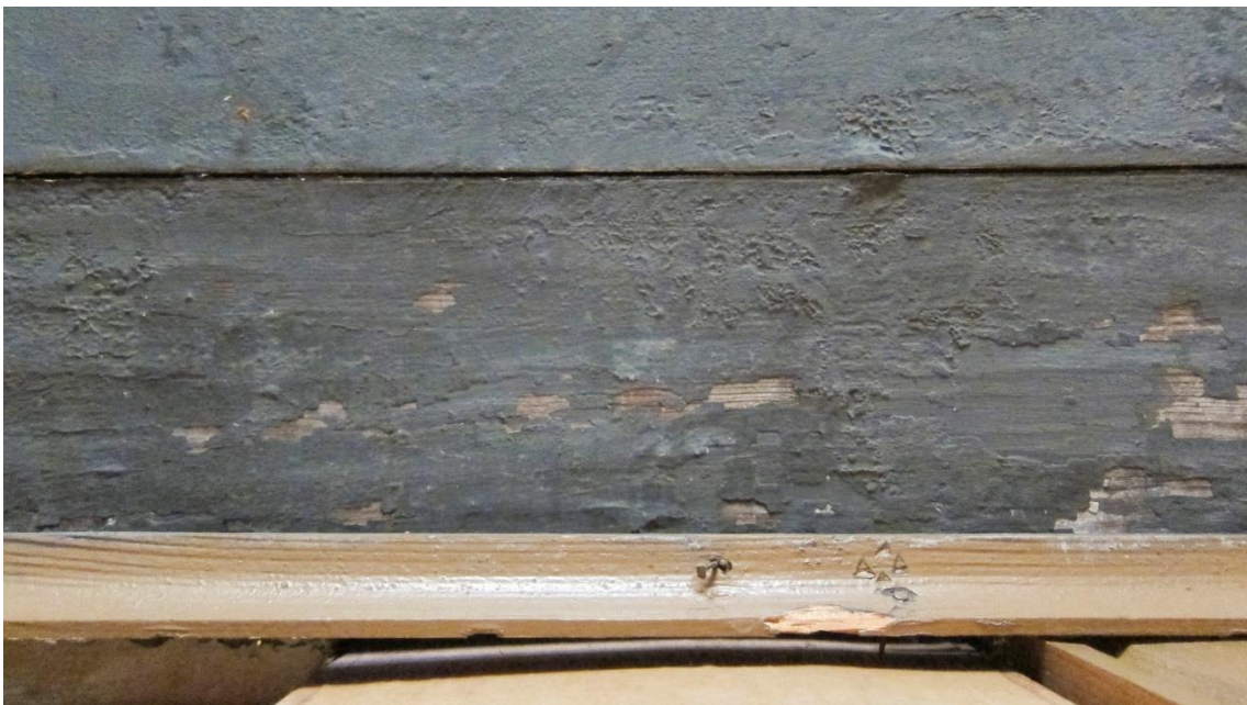
FLESBERG Området etter konsolidering med størlim, fotografert etter to dager.
