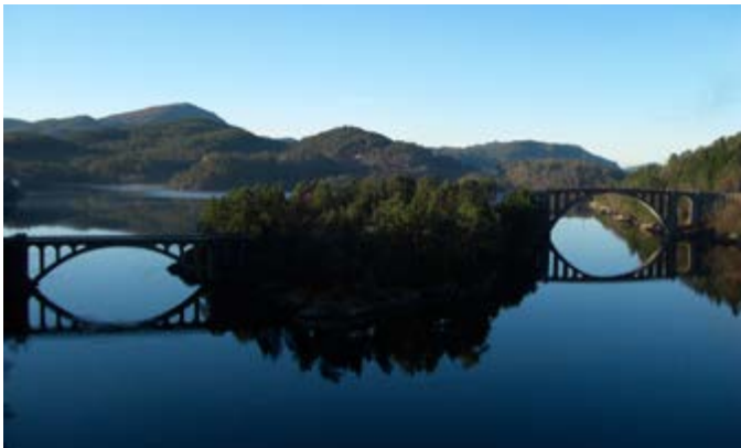
Skodjebruen i Møre og Romsdal er en del av landsverneplanen for Statens vegvesen. Broplanene ble utarbeidet av overingeniør Hovenak ved vegkontoret i Molde. De to hvelvbruen fra 1922 består av tørrmurte brokar i naturstein, og selve hovedspennet er i murt huggen stein.
