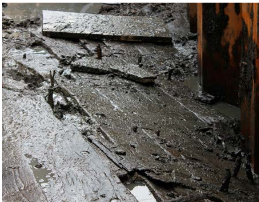
Vraket er delt av spuntveggen som må settes ned for å kunne grave opp massene i denne delen av Oslos havneområde. Her ser man bordkledning og trepluggene som har føyet skipet sammen. Foto: Linn Olsen Evjen
