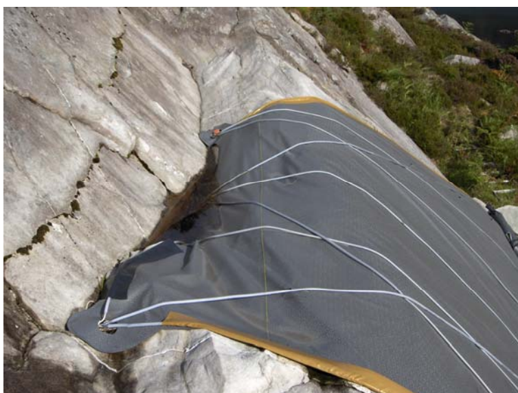
Figur 50. B) Rustfrie vaiere er strukket mellom festepunkt festet utenfor selve ristningsberget. Foto: K. Gran.
