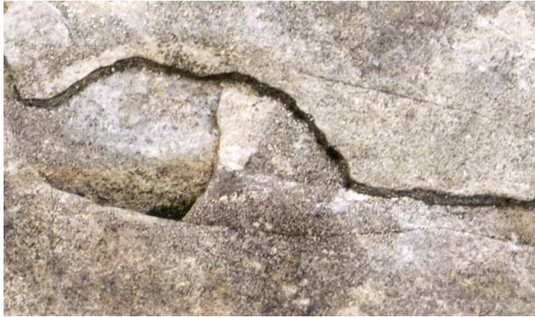
Figur 58. For å isolere sårkanter og hindre videre oppsprekking og avspaltning er det vanlig å fuge kanten av sprekkene med sement. Foto: L. Sæbø.
