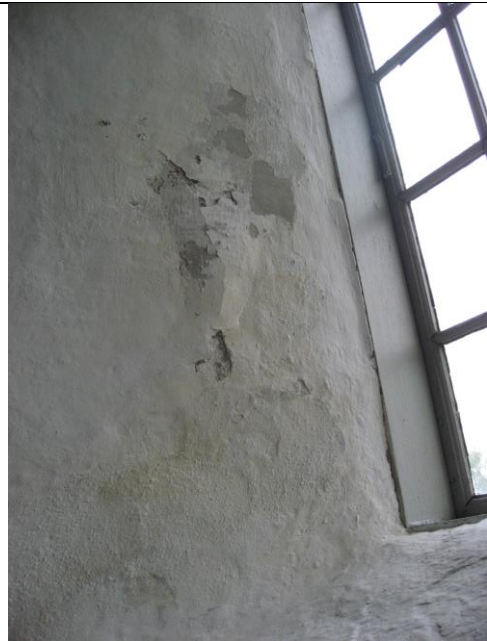
Bilde 9. Avflassing av puss innvendig på korets yttervegg mot sør.
