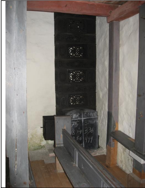
Bilde 11. Grønske innvendig i nedre del av skipets østre del av yttervegg mot nord.
