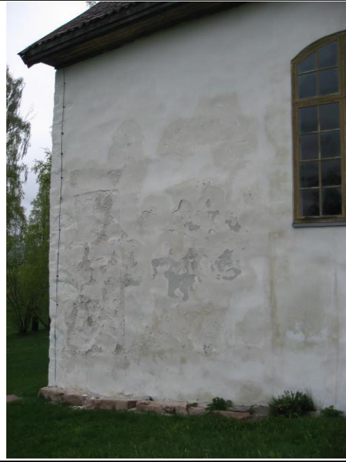
Bilde 8. Avflassing av puss på sørfasaden.
