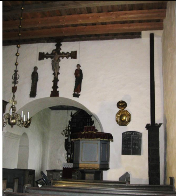
Bilde 16. Skipet sett møt øst og inn i koret. Den første ovnen ble installert i 1832. De nåværende ovnene ble gitt som gave i 1868. Det var påfallende lite rust på ovnene. Lysekronen er fra 1600-tallet.
