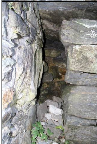
Figur 13: Over: Eksempel på åpninger i den tørrmurte forblendingsmuren mot vest. Åpningen viser hvor langt inn sørmuren i rom 1 strekker seg (Foto: Byantikvaren, Bergen kommune). Venstre: Nærbilde av åpningen mellom sørmuren og tørrmuren mot vest (Foto: Byantikvaren, Bergen kommune).
