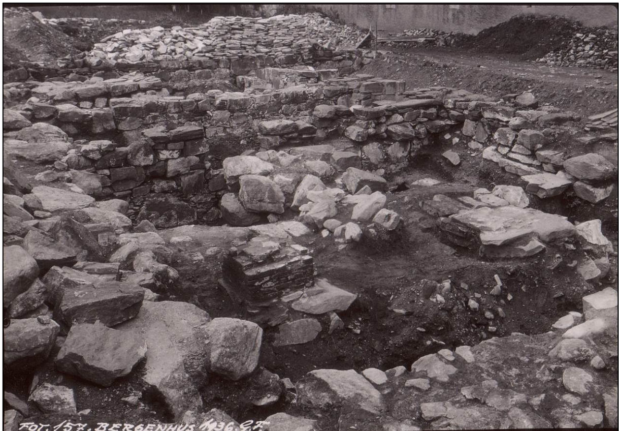
Figur 32: Historisk foto som blant annet viser nordmurens innerliv i rom 1. Øverst på muren ligger 2 skift med nyere påbygning på murene er fjernet i forhold til dagens situasjon (Foto: Fischer, Foto 157, 1936).
