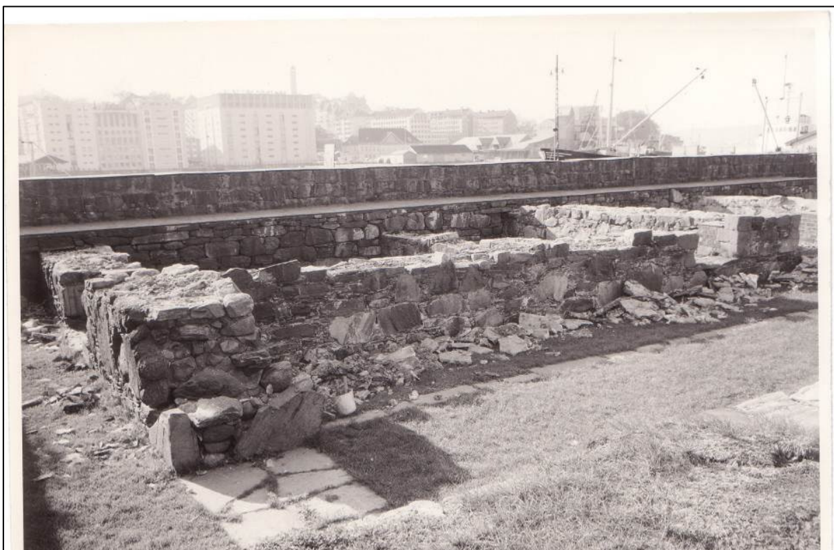
Figur 10: I 1970 ble det satt i gang et stortilt arbeid med å rense murkronen for torv og sement. Fugene ble også rensset. Toppdekningen er meislet av og ligger på bakken langs ruinen (Foto: «Fischerarkivet», Riksantikvaren).
