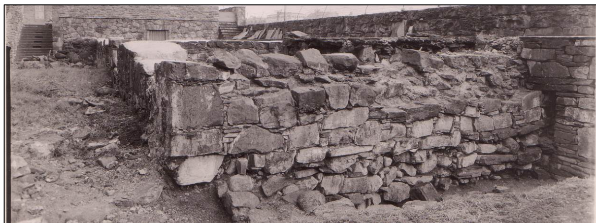
Figur 52: Historisk foto av sørmuren i rom 4. Viser at det ble gravd betydelig dypere enn dagens bakkenivå. Da store deler av murlivet mangler på dette bildet, er således dagens situasjon en rekonstruksjon (Foto: Fischer, foto nr. 70, 19.06.1961).
