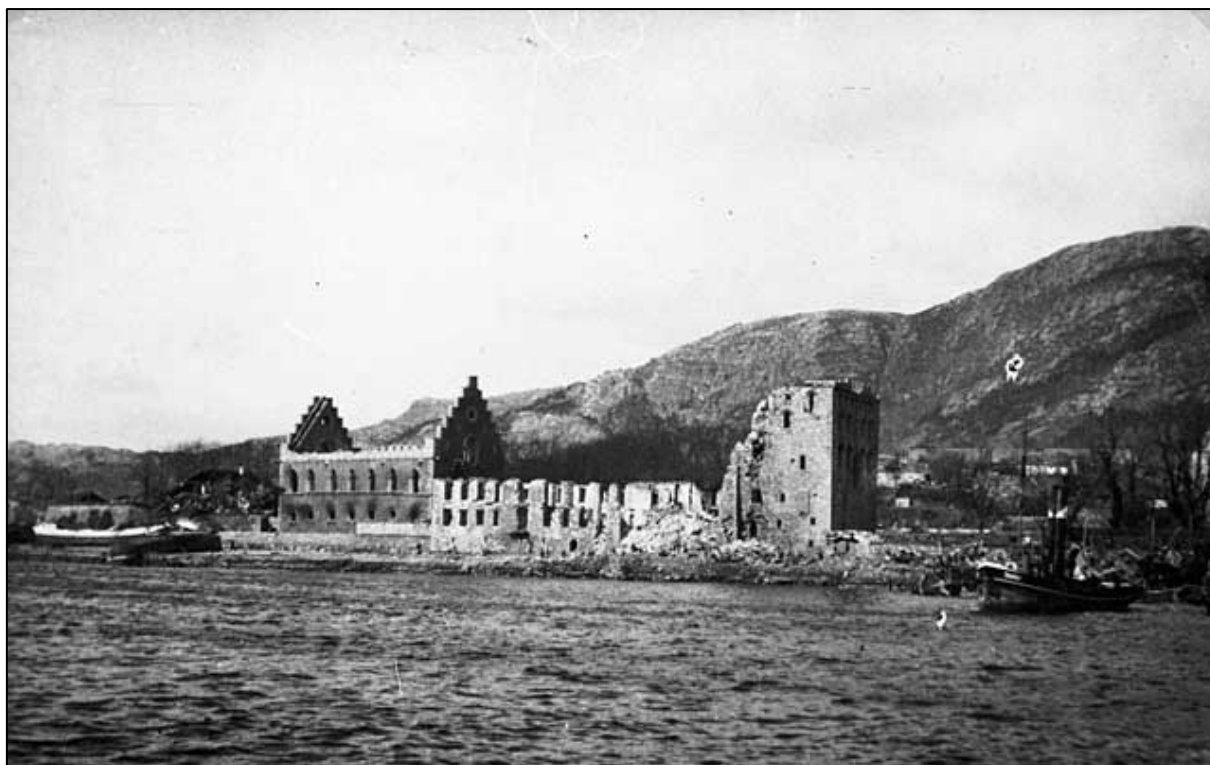
Figur 8: Det var omfattende skader på Bergenhus festning etter eksplosjonsulykken i 1944 (Foto: UBB-OHK-018/067, Billedsamlingen, UiB).
