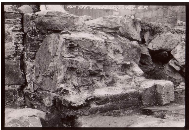
Figur 23: Østre vange i portal C med opprinnelig rest av teglsteinsvangen. Bildet viser også tydelig hvordan den østre langmuren ikke er murt i forband med sørmuren (Foto: Fischer, 1936:188).
