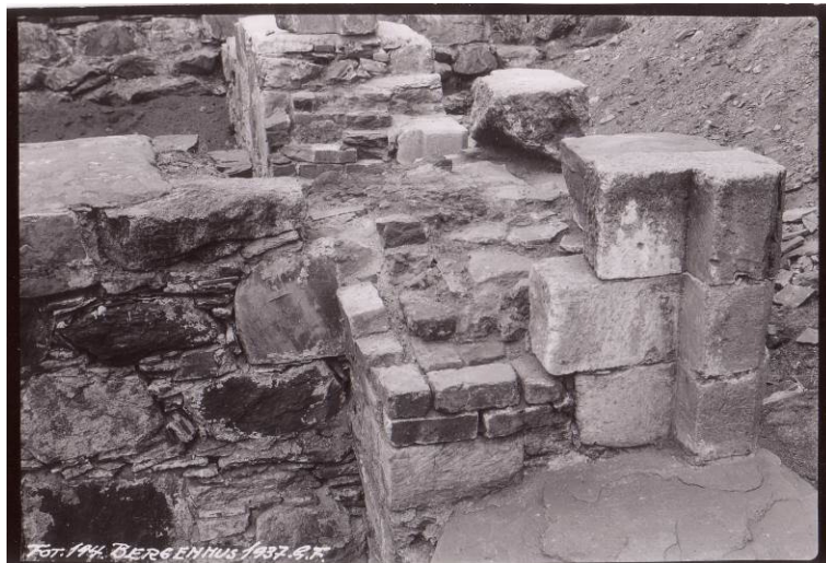
Figur 40: Nordvangen i portal B etter at markeringen er fjernet og før restaurering med ny teglstein (Foto: Fischer 1937:194).
