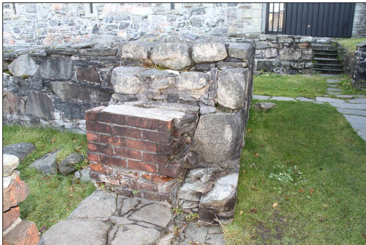
Figur 16: Ruinen etter Den andre steinhallen er spesiell ved at det er benyttet teglstein i portavangene. Til forskjell fra på Østlandet ble det i Bergen benyttet svært lite tegl i bygningene på 1200-tallet (Foto: Byantikvaren 2011).
