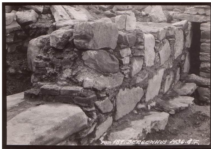
Figur 24: Vestre vange i portal C med opprinnelig rest av teglsteinsvangen. Bildet viser også tydelig fundamentene som sørmuren er reist på (Foto: Fischer, 1936:189).
