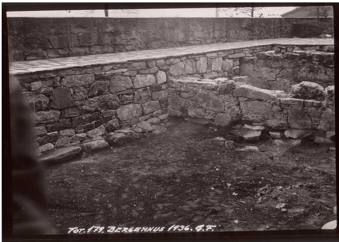
Figur 6: «I søndre rum etter at alle nyere bygningsrester var tatt vekk, hellegang lagt langs gjerdemuren mot kaien og et skall av tørrmur bygd foran den uregelmessige bakmuren under. Hellefundamentet fra ringmuren stikker frem under det nye skallet» (Fischer: fortegnelse over fotografier 1936). Dette var før murene fikk krone med torvdekning. Dette var på plass i 1937, se figur 7.
