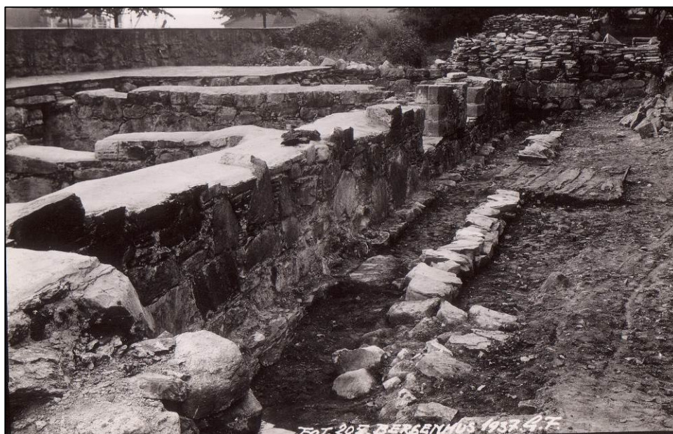
Figur 26: Bilde fra utgravingen av østre langmur viser tydelig fundamenter langs murlivet. Fischer tolker steinrekken som ligger parallelt med muren som mulige fundamenter (Foto: Fischer, 1937:205).
