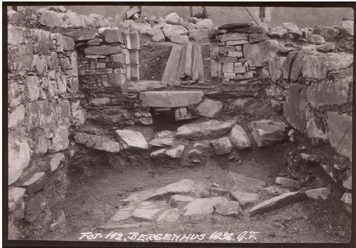
Figur 38: Østmurens innerliv i rom 2. Fundamentene er synlige. I forgrunnen er det eldre fundamenter som strekker seg nord-sør. Under portal B er det en gjennomgående stikkrenne. Blix har stablet opp stein som markerer vengene (Foto: Fischer 1936:192).
