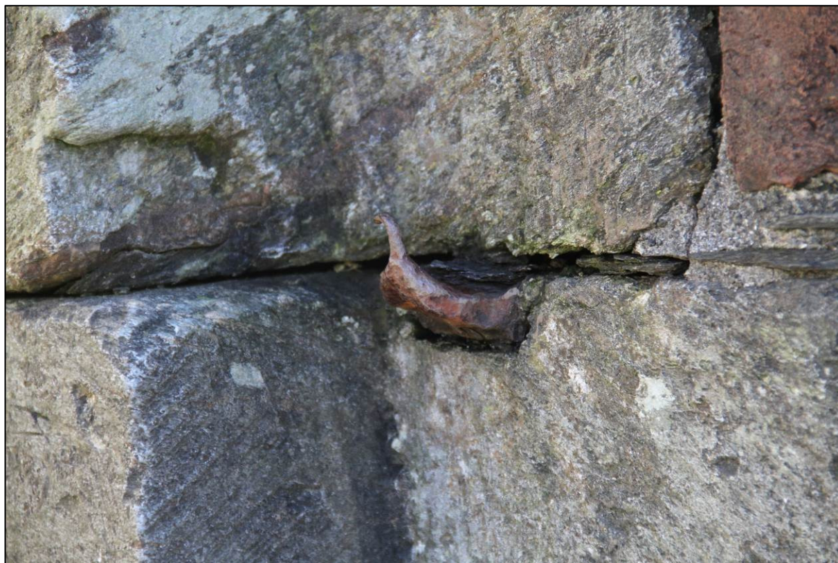
Figur 37: Innfelt i kleberkvader i sørvangen i portal B står det igjen en rest etter et hengsleanheng (Foto: Byantikvaren, Bergen kommune 2013).
