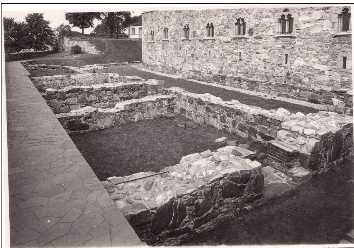
Figur 11: I 1971 stod anlegget ferdig. Fugene og kronen er spekket og anlegget fremstår slik som i dag. Siden dette er det ikke utført noen kjente tiltak på ruinen (Foto: «Fischerarkivet», Riksantikvaren).
