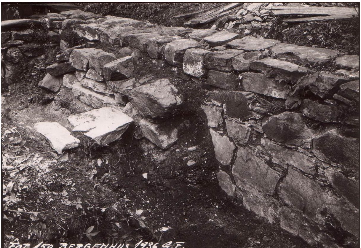
Figur 30: Østmurens innerliv i rom 1, mens Fischer jobbet med å fjerne et indre murskall. De to øverste murskiftene som er fjernet i forhold til dagens situasjon er Blix sin markering av muren (Foto: Fischer 1936: 150).
