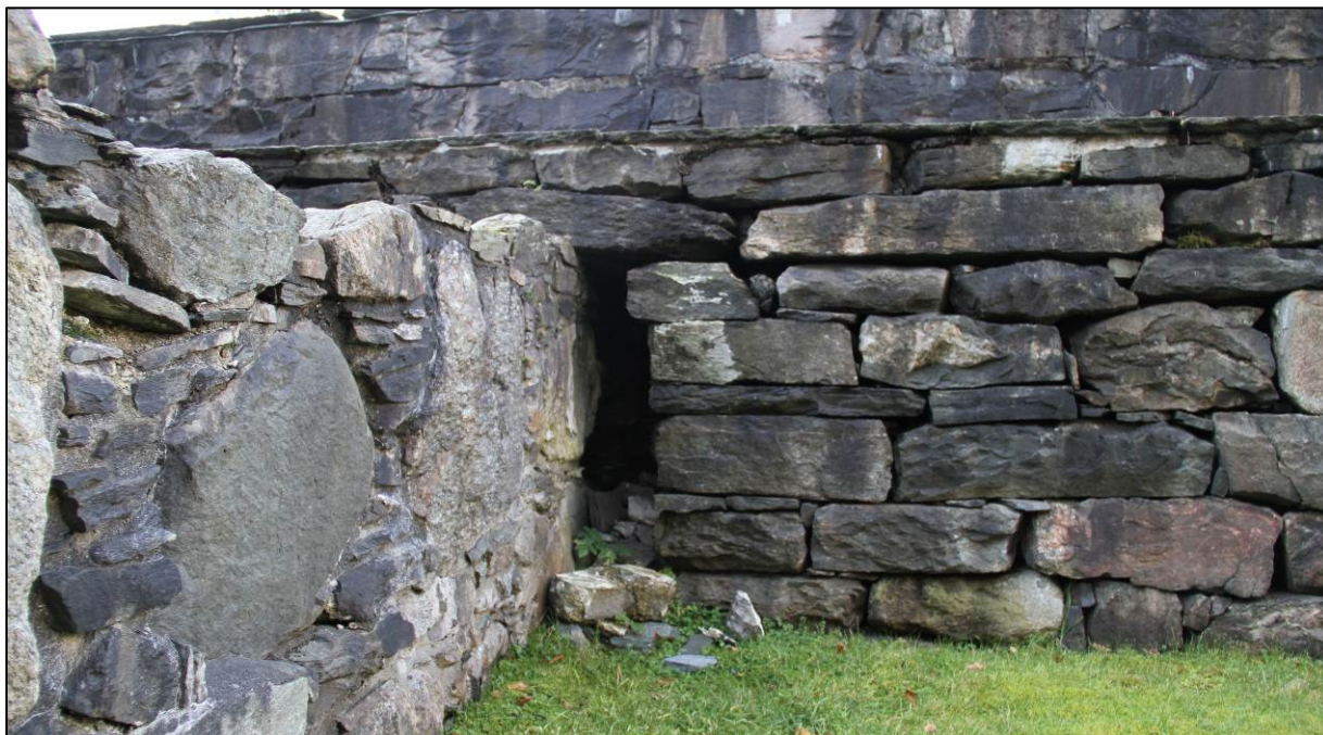
Figur 13: Over: Eksempel på åpninger i den tørrmurte forblendingsmuren mot vest. Åpningen viser hvor langt inn sørmuren i rom 1 strekker seg (Foto: Byantikvaren, Bergen kommune). Venstre: Nærbilde av åpningen mellom sørmuren og tørrmuren mot vest (Foto: Byantikvaren, Bergen kommune).
