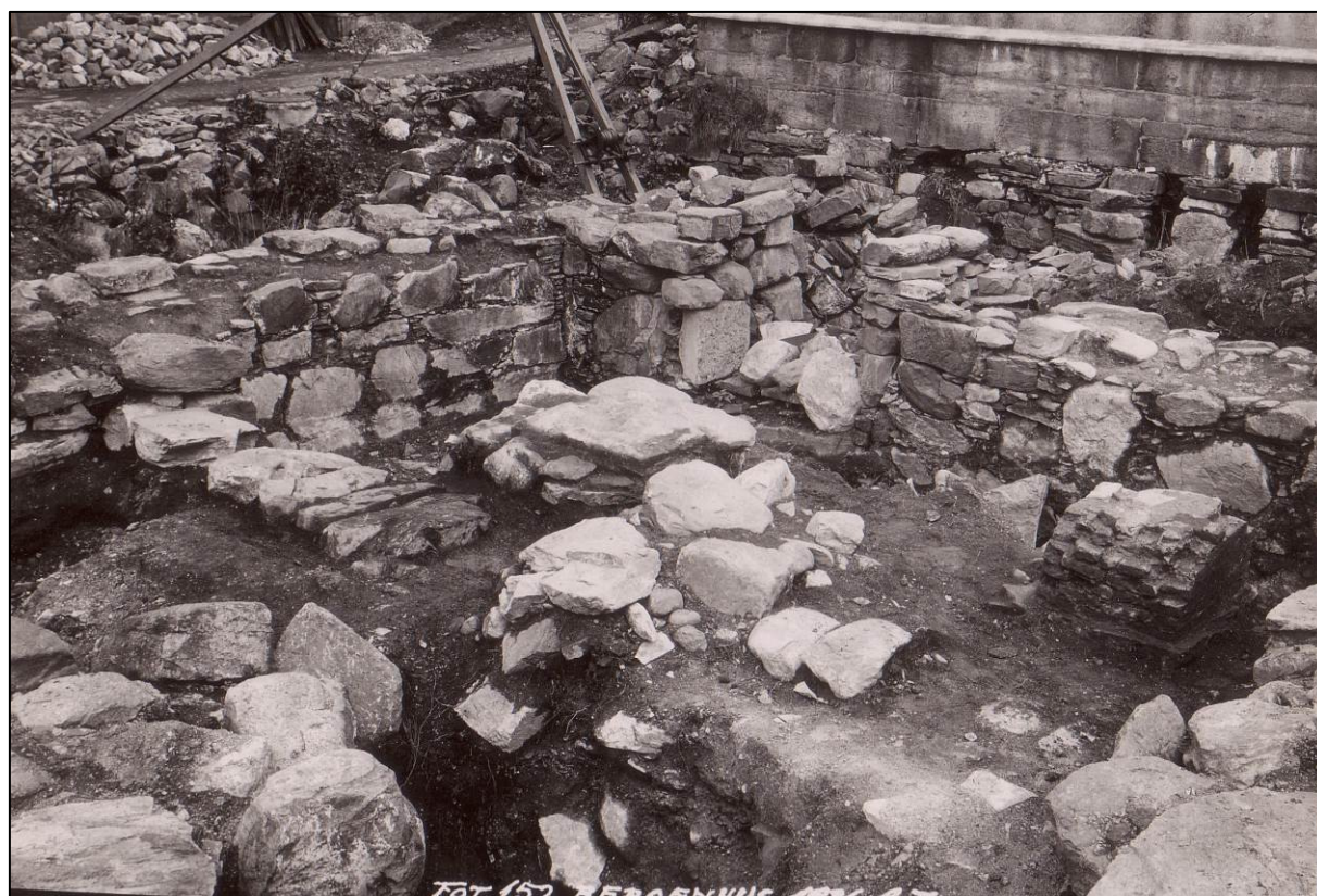
Figur 21: Historisk foto av sørmurens og østmurens innerliv i rom 1. Bildet viser blant annet at det står oppstaplet stein i portalens vanger: «...denne Døraabning har Kleberstens Indfatningsstene udvendig og indvendig og Teglstensmuring under Kleberstensindfatningen indvendig. Den underste Klebersten i østre, ydre Dørvange har en 3" bred Fas, og er Stenen skudt frem i Døraabningen foran de andre Stenes Flugt; de øvrige Kleberstene er uden Fas og sees de tidligere at have været benyttede andestedes, da de ere indsatte med sine finhugne Flader ind mod Geaastensmuren, og de raahugne Byg- og Ligflader synlige...» (Blix 1893 i Fischer 1939:234) (Foto: Fischer, Foto 152, 1936).
