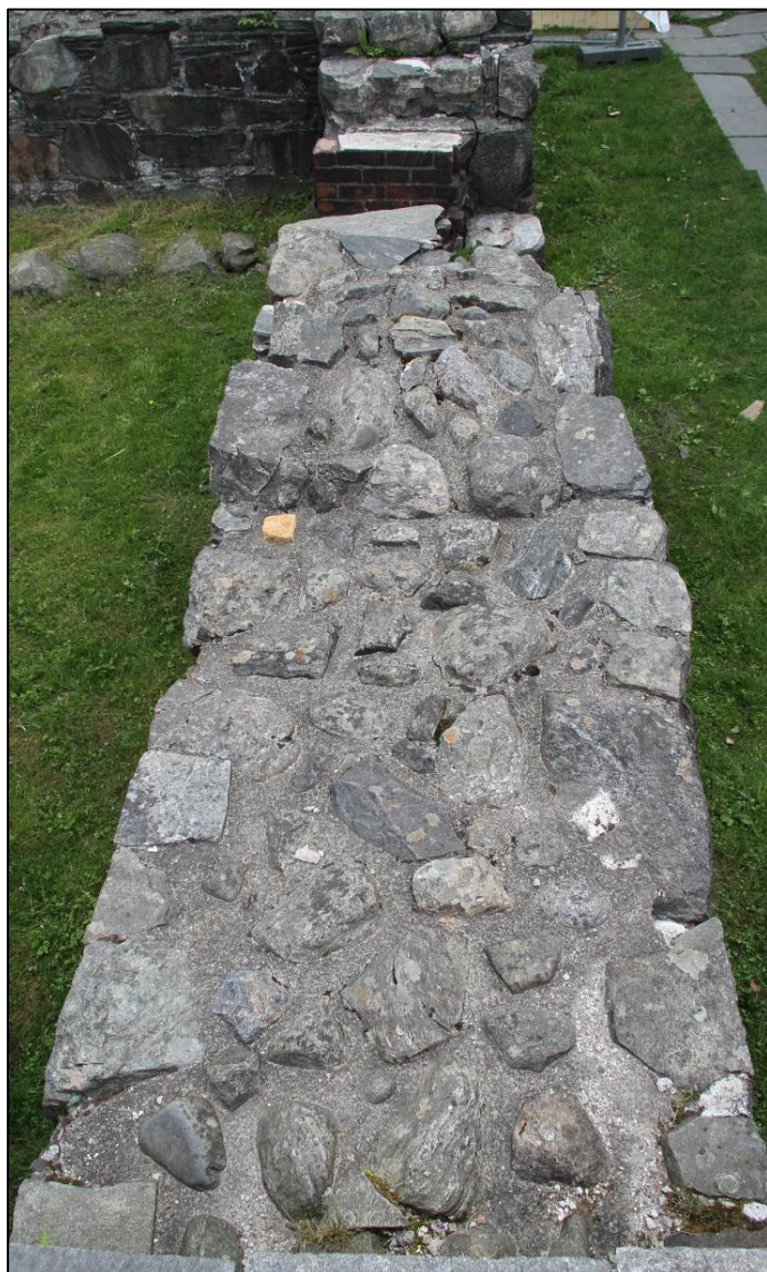
Figur 58: Eksempel på utforming av murkronen på Den andre steinhallen (Foto: Bergen kommune, Byantikvaren 2013).
