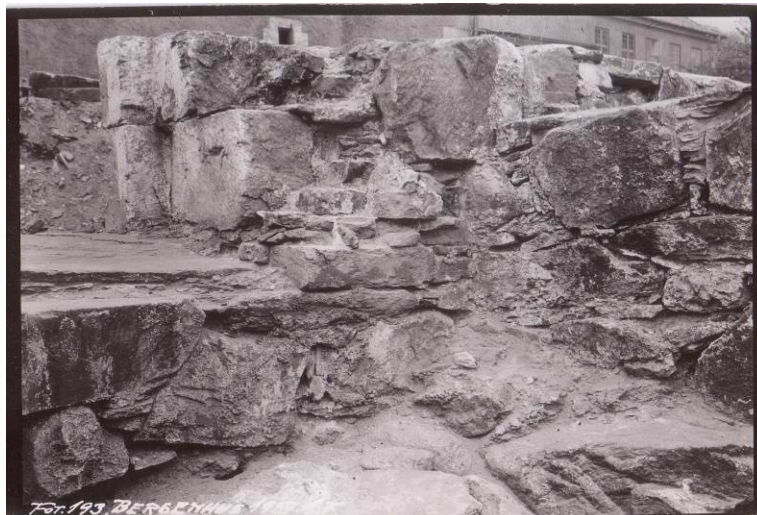
Figur 39: Sørvangen i portal B etter at markeringen er fjernet og før restaurering med ny teglstein (Foto: Fischer 1937:193).
