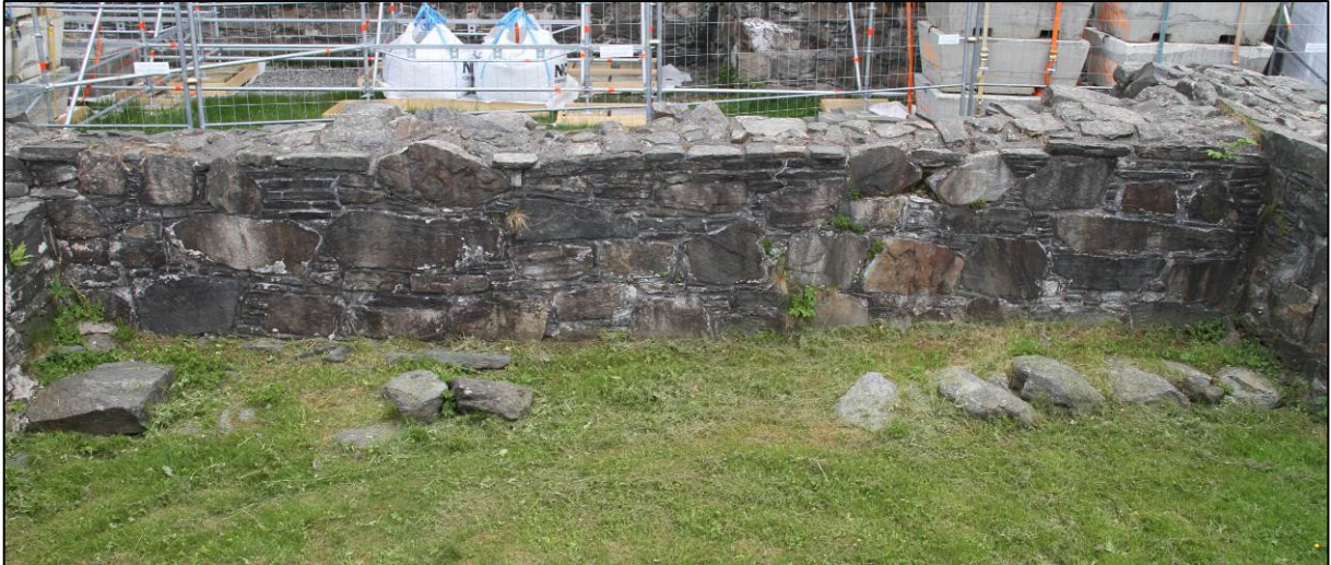
Figur 29: Østmurens innerliv i rom 1. Fundamentene er delvis synlige, og det er en rekke av stein parallelt innenfor. Inntil denne muren fjernet Fischer et nyere indre murskall, se figur 30 (Foto: Byantikvaren, Bergen kommune 2013).
