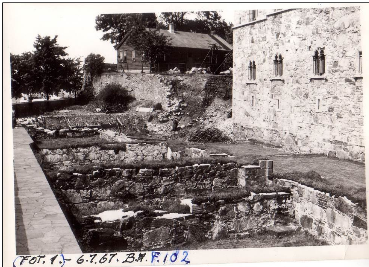
Figur 9: Den søndre delen av den andre steinhallen står fortsatt med delvis toppdekke av torv. Den store tverrmuren fra Håkonshallen er fjernet, og markeringen av den nordre delen er på plass. Foto fra 1967 (Foto: «Fischerarkivet», Riksantikvaren)
