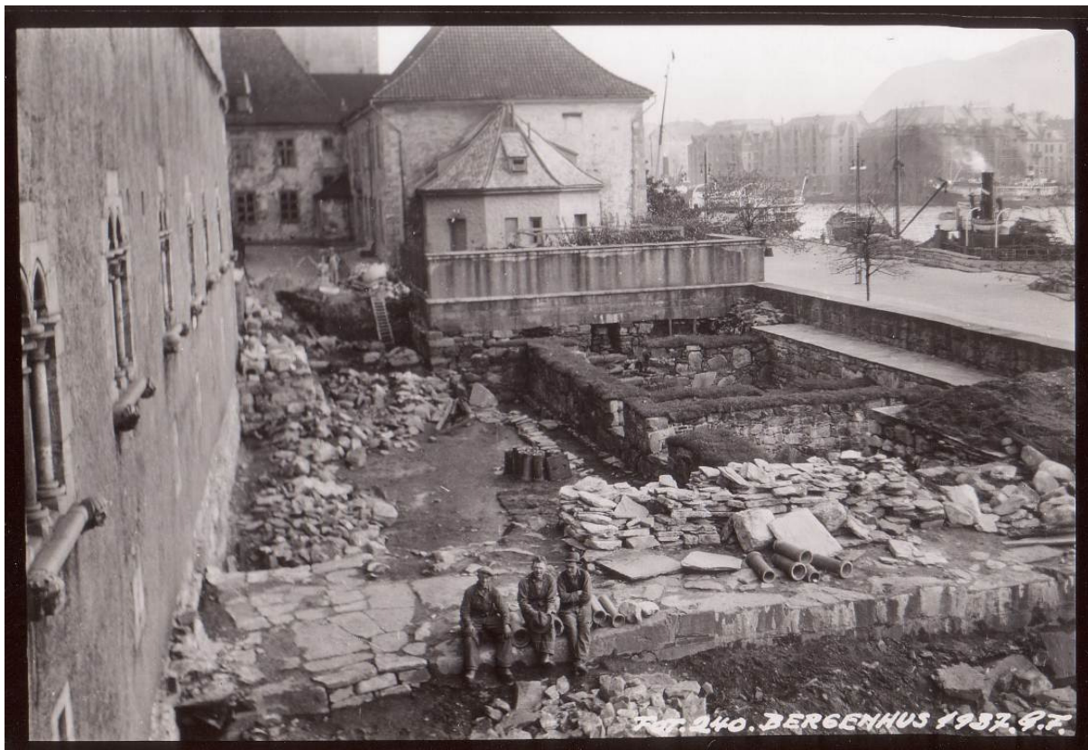
Figur 7: Den søndre delen av den andre steinhallen står avdekket. Ruinen har en toppdekning med torv. Den kraftige muren ut fra Håkonshallen, som arbeiderne sitter på, er fortsatt ikke fjernet. Den tre meter brede muren er en nyere tilføyelse som ble murt utenpå nordmuren i rom 3. Foto fra 1937 (Foto: «Fischerarkivet», Riksantikvaren).
