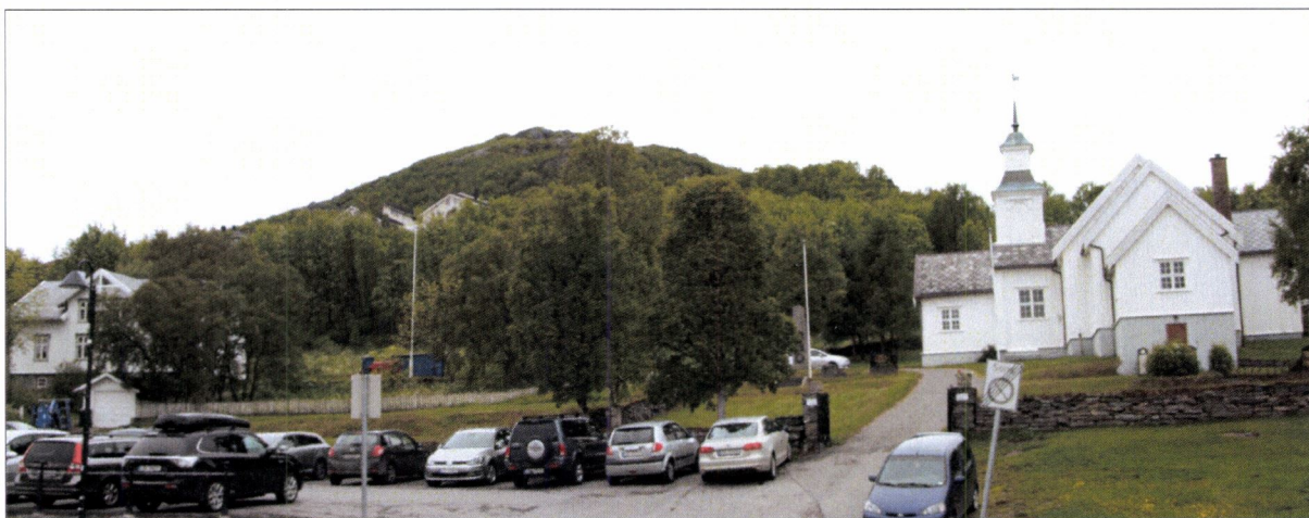
Fig. 8. Skjervøy kirke fra 1728 med den nedlagte kirkegården til venstre mellom kirken og prestegården (hvitt hus til venstre). Mellom det hvite prestegårdsgjerdet og den bakre rekken av biler skimtes en brunlig skråning, og denne utgjør den nedlagte gravplassens øvre avgrensing. Da parkeringsplassen ble etablert ble det påtruffet skjeletter i området ved den bakre bilrekken, og videre inngrep i gravplassen ble stanset. Foto: Jan Brendalsmo/NIKU.
