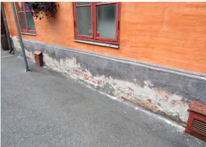
Mer nedbør kan føre til kraftigere saltutslag og saltkrystallisering. Foto: Andre Korsaksel © Riksantikvaren
