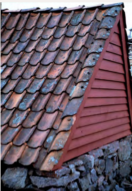
Takene bør gås over minst en gang i året: Er alle taksteinene på plass? Foto: Kjell Andresen © Riksantikvaren
