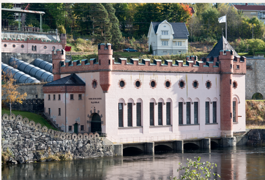
Kraftstasjonen Tinfos 2, tegnet av arkitektene Finn og Sverre Knudsen og satt i drift i 1912. Interiøret er bevart komplett med arkitektoniske detaljer, fire turbiner og annet teknisk utstyr. Foto: © Per Berntsen
