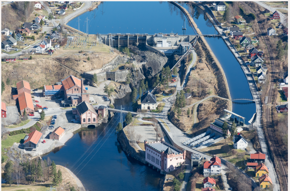
Tinfos kulturmiljø med tre generasjoner kraftverk: Til venstre for fossen Tinfos 1 (1901) bak i bildet Nye Tinfos 1 (1955), og foran til høyre Tinfos 2 (1912). Industribygninger rundt Tinfos 1, «Admini» midt i bildet og Holtakanalen til høyre med funksjonærboliger langs kanalkanten. Foto: © Per Berntsen
