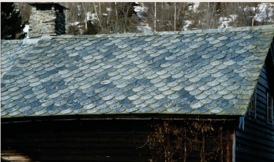
Lappskifer fra Mølstertunet på Voss. Foto: Kjell Andresen © Hordaland fylkeskommune
