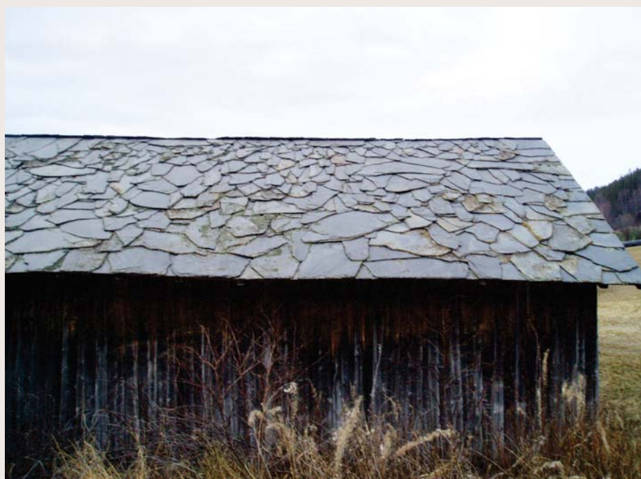
Villhelletak fra Ringebu. Villhelletakene i Gudbrandsdalen er de tetteste og best lagte i landet. Foto: Kjell Andresen © Hordaland fylkeskommune
