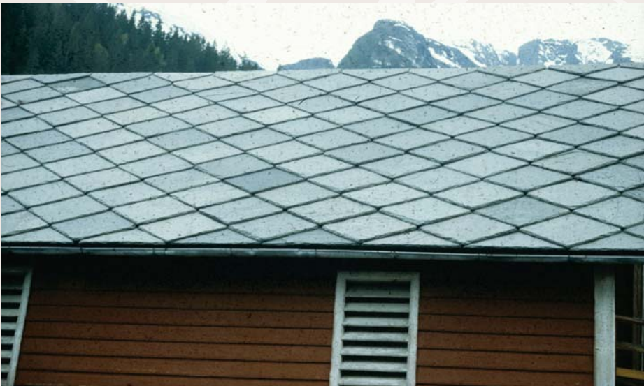
Ruteheller i Odda i Hardanger. Rutehellene er teknisk sett den mest perfekte form for helletekkning. Foto: Kjell Andresen © Hordaland fylkeskommune
