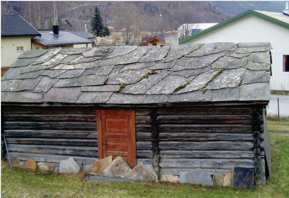
Hus på Otta med sidesua rasteheller. Nedbøren pleier å komme fra venstra mot høyre i bildet og da er taket tett. Foto: Kjell Andresen © Riksantikvaren
