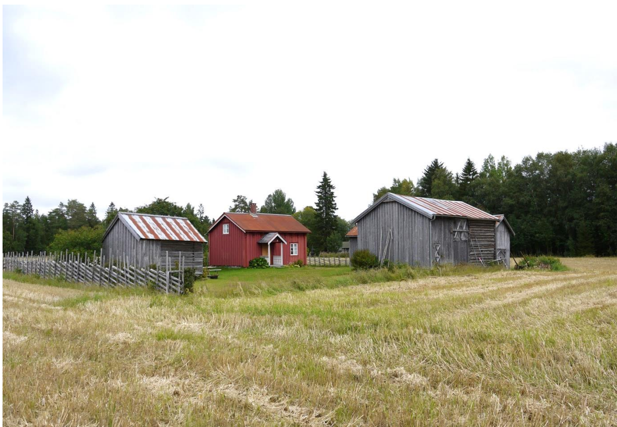
17360012035: Kontrollregistrering av SERFAK-bygninger i Snåsa kommune har blitt gjennomført i 2003, 2008 og 2013. På Sandmo er våningshus, fjøs og stall registrert som uendret og intakt gjennom alle tre omdrev. Foto: TD/NIKU 2013
