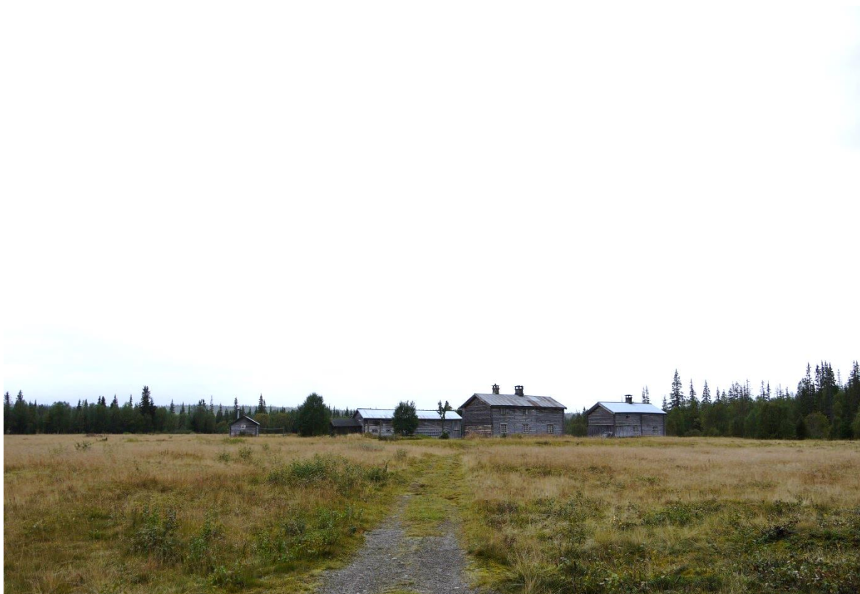
17360007032: Gressåmoen er en fredet fjellgård langt nordøst i kommunen, med bygninger fra slutten av 1700-tallet. På 1800-tallet var det mye trafikk mellom Snåsa og Lierne og mange reisende overnattet på gården. Foto: ÅD/NIKU 2013
