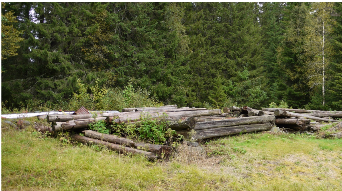
17360007046: Forfall er tapsårsaken for til sammen fem av SEFRAK-bygningene som er gått tapt i Snåsa i 3. omdrev. Foto: ÅD/NIKU 2013
