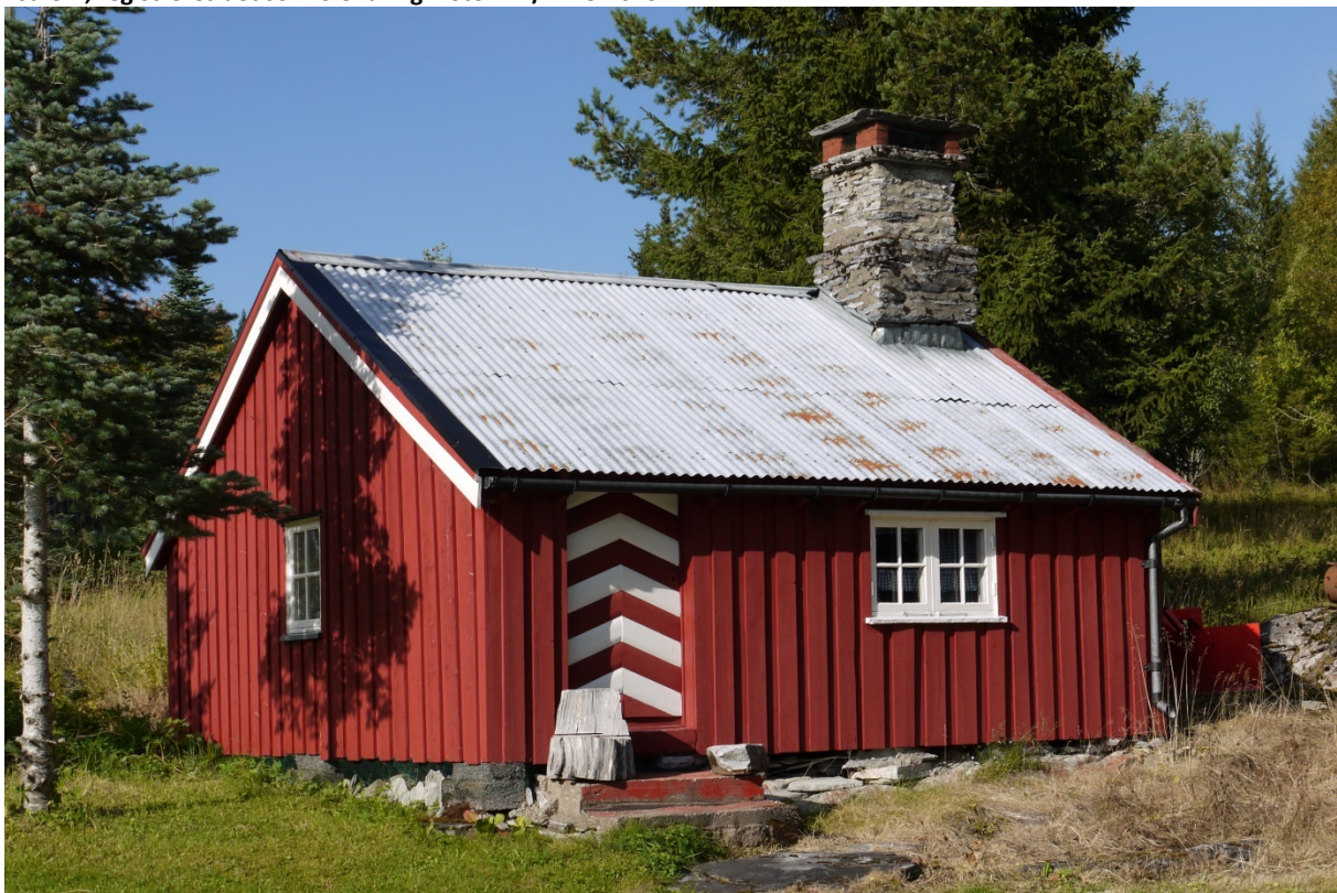
17360006014: Hvis bygningens karakter ikke er endret i forhold til foto fra den opprinnelige SEFRAK-registreringen, blir den registrert som uendret. Foto: ÅD/NIKU 2013
