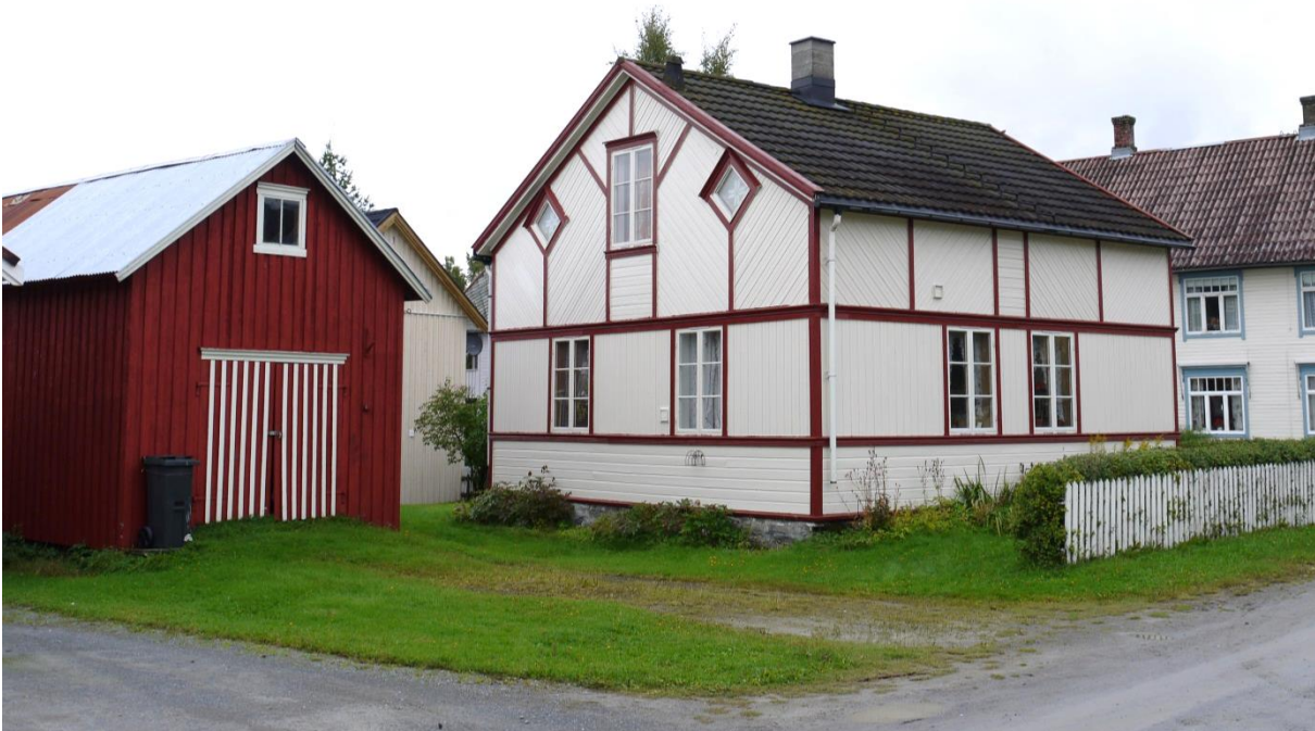
17360003021: I strandområdet øst i Snåsavatnet ligger Viosen, som var det gamle kommunesenteret Snåsa. Viosen er regulert til spesialområde bevaring. Foto: ÅD/NIKU 2013
