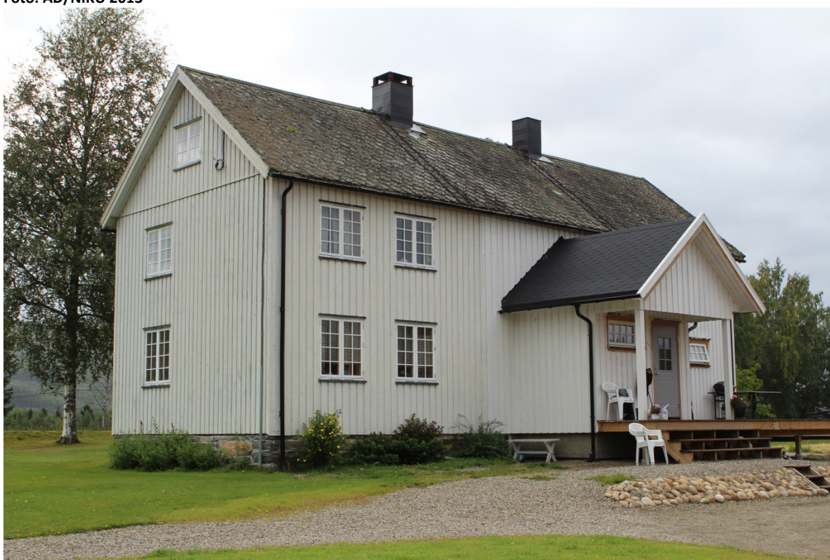
17360010059: Liten volumendring, for eksempel et tilbygd inngangsparti, registreres som B-endring. Foto: RM/NIKU 2013
