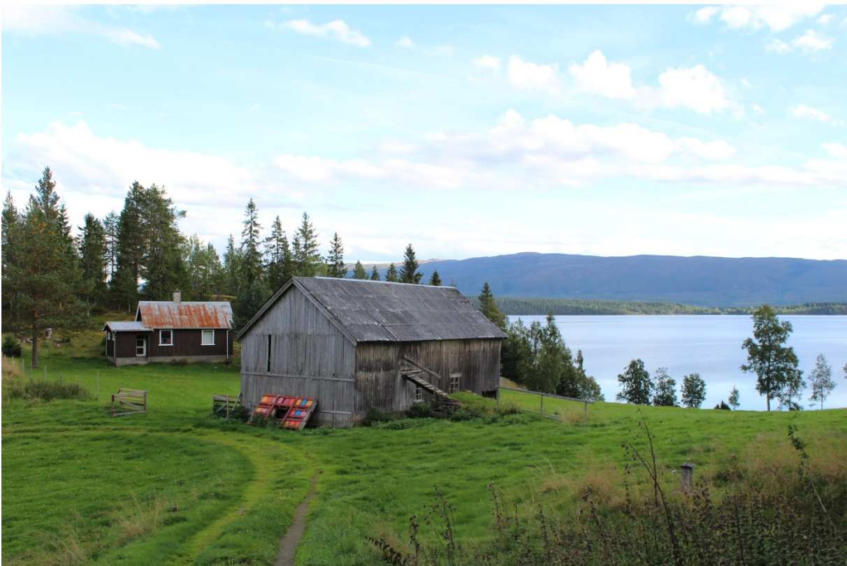
17360001037: Av de undersøkte SEFRAK-bygningene i Snåsa kommune ligger 56 % i områdene rundt Snåsavatnet, hvor andelen tapte og endrete SEFRAK-bygninger er noe lavere enn i skog- og fjellområdene. Foto: RM/NIKU 2013.
