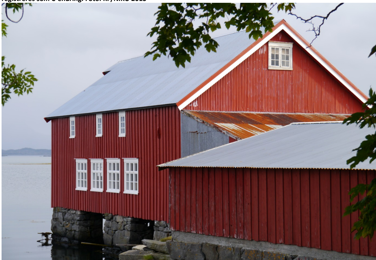
18150103012: Hvis bygningens karakter ikke er endret i forhold til foto fra den opprinnelige SEFRAK-registreringen, blir den registrert som uendret. Foto: KF/NIKU 2013
