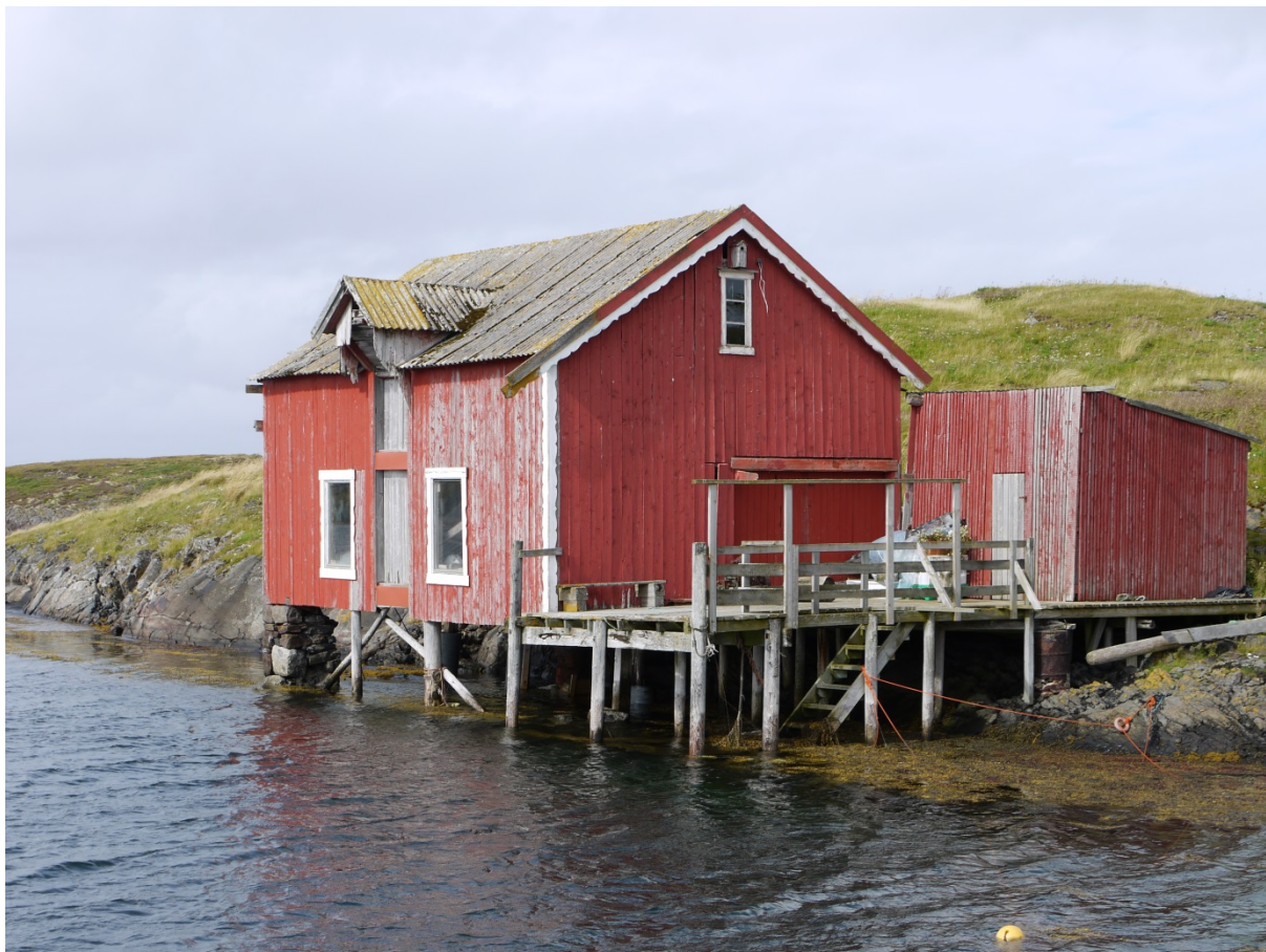
18150110095: I både 2. og 3. omdrev har tapsandelen vært høyere på småøyene i verdensarvområdet enn på Vegaøya og Ylvingen. Tapsandelen på småøyene har økt i forhold til 2. omdrev (fra 4 % til 6 %). Foto: ÅD/NIKU 2013
