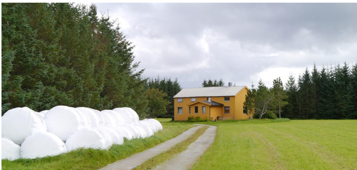
18150103020: 43 % av SEFRAK-bygningene som inngikk i undersøkelsesgrunnlaget ved oppstart av kontrollregistreringen i Vega kommune er registrert som uendret og intakt i 3. omdrev. Foto: KF/NIKU 2013
