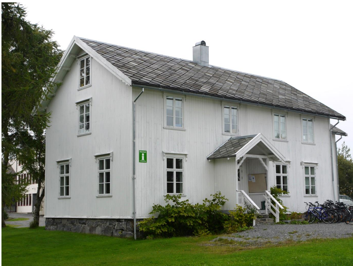
18150106027: I Vega kommune har kontrollregistrering av SERFAK-bygninger blitt gjennomført i 2003, 2008 og 2013. Den gamle skolebygningen på Gladstad er registrert som uendret og intakt gjennom alle tre omdrevene. Foto: ÅD/NIKU 2013
