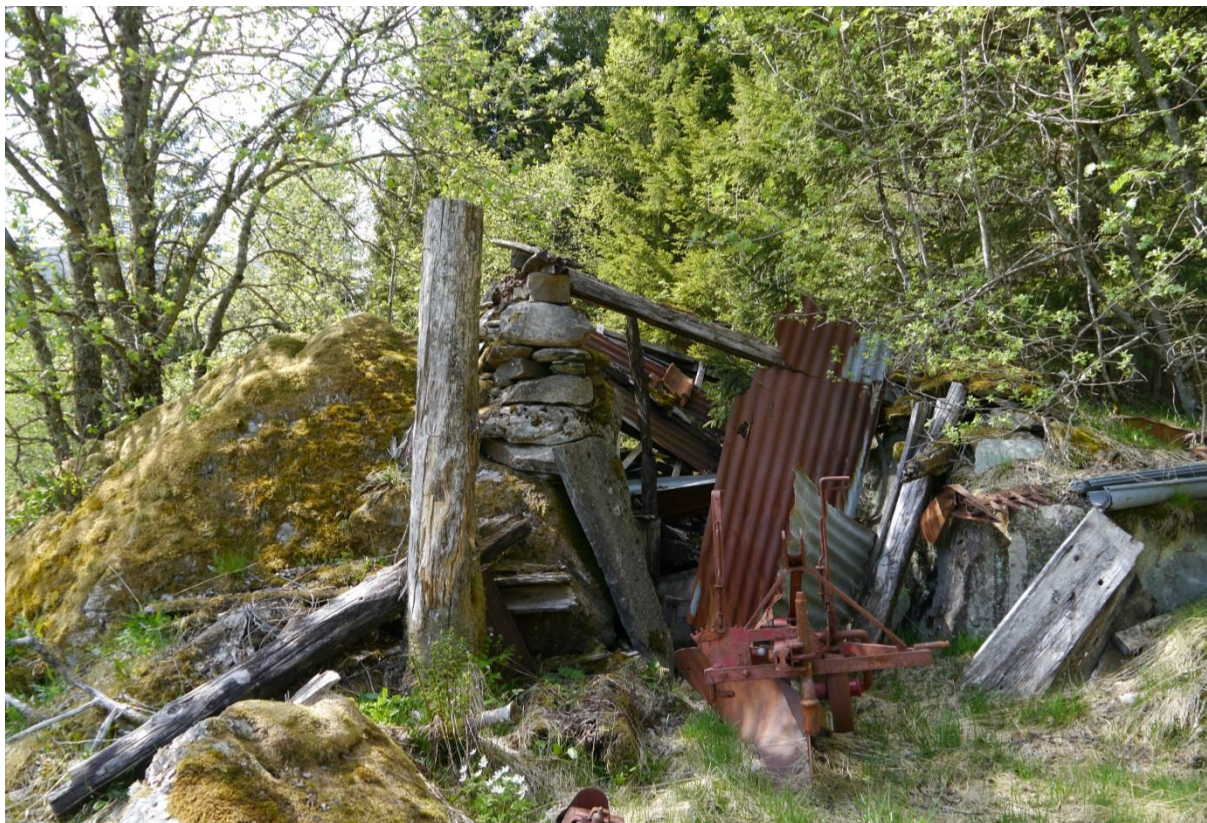
14010104010: Riving er den viktigste tapsårsaken for SEFRAK-bygninger i Flora kommune i 3. omdrev. Kun tre av bygningene er registrert med tapsårsaken falt i ruin. Foto: ÅD/NIKU 2013
