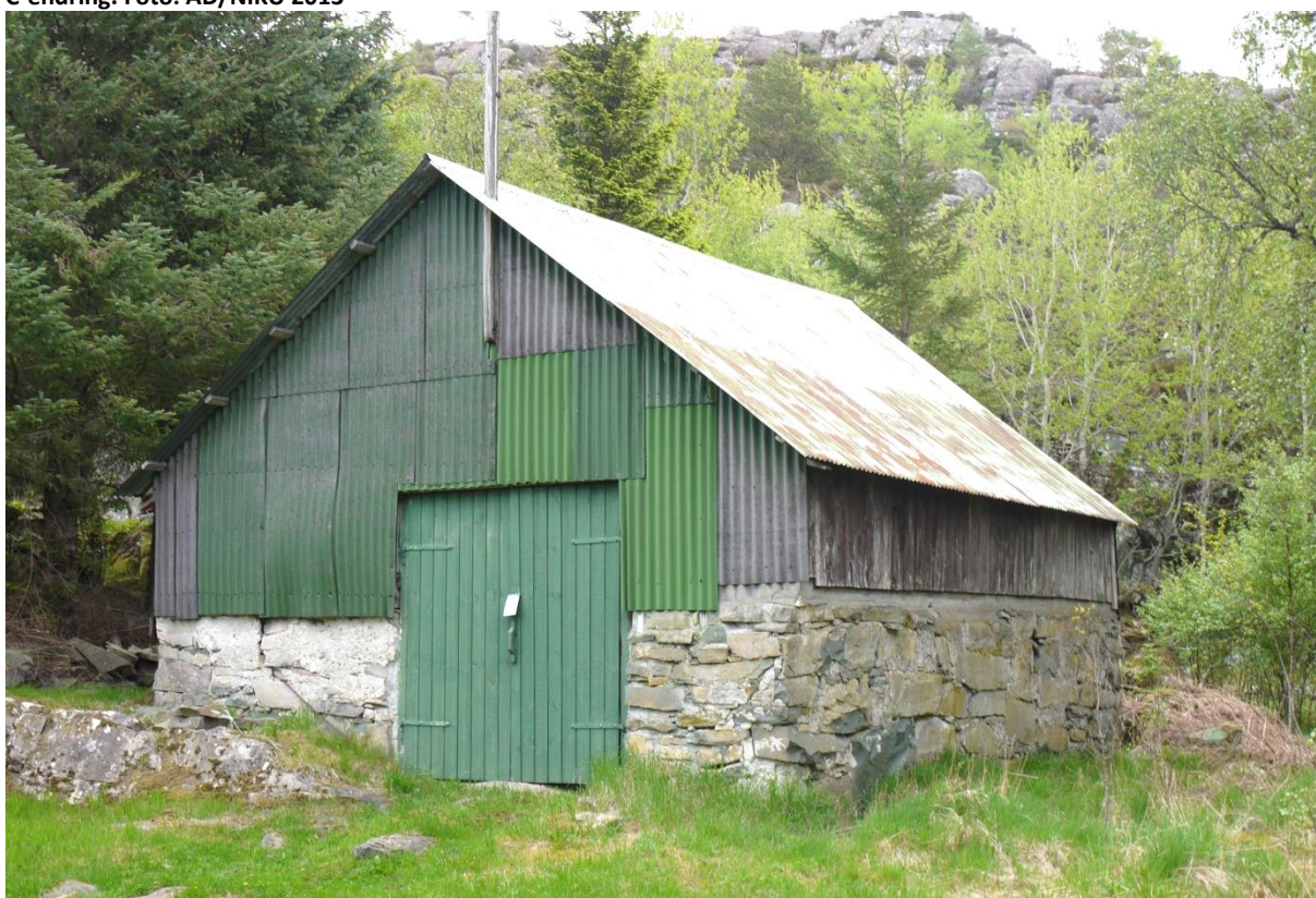
14010112003: Hvis bygningens karakter ikke er endret i forhold til foto fra den opprinnelige SEFRAK-registreringen, blir den registrert som uendret. Foto: LM/NIKU 2013
