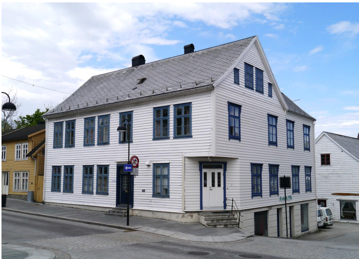
14010301009: I Flora kommune har kontrollregistrering av SERFAK-bygninger blitt gjennomført i 2003, 2008 og 2013. Denne bygården i Strandgata i Florø er registrert som uendret og intakt gjennom alle tre omdrev. Foto: ÅD/NIKU 2013
