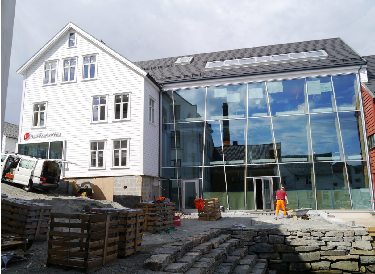
14010301010: Større volumendringer, slik som tilbygget på denne bygården i Strandgata i Florø sentrum, blir registrert som A-endring. Foto: ÅD/NIKU 2013
