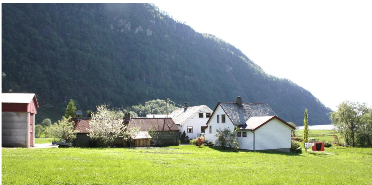
14010114001: Av de SEFRAK-registrerte bygningene i Flora kommune er det bolighusene og våningshusene som har høyest andel volumendringer (18 %). Foto: RM/NIKU 2013
