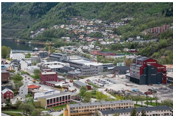
Odda Smelteverk med Ovn 3 til høyre, den eneste gjenværende av ovnene for karbid og for kalk som er bevart på cyanamidfabrikken. Dicyanamid-delen av verket er midt på bildet. Foto: Harald Hognerud.
