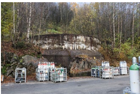
Restene etter gasometeret for ammoniakk. Foto: Eystein M. Andersen.
