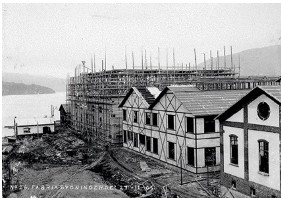
Birkelands eksperimenter endte i 1905 på Notodden, der en prøvefabrikk ble reist. Ovnshus og tårnhus under bygging i 1906. Foto: Norsk Hydro.
