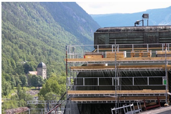
Vedlikeholdsarbeider på Såheim kraftstasjon pågikk i 2012. Foto: Eystein M. Andersen.
