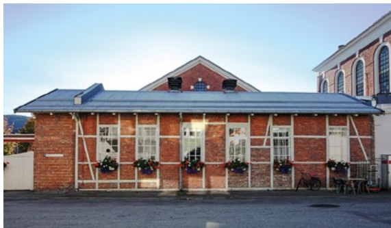
Bygning for forsøksfabrikk, seinere bl.a. smie og latrine, slik den står i dag. Foto: Eystein M. Andersen.
