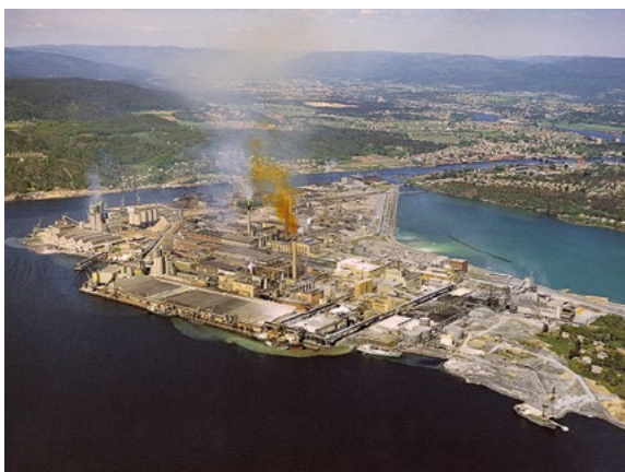
Hydro bygde en fabrikk basert på ammoniakksyntese-prosessen (Haber-Bosch) på Herøya. Området utviklet seg raskt til å bli det største industrikonglomeratet i Norge. Yara fortsetter i dag Hydros produksjon av kunstgjødsel her. Foto: Norsk Hydro.
