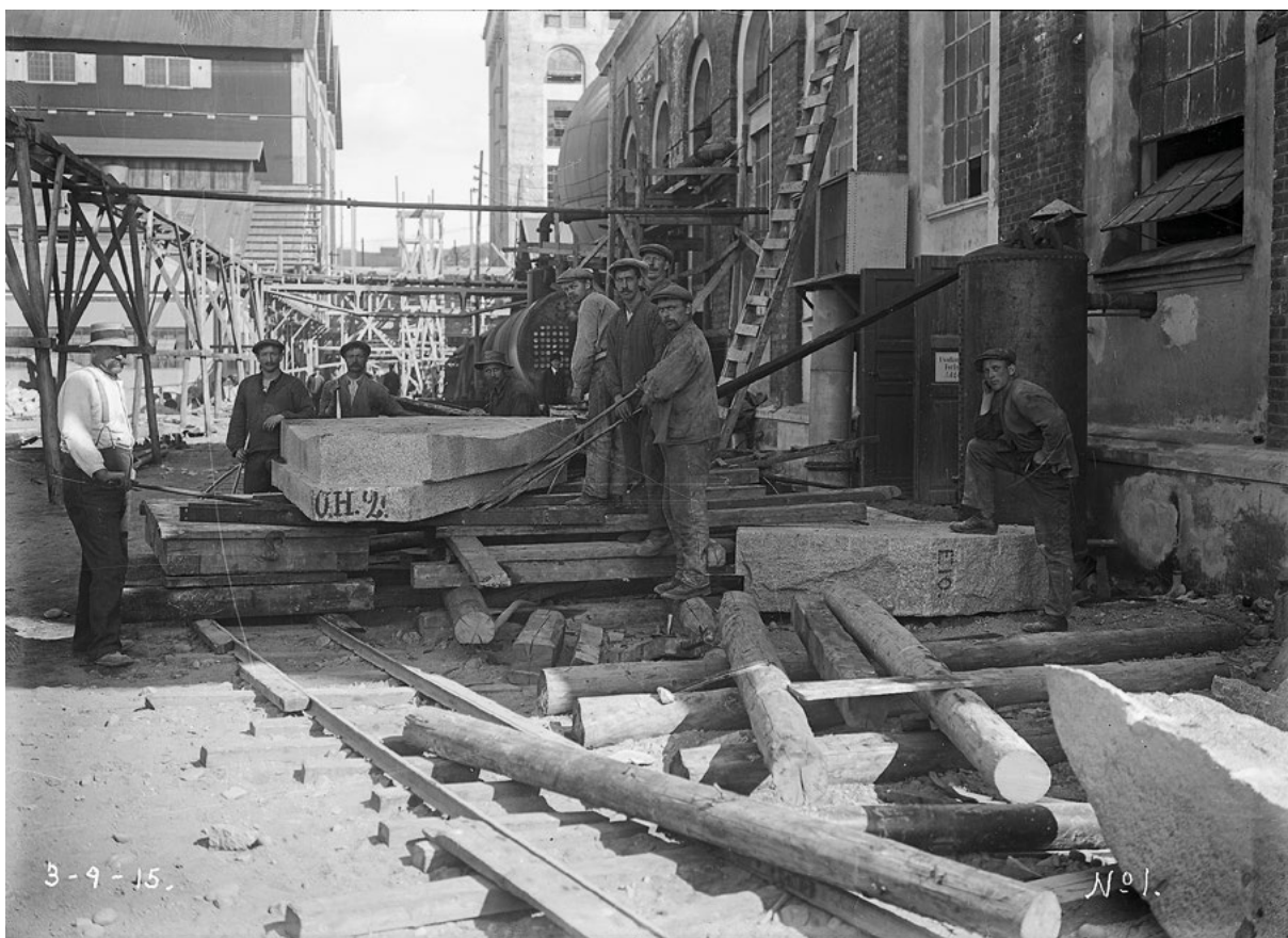
Arbeidslag ved Tårnhus A på Notodden. Foto: Norsk Industriarbeidermuseum.
