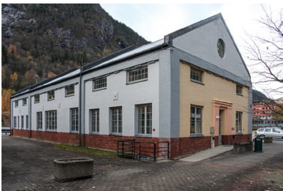
Telefonverkstedet i dag. Foto: Eystein M. Andersen.
