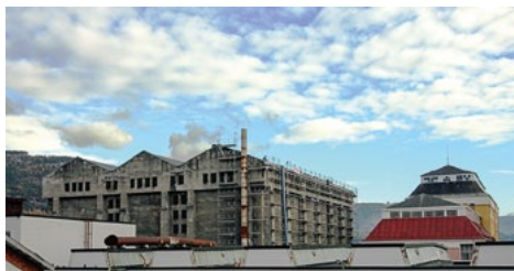
Arbeider ble utført på Tårnhus A i 2012. Foto: Eystein M. Andersen.
