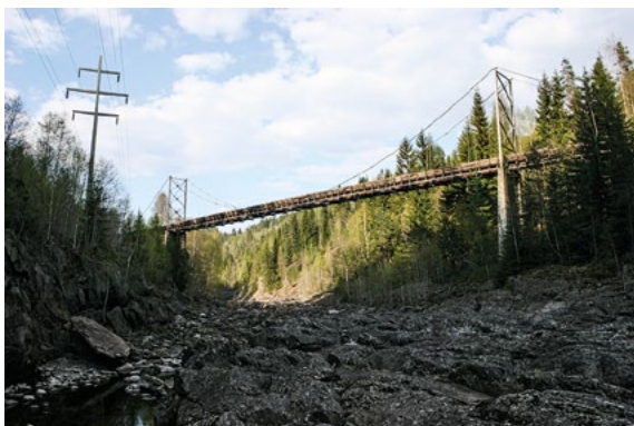
Tømmerrenna krysser på akvadukt over Tinnelva. Foto: Telemark fylkeskommune.
