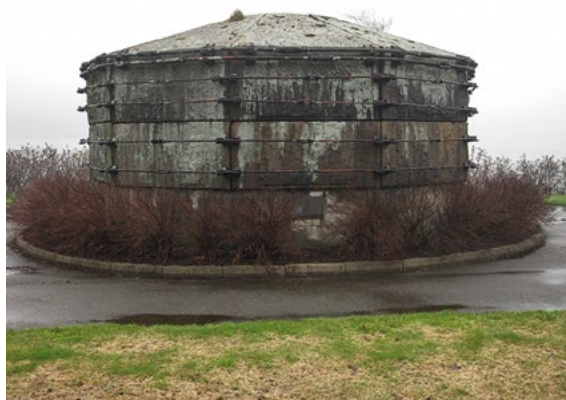
Toppen av et absorpsjonstårn er plassert som et minne om de i alt 71 syretårnene som fantes på Herøya mellom 1929 og 1982. De hadde en høyde på 30 m, veide i alt 26 000 tonn og inneholdt 13 000 granittblokker. Foto: Trond Taugbøl.
