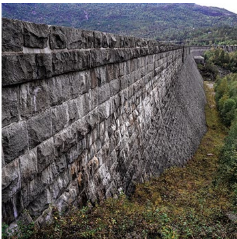
Ringedalsdammen inngår i Tyssø I anlegget. Det er en granittdam som hever Ringedalsvatnet opp til 464 moh. Foto: Birger Lindstad.
