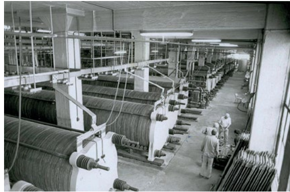
Til venstre: Såheim II hydrogenfabrikk sett fra Såheim kraftstasjon med Kompressorhuset i forgrunn. Foto: Eystein M. Andersen. Til høyre: Interiør med elektrolysører i siste driftsår. Foto: Norsk Industriarbeidermuseum.
