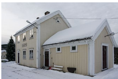
Stasjonsbygningen på Lisleherad som den står i dag. Foto: Eystein M. Andersen.
