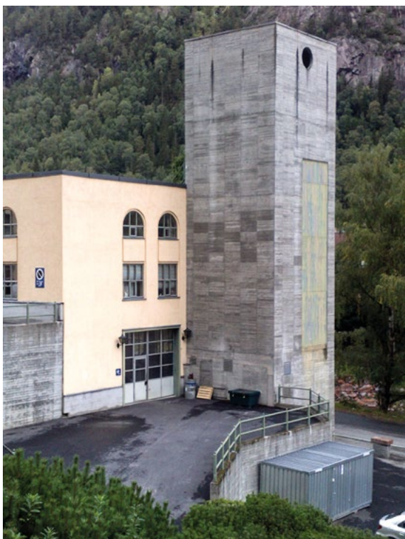
Tungtvannskolonnen er plassert i det støpte tårnet. Foto: Bjørn Iversen.
