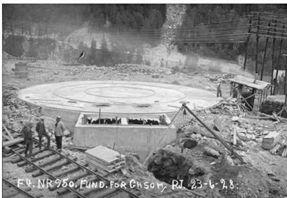
Gasometerfundamentet under bygging i 1928 til venstre, og dagens rest av gasometeret til høyre. Foto til venstre: Norsk Industriarbeidermuseum. Foto til høyre: Eystein M. Andersen.
