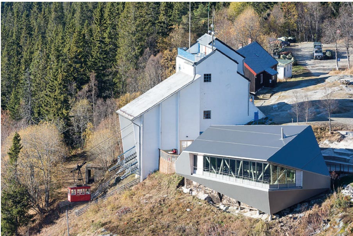
Den nye kafeybygningen på Gvapseborg ved Krossobanens toppstasjon. Foto: Per Berntsen.
