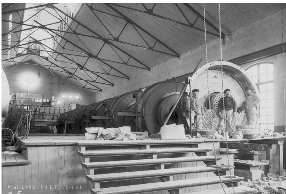
Interiør i Ovnshus A i 1908. Nye lysbueovner er under montering og bygging. Foto: Norsk Hydro.
