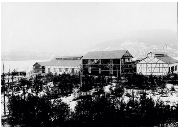
Prøvefabrikken som ble bygd på Notodden tidlig i 1905, med ovnshus, tårnhus og kjelehus. Foto: Norsk Hydro.
