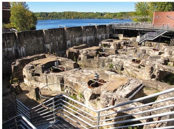
Kraftstasjonen Alcan 16 som ble revet i 1946 viser betongstrukturer for å lede vannet til og gjennom turbinene. Ruinen er del av temaparken i Shawinigan.
