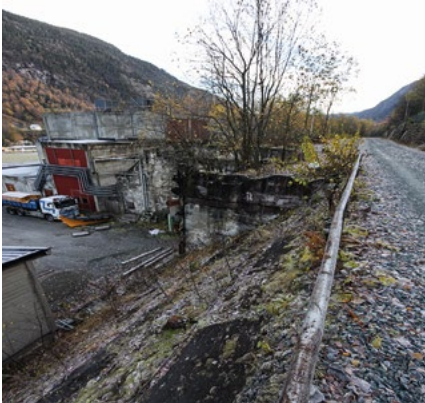
Rest av oppløsningsanlegget fra Tårnhus I, også benevnt «Syrepit», «Silomur» og «Lille Helvete», som det kan ses i dag. Foto: Eystein M. Andersen.
