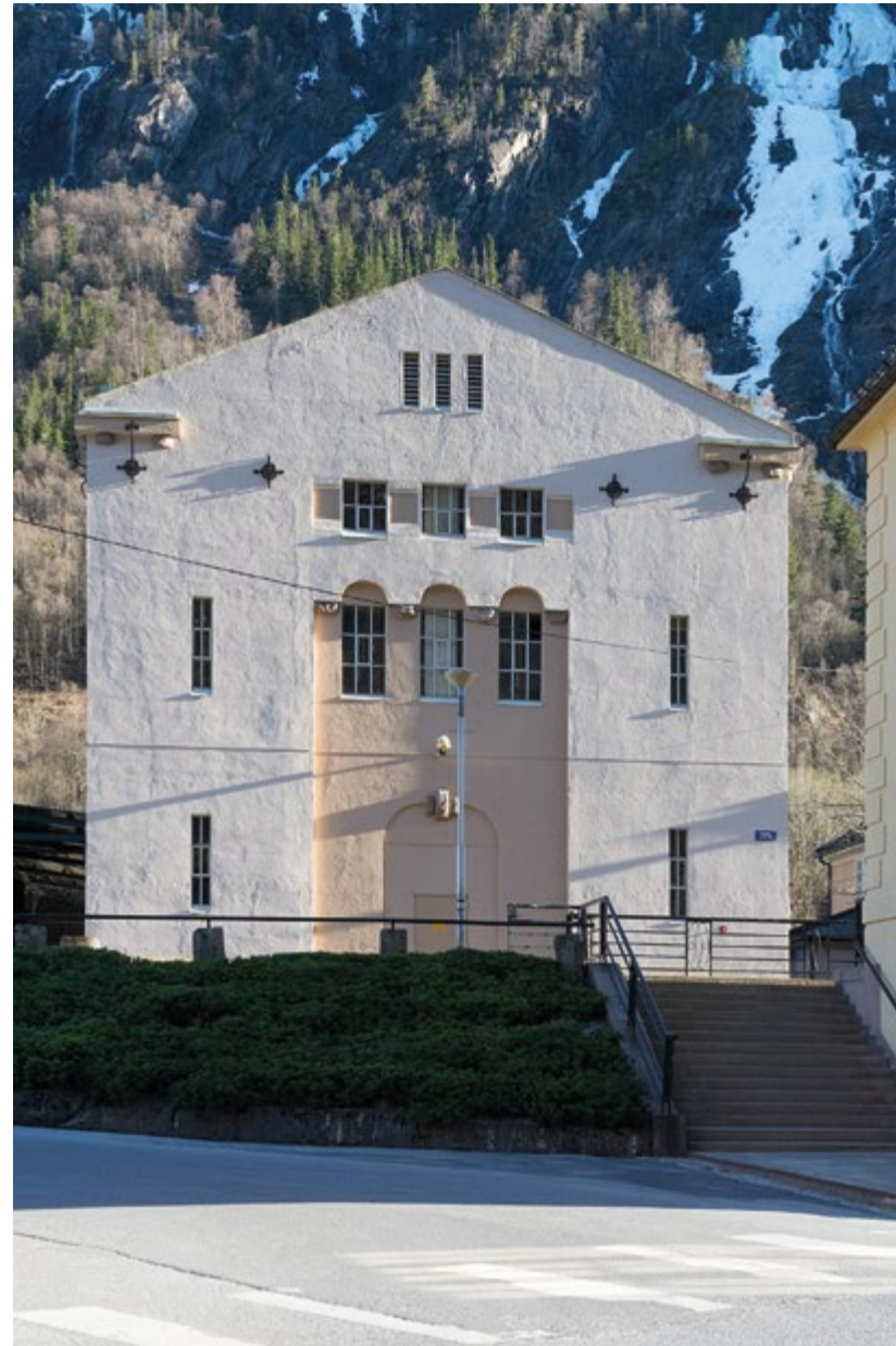
Fig. 38 Trafo- og fordelingsstasjon, Rjukan. Foto: Per Berntsen
