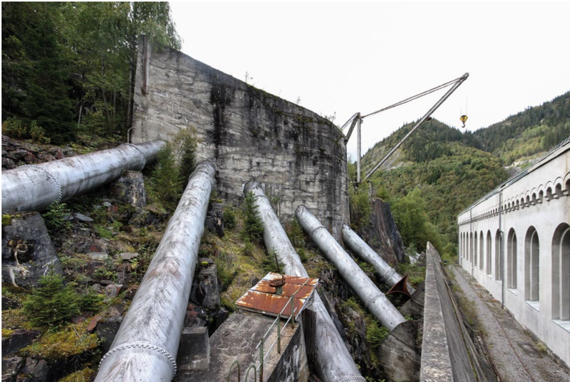
Fig. 22 Rørgate og Vemorksporet ved Vemork kraftstasjon. Foto: Eystein M. Andersen
