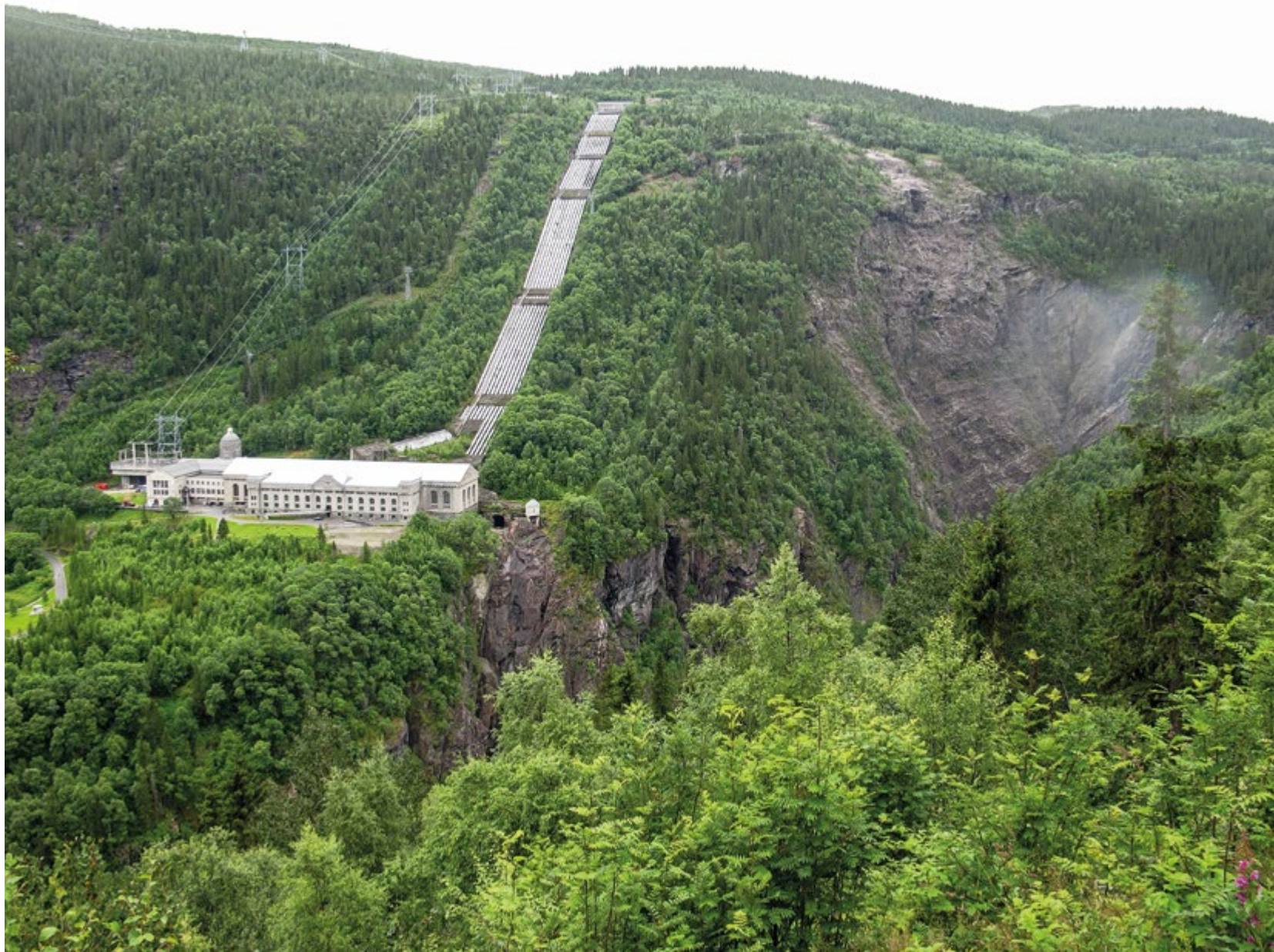
Fig. 23 Vemork kraftstasjon. Foto: Trond Taugbøl
