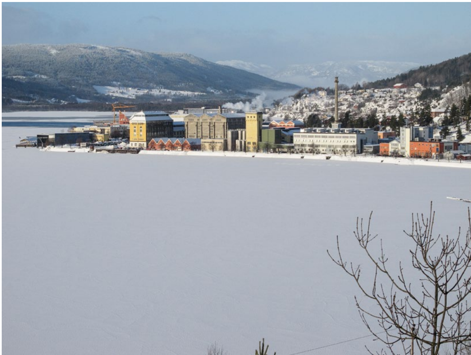
Fig. 39 Hydroparken på Notodden sett mot nordvest. Foto: Trond Taugbøl
