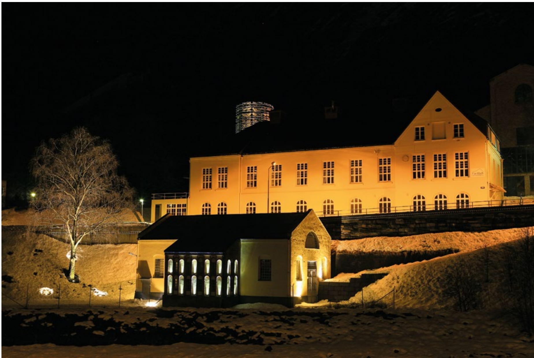
Fig. 61 Pumpehus, laboratorium og syretårn, Hydroparken Rjukan. Foto: Hans-Dieter Fleger
