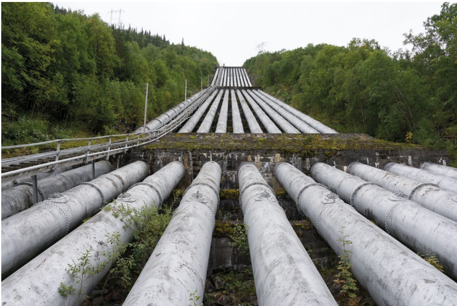
Fig. 21 Rørgate ved Vemork kraftstasjon. Foto: Per Berntsen
