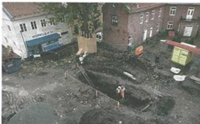
Gammel byggetomt: I Munkhaugveita/Presidentveita skal det bygges nye boliger der det har stått hus fra byens tidlige tid. Foto: KIM NYGÅRD
