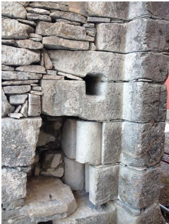
Foto 20050148_006 Fjerning av sementfuger og opprensing av murverk avdekket ombygging og gjenbruk av kleberstein i portal. Foto 20050148_060 bildet til høyre viser bortkjøring av uthogde sementfuger etter vinter/vårens arbeid med fjerning av sementfuger. Mengde uthugde fuger er omkring to kubikkmeter.
