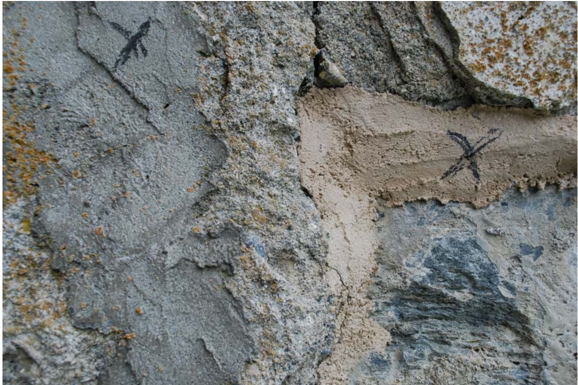
Foto 20050149_068 Sementfuge til venstre og Hydraulisk kalkfuge til høyre. Oppe i bildets høyre hjørne er det en sementpuss med hvitning/eller avsatt kalkutfelling på overflaten.
