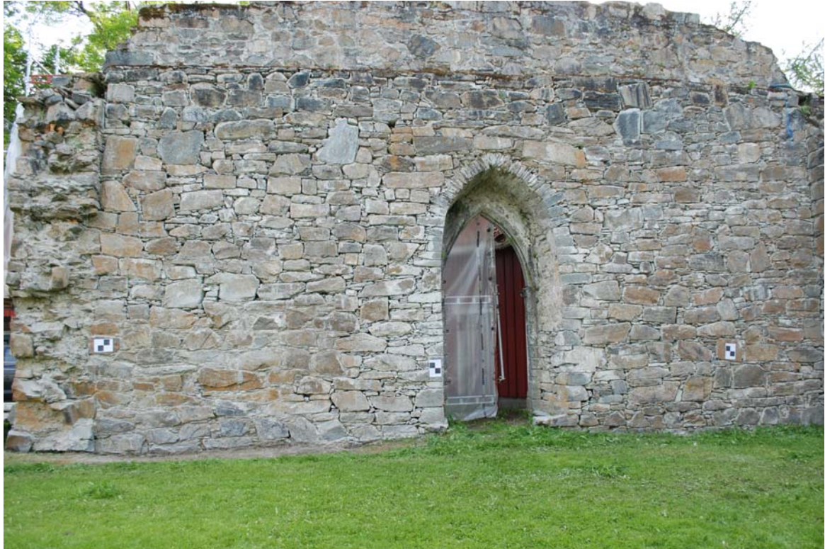
Foto: 20050149_042 Vestvegg på Rein klosterruin, meislet ren for sementfuger, delvis spekket og stillaser fjernet for fotogrammetrisk oppmåling sommeren 2013.
