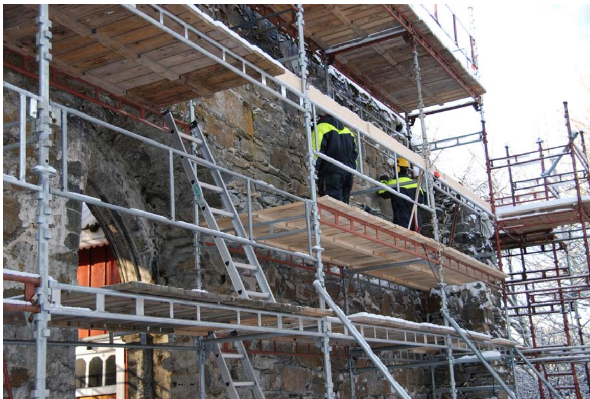
20050149_001 Montering av stillaser på vestveggen. Bilder er tatt under arbeidet med å vurdere tilstand til murverket før igangsetting av meisling vinteren 2013.
