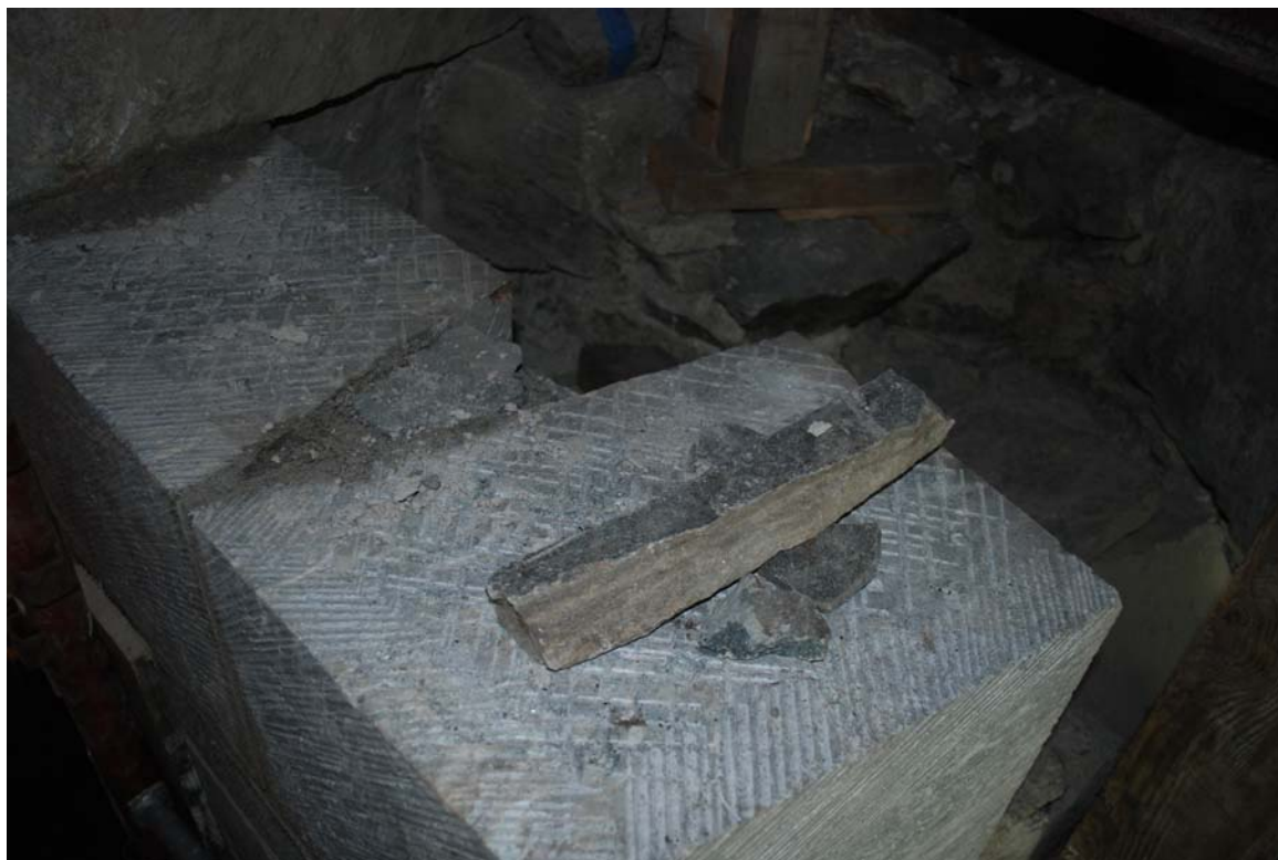
Foto 20050149_077 Tilhugget stein på plass i muren. Bildet er tatt før steinene er "bakmurt".
