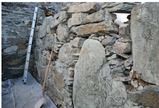
20050727_003 og _030 Før og under arbeidets gang. Murverket er utført med store hovedsteiner og store mengder pinningsstein i mellom hovedsteinene. Under demontering av pinningsstein ble disse fotografert, merket med kritt og murt tilbake. Toppsteiner er merket, demontert, rensert, gyset og murt tilbake i posisjon. Mye av murverket var sklidd ut og dette er rettet opp i veggens naturlige liv.
