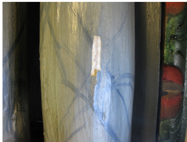
Foto 8: Østre søyle, ved Korsfestelsen. Her sees tykkere malingsflak som har delaminert fra underlaget. Detalj før konsolidering.
