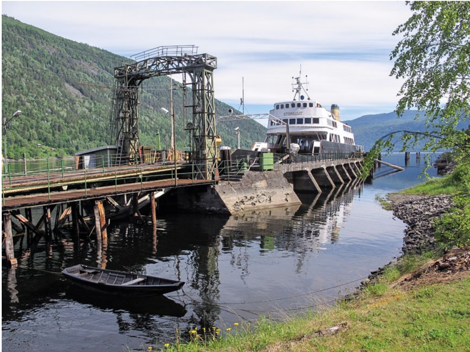
Fig. 77 Mæl Ferry Quay. Photo: Trond Taugbøl
