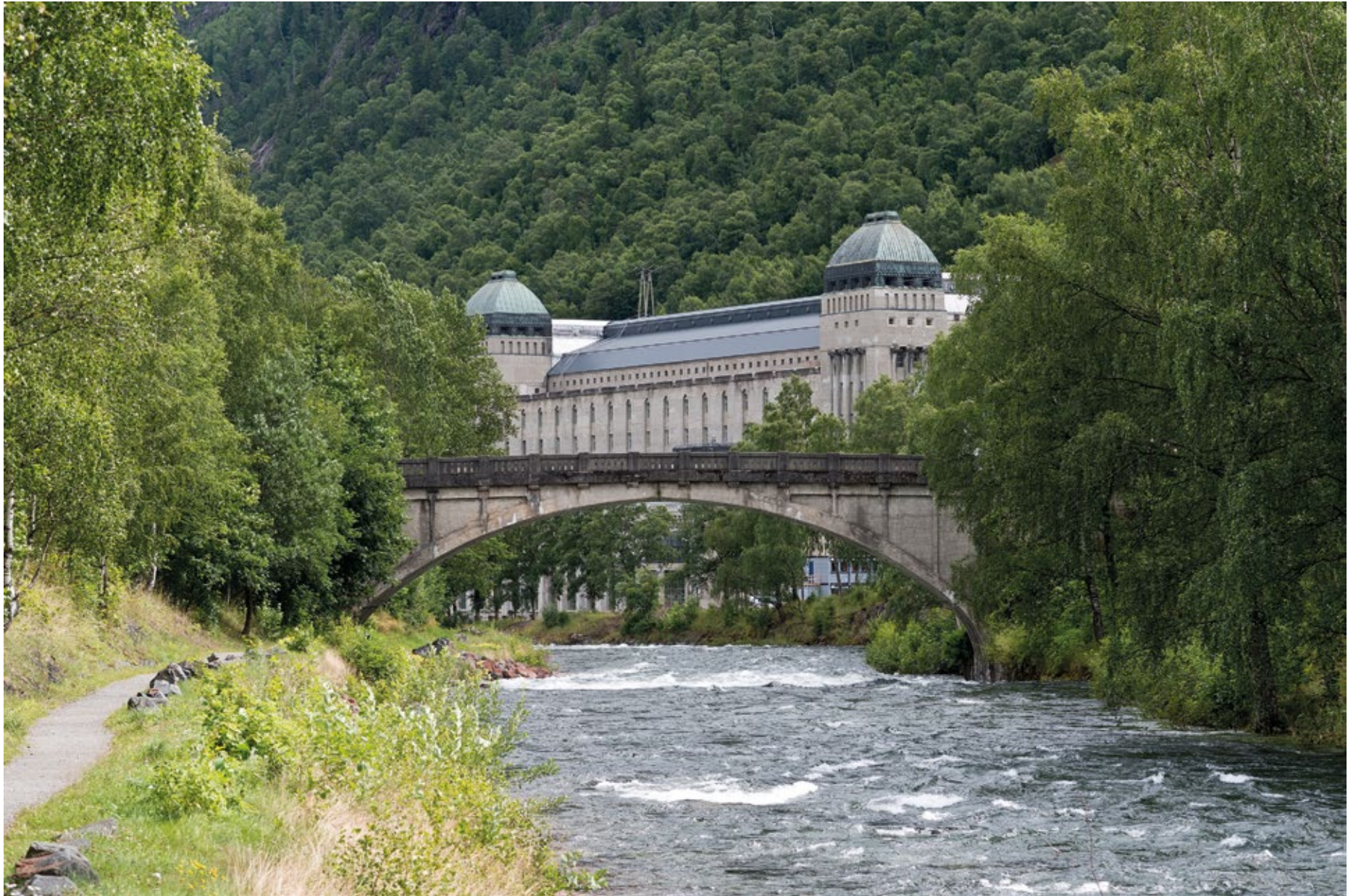
Fig. 29 Måna river and Såheim Power Plant. Photo: Per Berntsen
