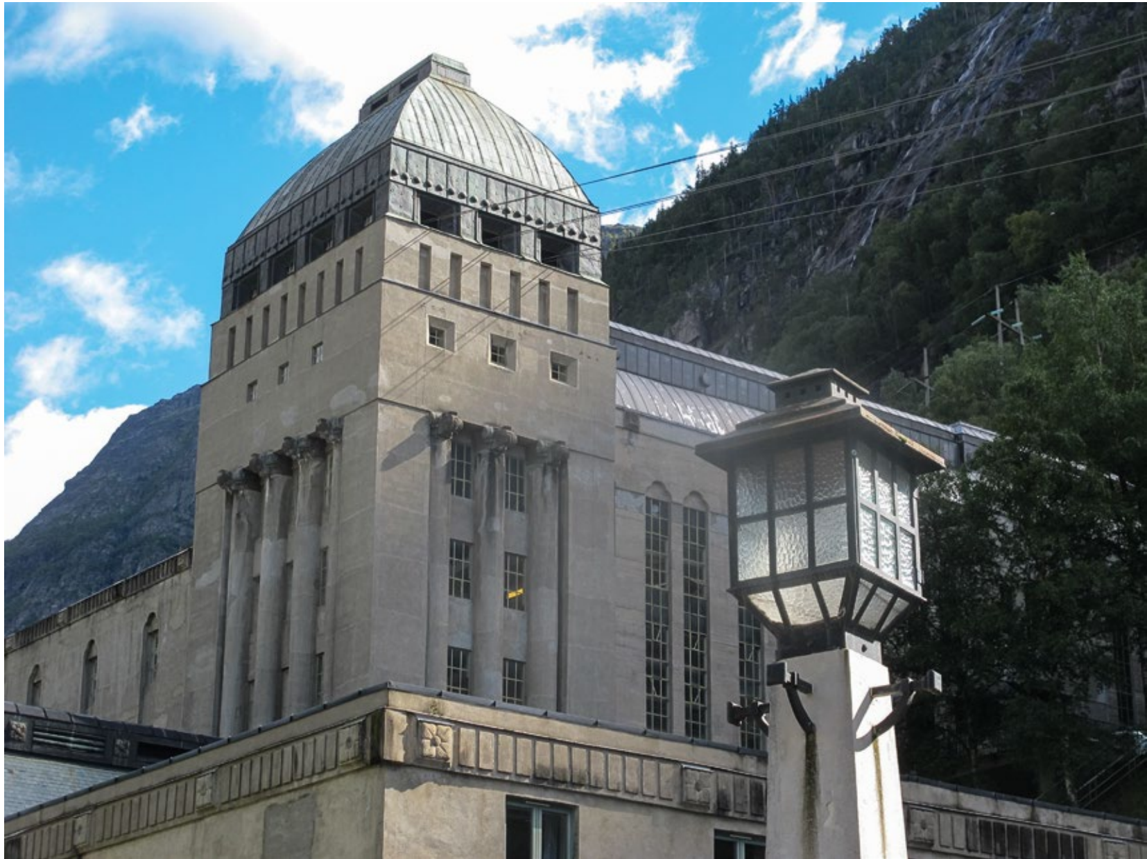
Fig. 32 Såheim Power Plant. Photo: Trond Taugbøl
