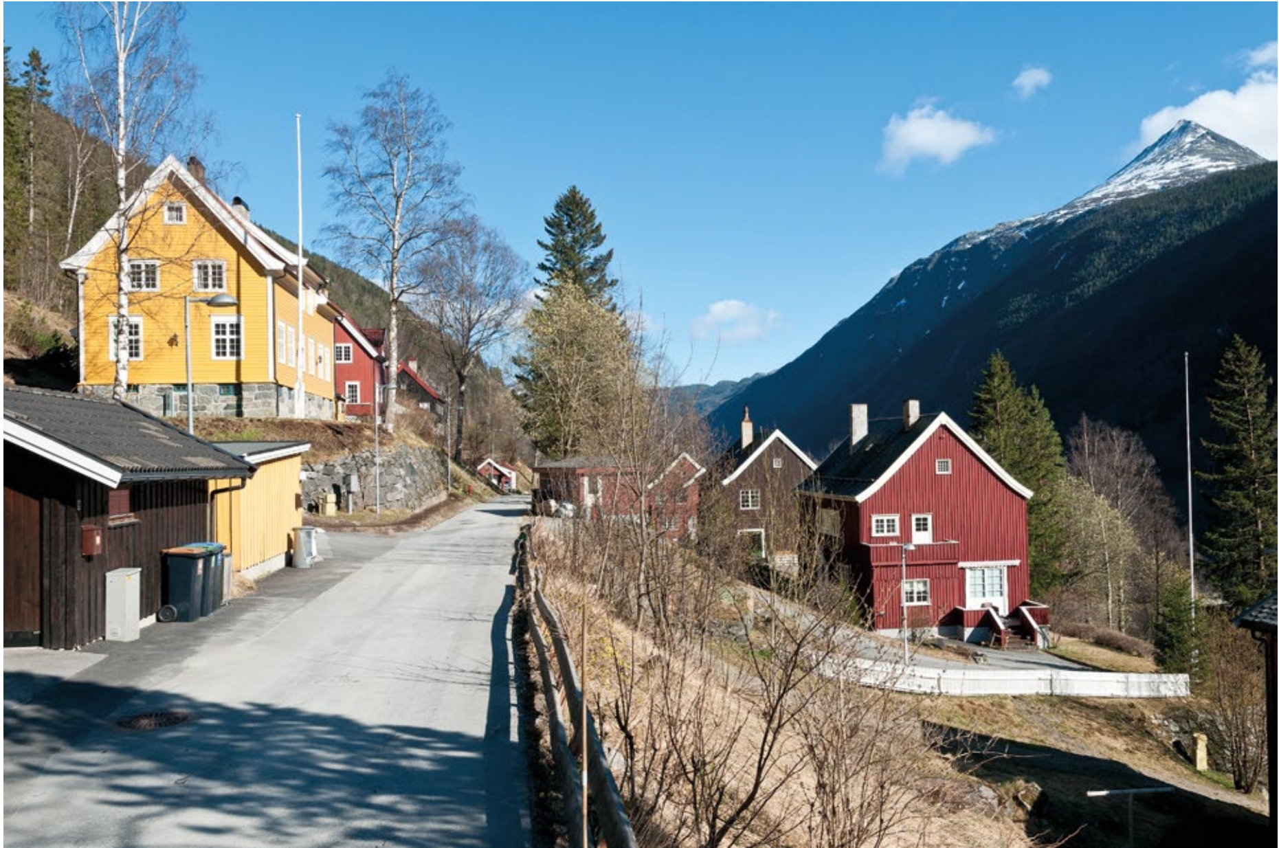
Fig. 95 Fjellveien, Rjukan Hydro Town. Photo: Per Berntsen
