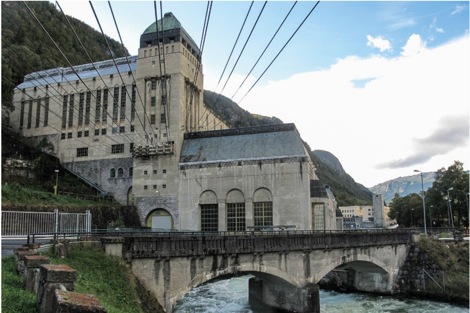
Fig. 31 Såheim Power Plant. Photo: Trond taugbøl
