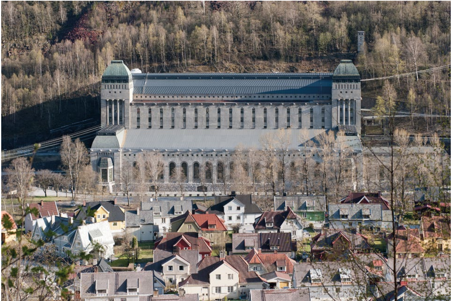
Fig. 30 Såheim Power Plant. Photo: Per Berntsen
