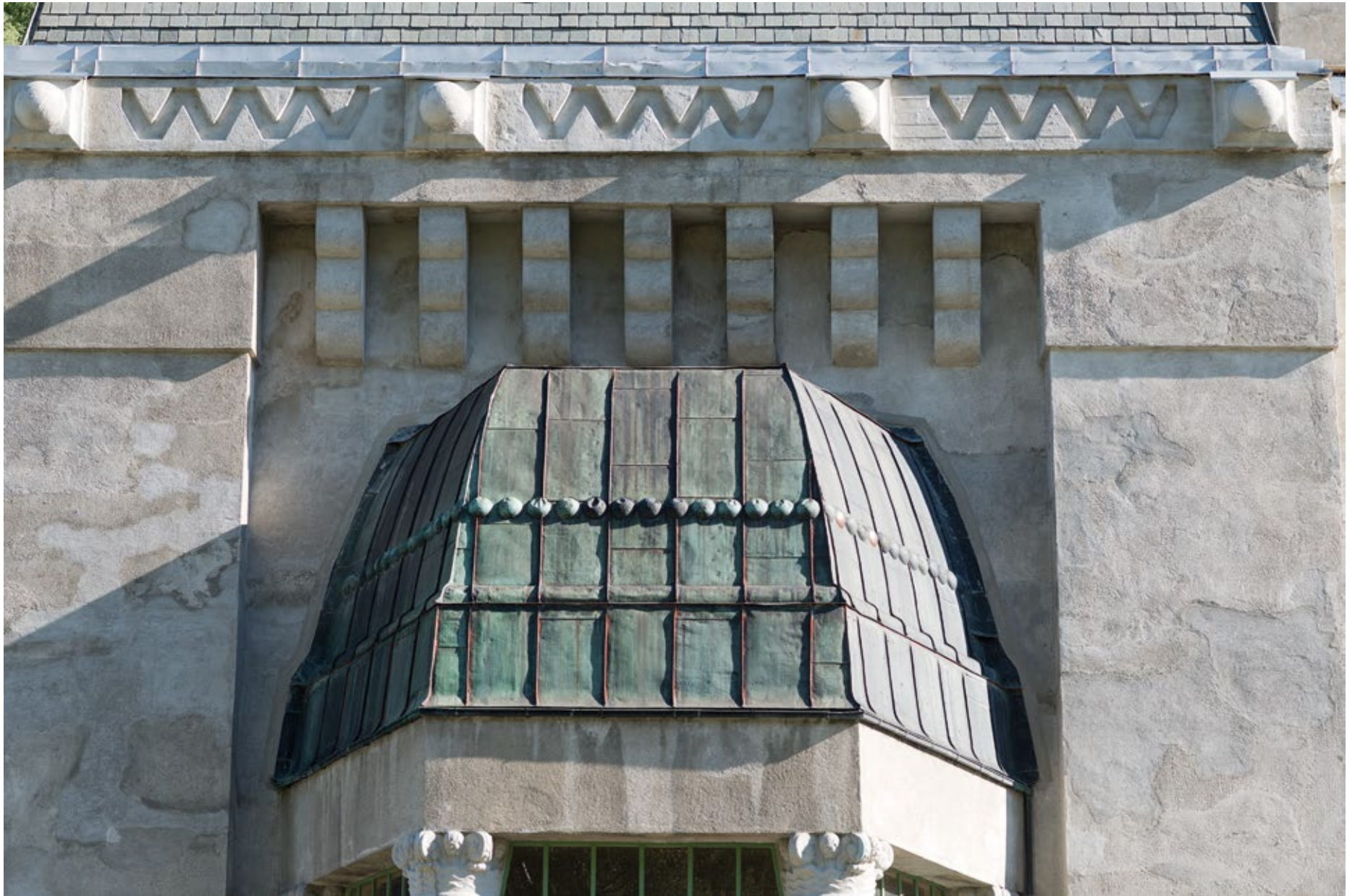
Fig. 33 Sårheim Power Plant. Photo: Per Berntsen
