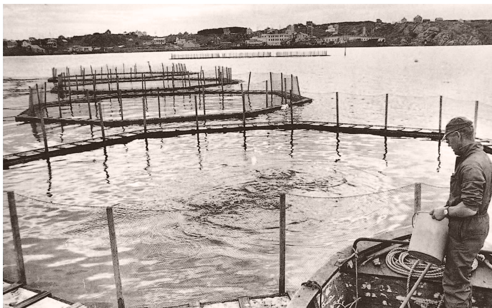
Alfred Kristiansen ved oppdrettsmerdene i Klauvasundet ca. 1972-73. Det var merder (Grøntvedt-merder) av impregnert treverk med isoporklosser som flottører. De åtte sidene var festet sammen med gummi fra bildekk. På innersiden av rammen var et gjerde av not. Foto: Adresseavisen
