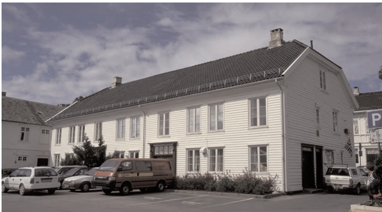
Tollboden i Farsund skal opprinnelig være bygd i 1770-årene og ligger på byens mest fremtredende tomt. I 1843 ble eiendommen kjøpt av staten til tollbod og ombygget i empirestil. På 1900-tallet overtok postvesenet bygningen, og i 1934 ble den ført på listen over statens administrativt fredete bygninger. Ved salg fra Posten BA fungerte ikke avhendingsinstruksjonen, og i dag har ikke bygningen noe formelt vern. Foto: Synnøve Haugen, Riksantikvaren.
