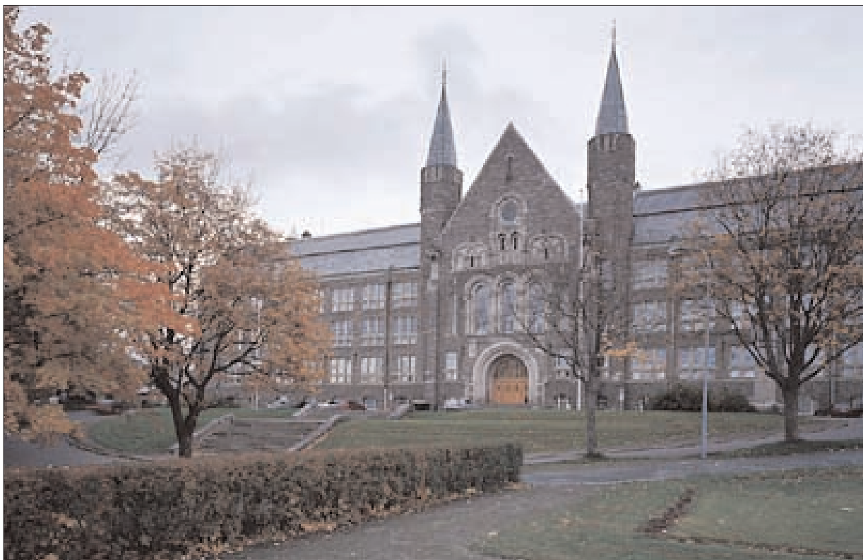
Rundt 1900 var huggensteinstilen toneangivende i Norden. I nasjonal begeistring skulle det norske grunnfjellet kle våre viktigste bygninger. Norges tekniske høyskole skulle huse selve fremskrittet og velstandens yrkesutdannelse – ingeniørens. Ved en slik anledning satset man stort. Arkitekt Bredo Greve løste oppgaven med en monumental bygning inspirert av Norges storhetstid, middelalderen. Prosjektet legger liten skjul på arbeidstittelen «vis-à-vis Domkirken». Da bygget stod ferdig, ble NTH etablert, og vår moderne ingeniør- og arkitektutdannelse startet. Foto: Jaro Hollan.
