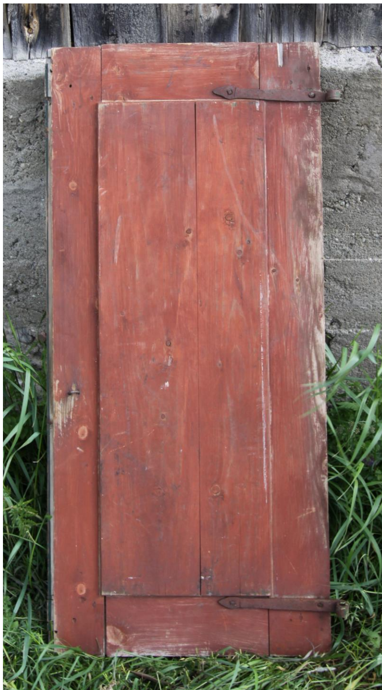
Figur 10. Vinduslem, innsiden. Opprinnelig malinglag er bevart. Innsiden er svært lite slitt, noe som indikerer at lemmene ikke har stått åpne om sommeren, men trolig har blitt hekket ned når setra har vært i bruk. Slitasjen på utsiden indikerer at de har vært lukket den delen av sesongen når setra har stått tom. Foto: JB. 2011.
