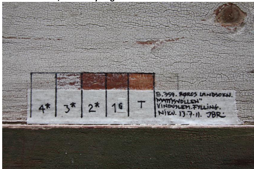
Figur 9. Fargelagsavdekking på fyllingen på vinduslemmen. Lag 1. er et grunningslag. Lag 2 er det opprinnelige malinglaget. Foto: JB. 2011.
