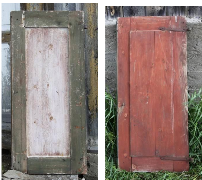
Figur 5. Røros landsogn. Mattisvollen. Vinduslemmer. Utsiden til venstre og innsiden til høyre. Vinduslemmene er også av en type som ble brukt i Røros bergstad i første halvdel av 1800- åra. Innsiden har fremdeles bevart et opprinnelig malinglag som skal illudere mahogni. Foto. JB. 2010.
