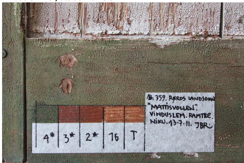
Figur 8. Fargelagsavdekking på ramtreet på vinduslemmen. Lag 1 er et grunningslag. Lag 2 er det opprinnelige malinglaget. Foto: JB. 2011.
