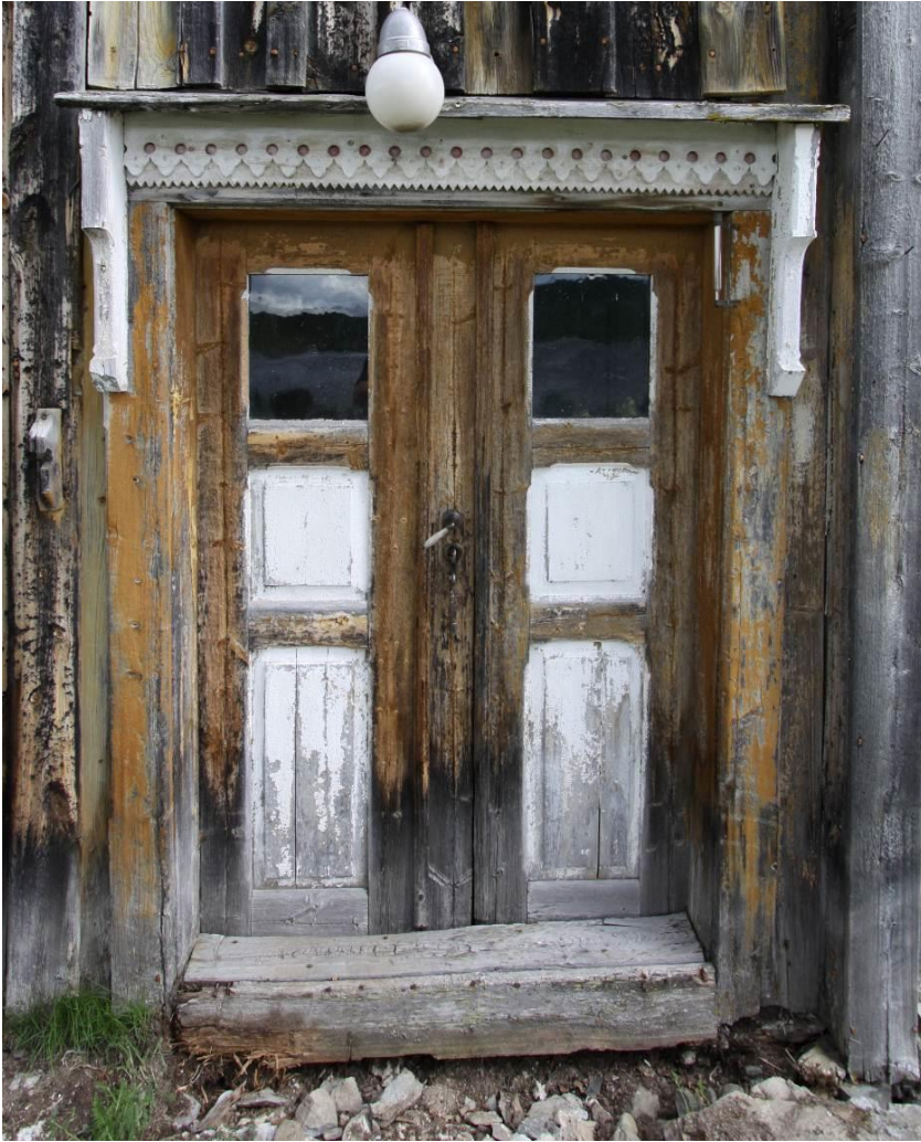
Figur 2. Røros landsogn. Mattisvollen. Hoveddøra med omramming. Det er behov for restaurering av dør, omramming og terskel. Glasset i de øverste fyllingene er trolig satt inn sekundært for å få lys inn i gangen. Foto. JB. 2010.
