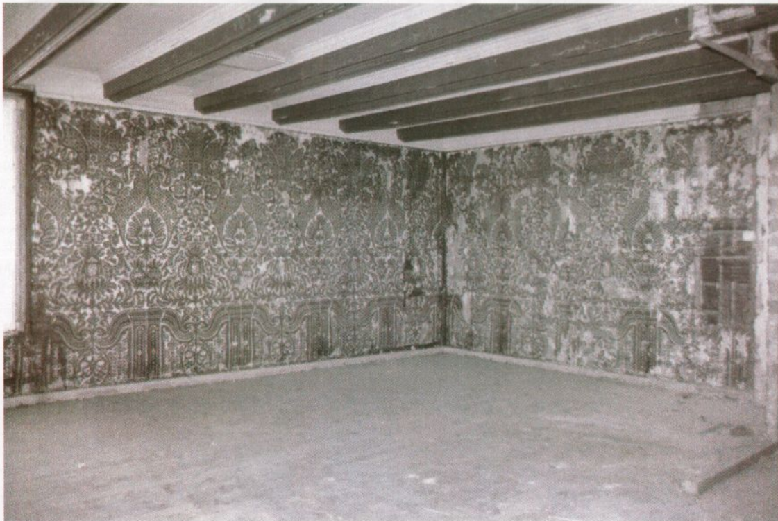
Bilde 7. Syd- og østvegg før demontering og behandling
