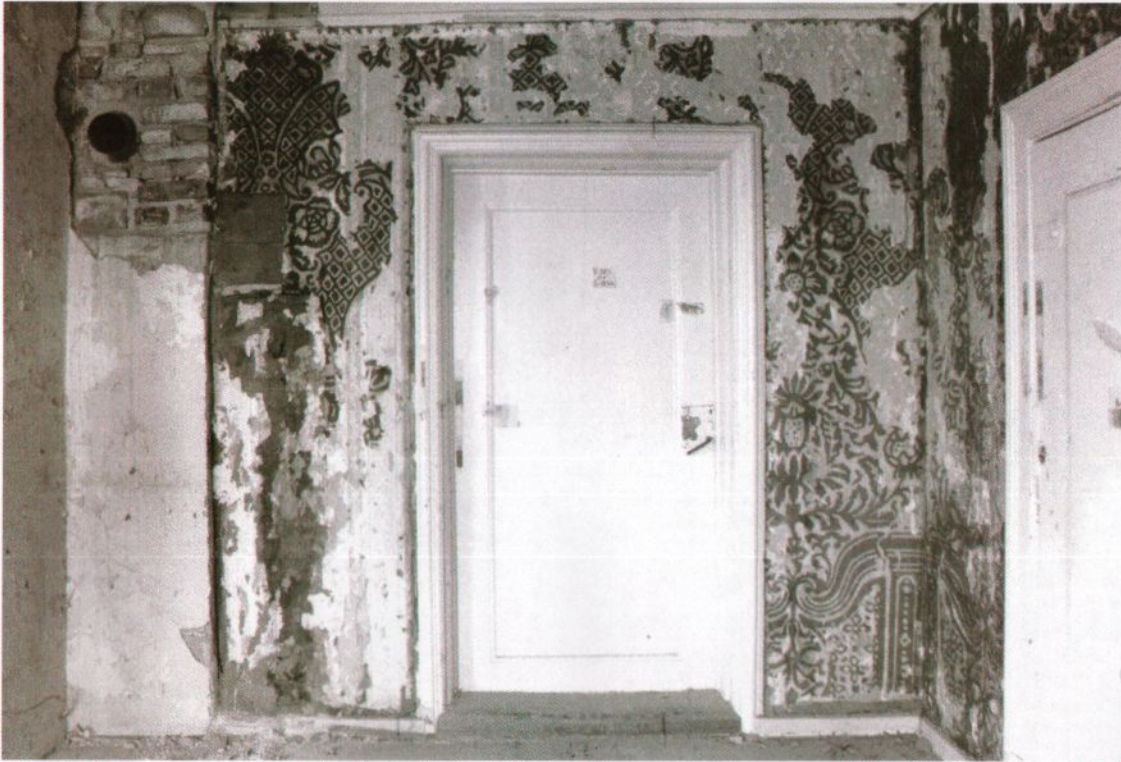
Bilde 6. Vestre del av sydvegg før demontering og behandling
