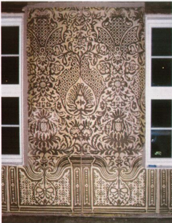
Bilde 13. Felt mellom vinduene på nordveggen. Tildekkingslerret dekker nedre del
