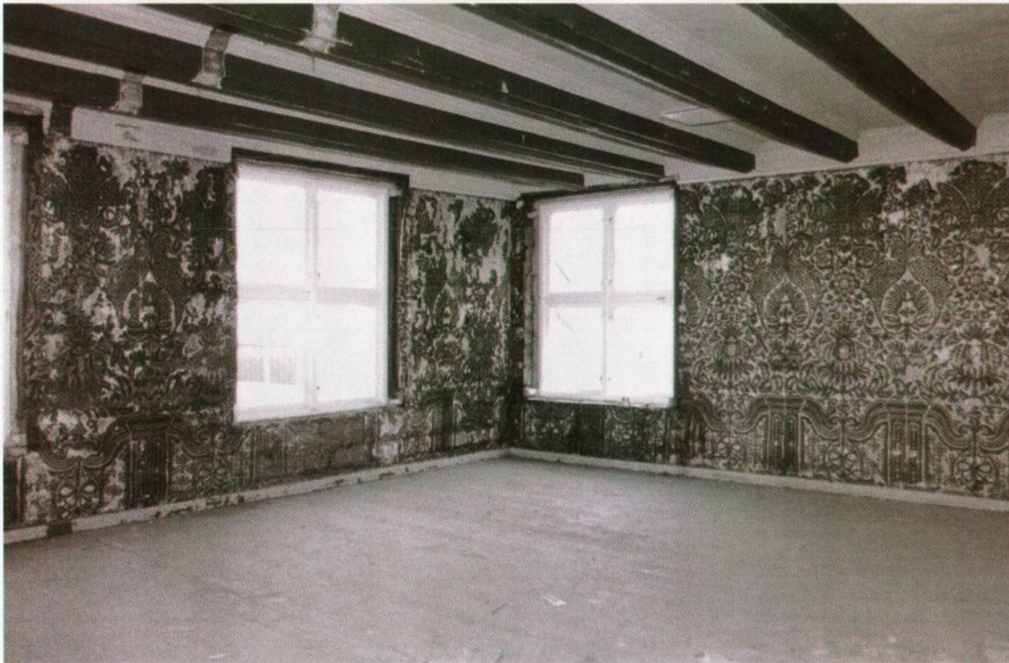
Bilde 4. Nord- og østvegg før demontering og behandling
