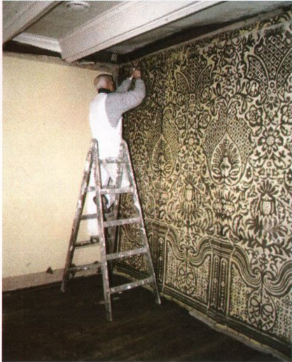
Bilde 12. Malemester Bjørn Andersen stifter tapetet til sydveggen. Underliggende gulmalt lerret på østveggen
