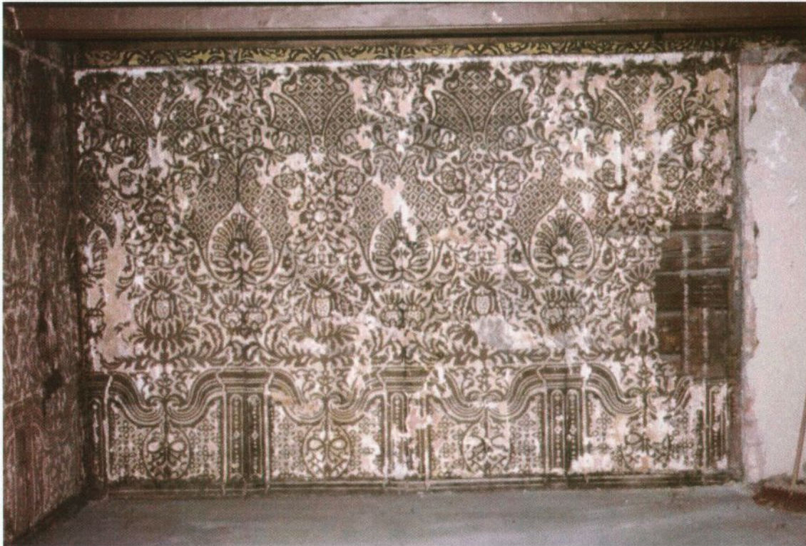
Bilde 14. Sydvegg. Før behandling
