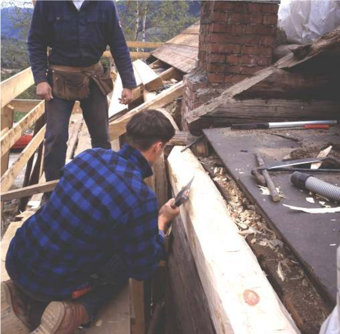
Reparasjon av raftstokk. Stue. Foto: Arve Kjersheim 1991.
