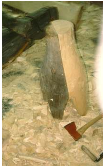
Den råtne delen av stubben ble hogd bort, ny del plugget til den gamle Foto: Hans Marumsrud 1993.
