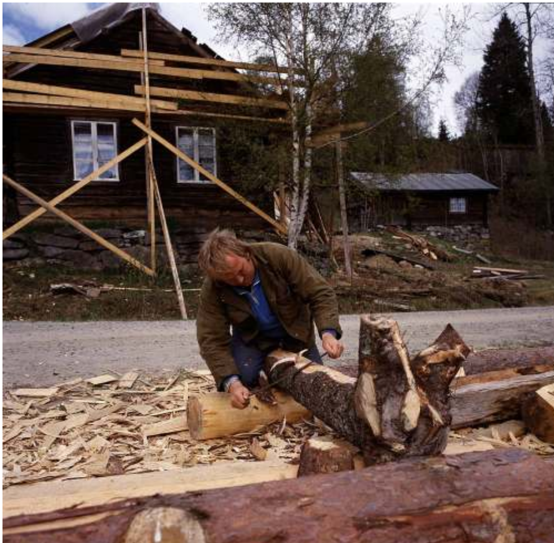
Uttak og tilpasning av sperrekroksemner til tak på stua, Sud-Åbø, Hjartdal kommune. Telemark Foto: Arve Kjersem 1991.
