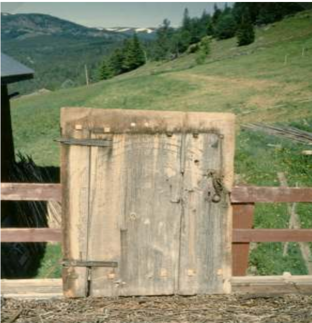
Dørbladet reparert med bla. nye plugger. Foto: Hans Marumsrud 1993
