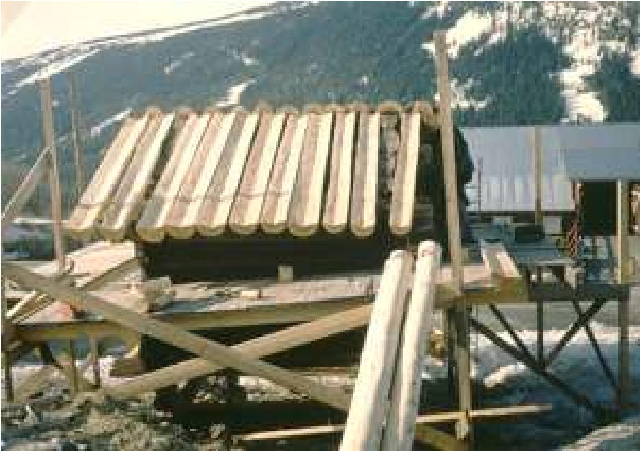
Undergåvene ferdiglagt. Foto: Hans Marumsrud 1993
