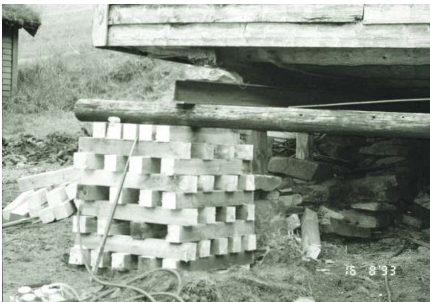
Jekking av loft. Lunde, Gaular, Sogn og Fjordane. Foto: Norodd Baug 1993.
