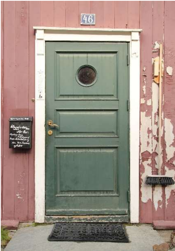
Fig. 2. Kjerkgata 46. Hovedinngangsdøra. «Pers-Døren» trolig satt inn i 1990-åra. Foto: J. Brønne. 28.-29. august 2013.
