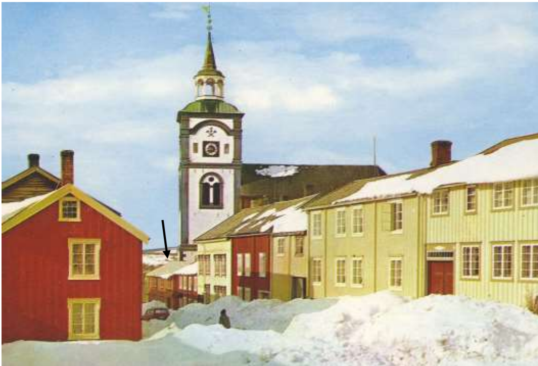
Figur 5. Kjerkgata 46. Udatert postkort. På grunnlag av endringene i de øvrige husene i gateløpet kan det dateres til siste del av 1960-åra. Nr. 46, sort pil, har blitt malt opp, og har fått farger og fargesetting som tilsvarer det som er funnet som lag 2. ved undersøkelsen. Eberhardt B. Oppi Kunstforlag. Nr. 2/68. Foto Normann. Jon Brønnes postkortsamling.
