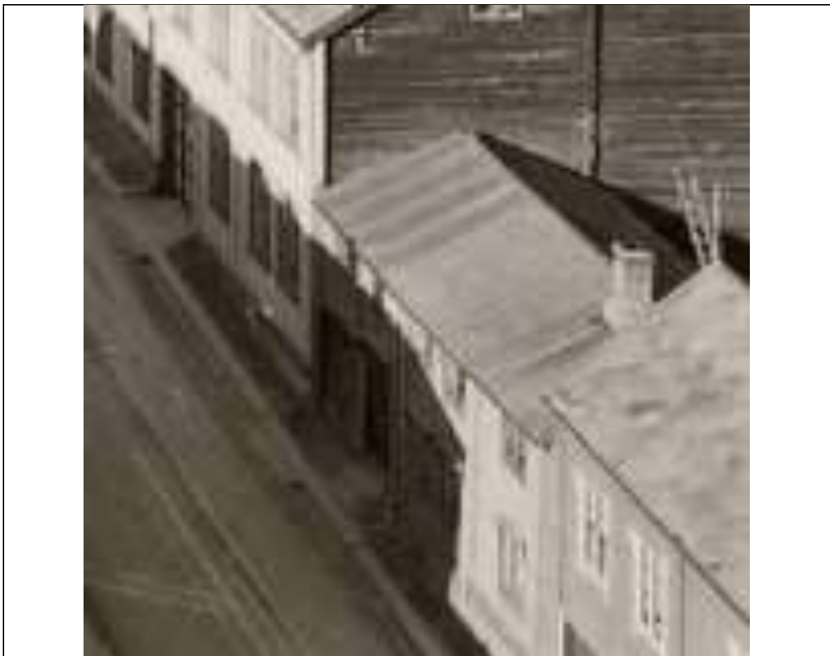
Figur 4. Kjerkgata 51. Postkort datert 26.7.1952. Detalj av fig.3. Huset har fått nytt tak, mens vinduer, panel, inngangsdør og port er uendret. Papp på taket. Jon Brønnes postkortsamling.
