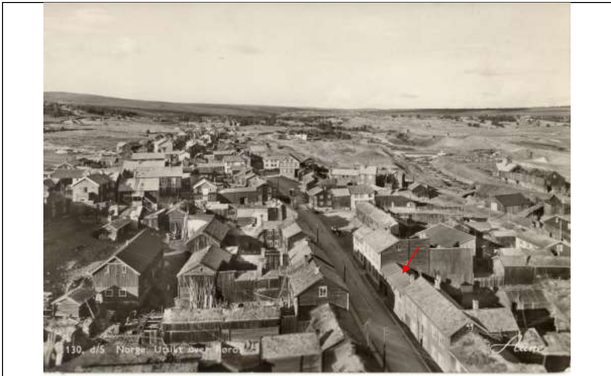
Figur 3. Kjerkgata 51. Postkort datert 26.7.1952. Huset har nå fått nytt tak, mens vinduer, panel, inngangsdør og port er uendret. Papp på taket. Jon Brønnes postkortsamling.
