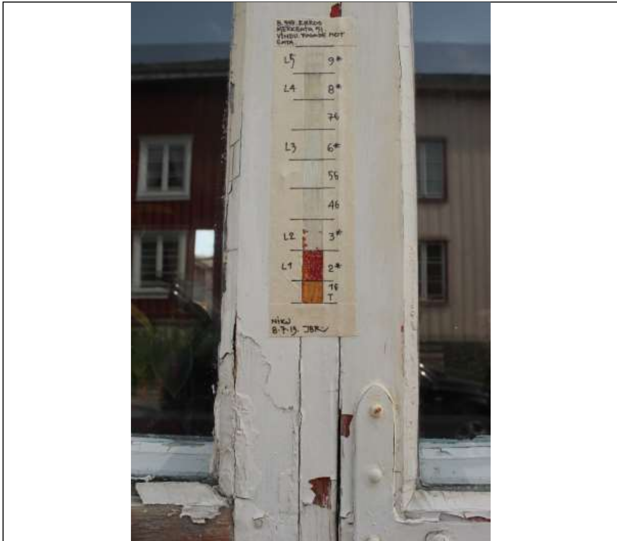
Fig. 9. Lagvis avdekking av malinglagene på vindu. Foto: Brønne. 8.-9. juli 2013.
