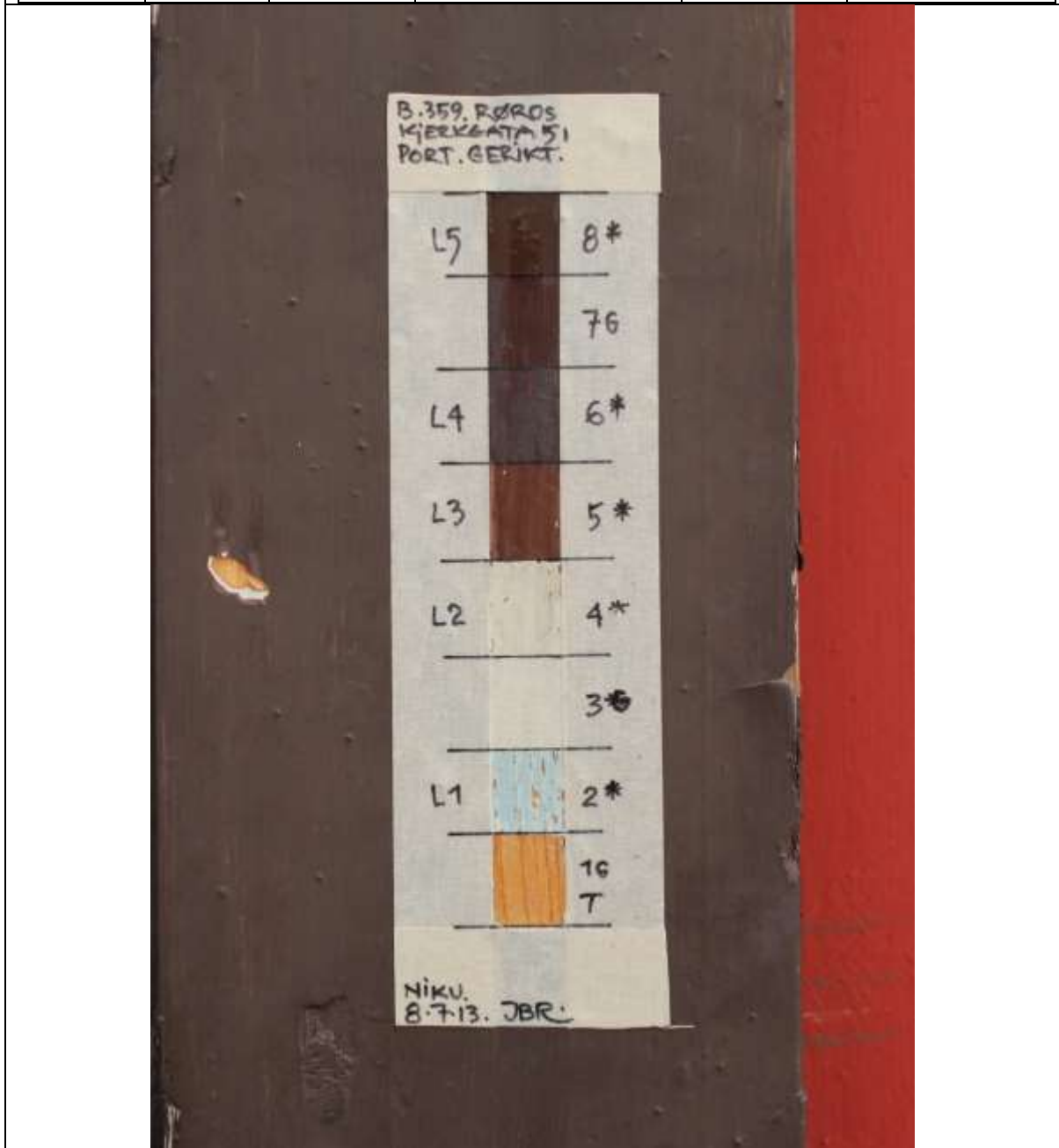
Fig. 7. Lagvis avdekking av malinglagene på portgerikten. Foto: Brønne. 8.-9. juli 2013.
