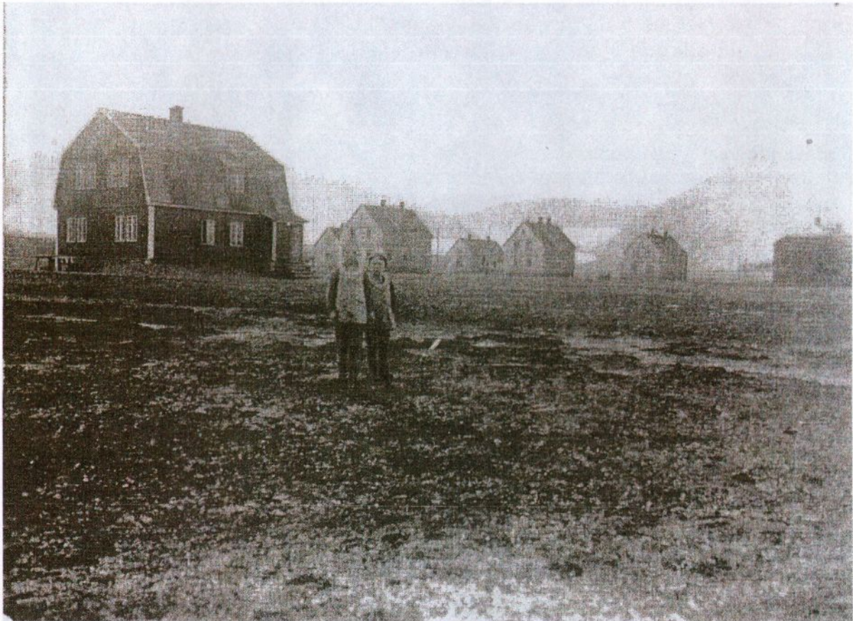
Figur 2. "Amundsenvillaen" i opprinnelig utseende. Bildet er tatt før ombyggingen til bar i 1937. Hovedinngangen er mot nord. Vinduene står på opprinnelig plass. Bildet viser at alle vinduene er av samme type. To-rams vinduer av empiretype, med tre glass i hver ramme. På østveggen er to og to vinduer satt inntil hverandre med en stender imellom. Dette er trolig gjort for å forenkle byggeprosessen, idet det er benyttet samme vindustype, i hele huset. Transporten er også enklere, idet man har sluppet å håndtere store firerams vinduer. Fotograf ukjent.
