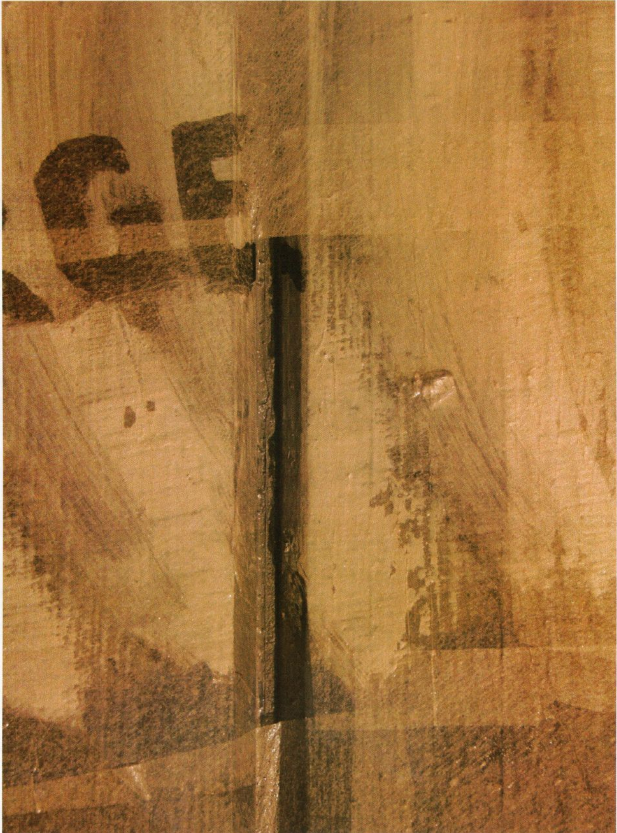
Figur 27. "Amundsenvillaen". Rom 116. Sydvegg, Detalj av opp- og avskallinger i dekoren etter sikring med overliming med Japanpapir og Gelatin. Foto. JB. 21.1.2004.
