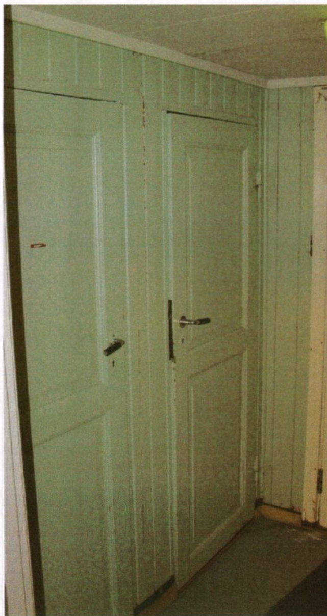
Figur 21. "Amundsenvillaen". Rom 101. Vindfang. Tre opprinnelige dører er bevart i 1. etasje. Alle tre er trolig bevart på opprinnelig plass i rom 101, vindfanget. Bildet viser de to dørene som leder inn til kottene på sydveggen. Det er stor sannsynlighet for at alle dørene i huset opprinnelig har vært identiske med disse to dørene. Foto. JB. 20.1.2004.
