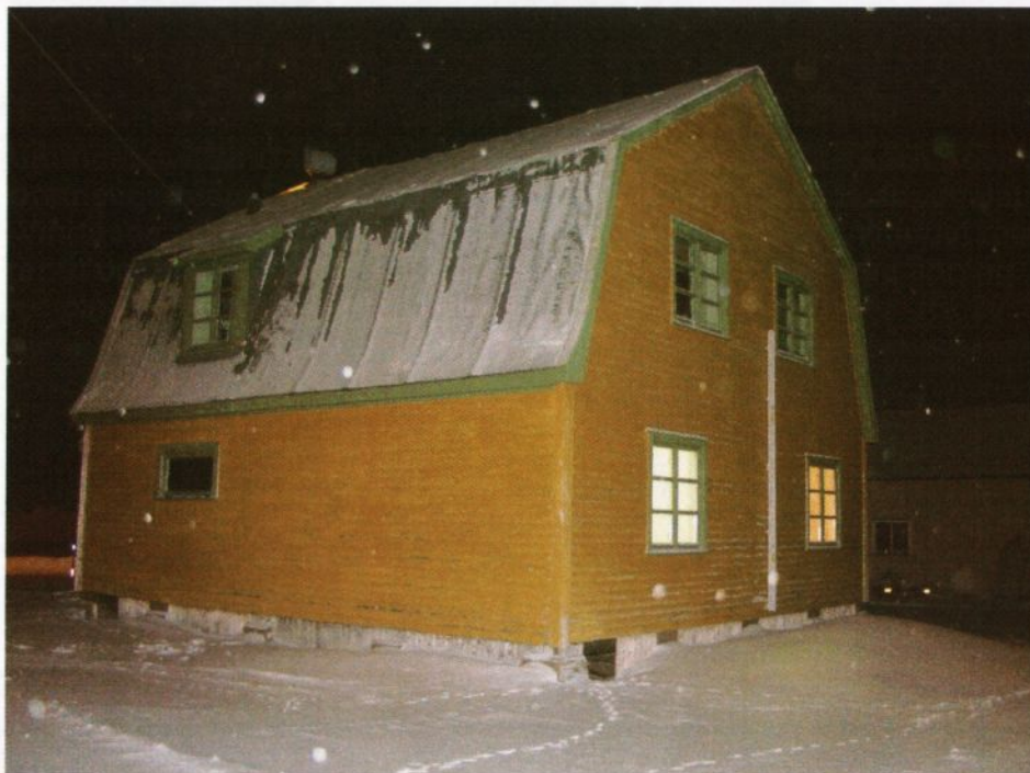
Figur 7. "Amundsenvillaen". Sett fra sydøst. Store endringer i fasaden ødelegger husets opprinnelige preg. De viktigste endringene er det liggende supanet og de nye vinduene. Vinduene står heller ikke i de opprinnelige åpningene. Vinduet med liggende format hører til det nåværende badet. Vinduet står ikke i opprinnelig åpning. Den opprinnelige pipa er revet. Slitasje på malingen på sydveggen. Foto. JB. 20.1.2004.
