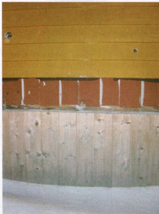
Figur 9. "Amundsenvillaen". Nordveggen. Detalj av nedre del av panelet. Øverst, gul oker liggende, pløyd supanel. Lag. 04 og lag 02. (Se tabellen) Under dette sees litt av forhudningspappen, lag 01 og opprinnelig, pløyd vekselpanel med engelsk rød ren linoljemaling, lag 1 og lag 2. panelet er kappet i nedkant. Nedenfor denne sees litt av svilla. Nederst er det påsatt en pløyd rupanel som beskyttelse og isolasjon. Denne er ubehandlet. Borehullene i panelet er trolig gjort i forbindelse med den planlagte istandsettingen av huset. Det er lite heldig at det er laget hull i veggkonstruksjonen fra utsiden. Hullene forårsaker en permanent utetthet i en eller flere av de opprinnelige forseglede bygningselementene. Foto. JB. 20.1.2004.
