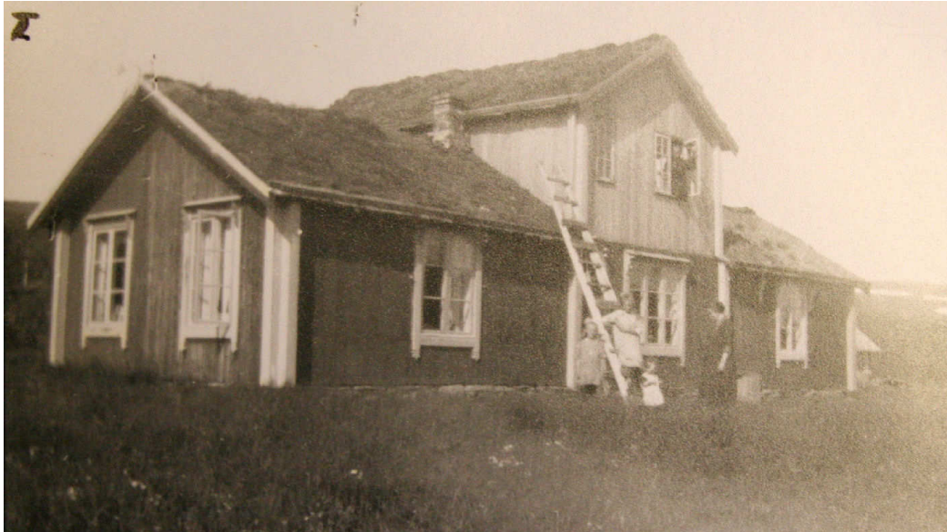
Figur 2. Rugeldalen. "Ratvolden.". Sett fra nordøst. 1924 – 1925. 2. etasje har trolig akkurat blitt ferdig. Pipene er ennå ikke forlenget. Huset har torvtak. 2. etasje er ikke malt som resten av huset. Utvidelsen mot nord er ikke bygget. (F.A. 2509.a.) Avfotografert: Brønne 2006.
