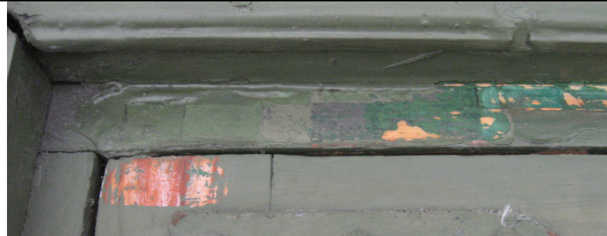
Avdekket felt på vinduskarmen. De eldre fargene ligger til høyre.
