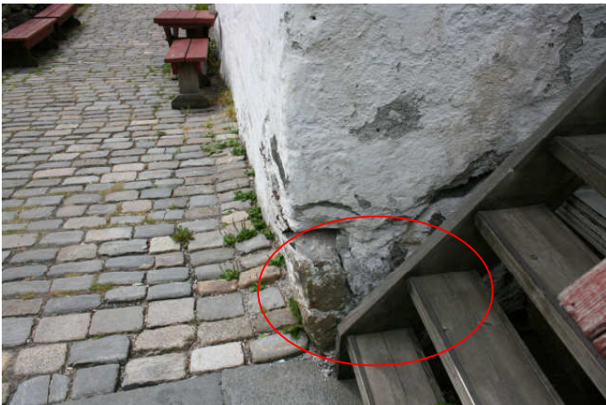
Figur 4 Utglidning av sten i SØ hjørne (østvegg).
