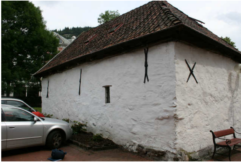
Figur 1 Bygning Ag (nordvest).
