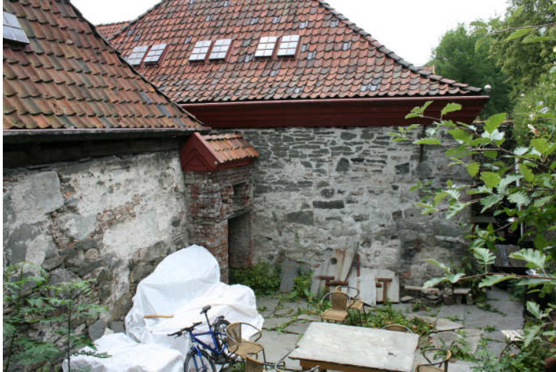
Figur 13 Bygning VI h sett fra sør.
