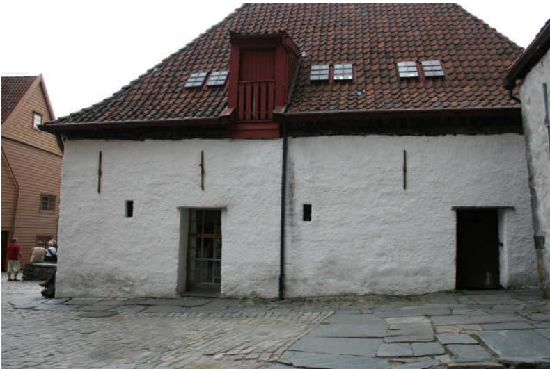
Figur 23 Nyrenovert østvegg med skvett puss.
