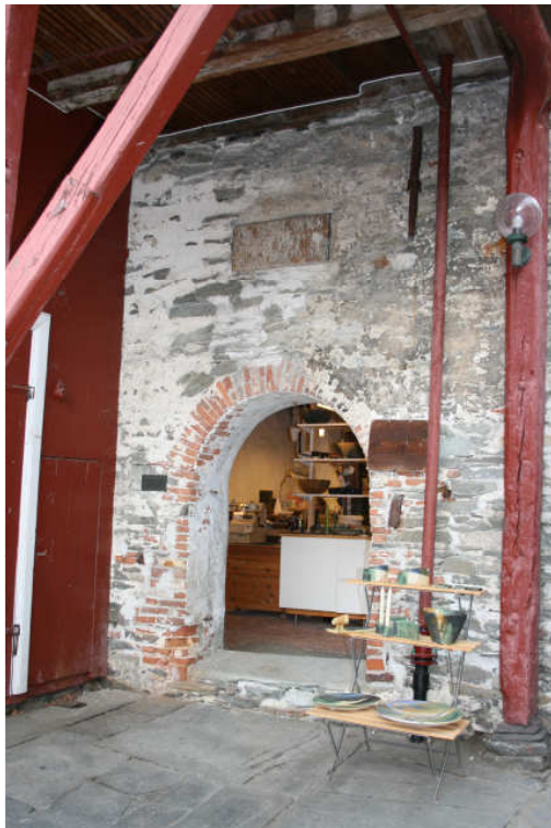
Figur 14 Bygning VI h, vestvegg.
