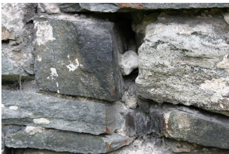
Figur 16 Fugeutfall, nordvegg.
