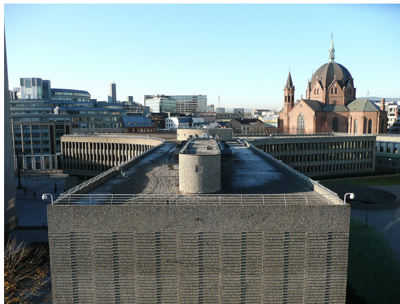
Y-blokken. Takflaten. Foto: Statsbygg.
