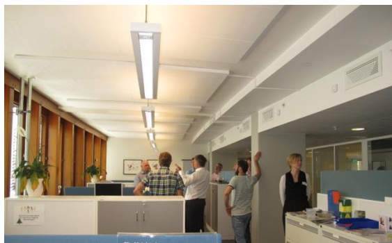
Foto som viser en typisk situasjon i de åpne kontorarealene. Mellom gangsonen og vinduene er det innpasset to kontorplasser i dybden. Teakinteriøret gir arealene et særpreg. Til venstre ved vinduene ses en av de vertikale føringene for varmtvann for oppvarming. Himlingen i den ytre sonen har direktemonterte akustikkreduserende plater. Til høyre ses «skjørtkanten» med til- og fraluft ventiler og sprinkling.
