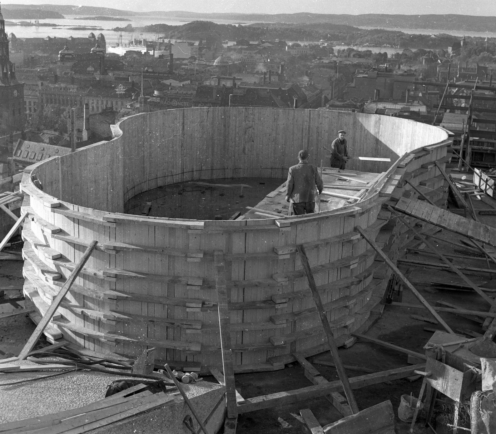
Bygging av heissjakt i Høyblokka. Foto: Dagbladet/Norsk Folkemuseum
