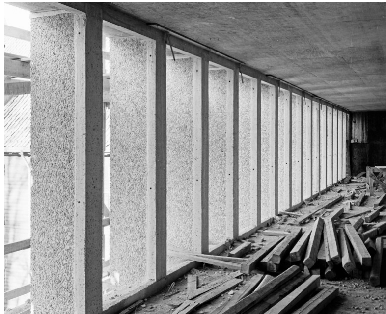
Høyblokka under oppføring før vinduspartiene i teak er på plass. Foto: Teigens Fotoatelier/DEXTRA FOTO/Teknisk museum
