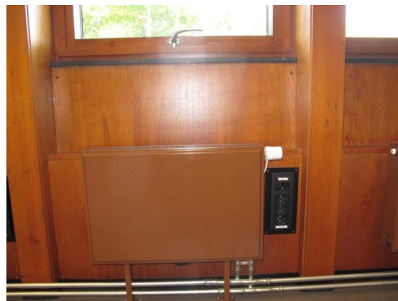
Foto innvendig yttervegg med radiator og uttak for el, tele og data. Foto M Boro©Riksantikvaren
