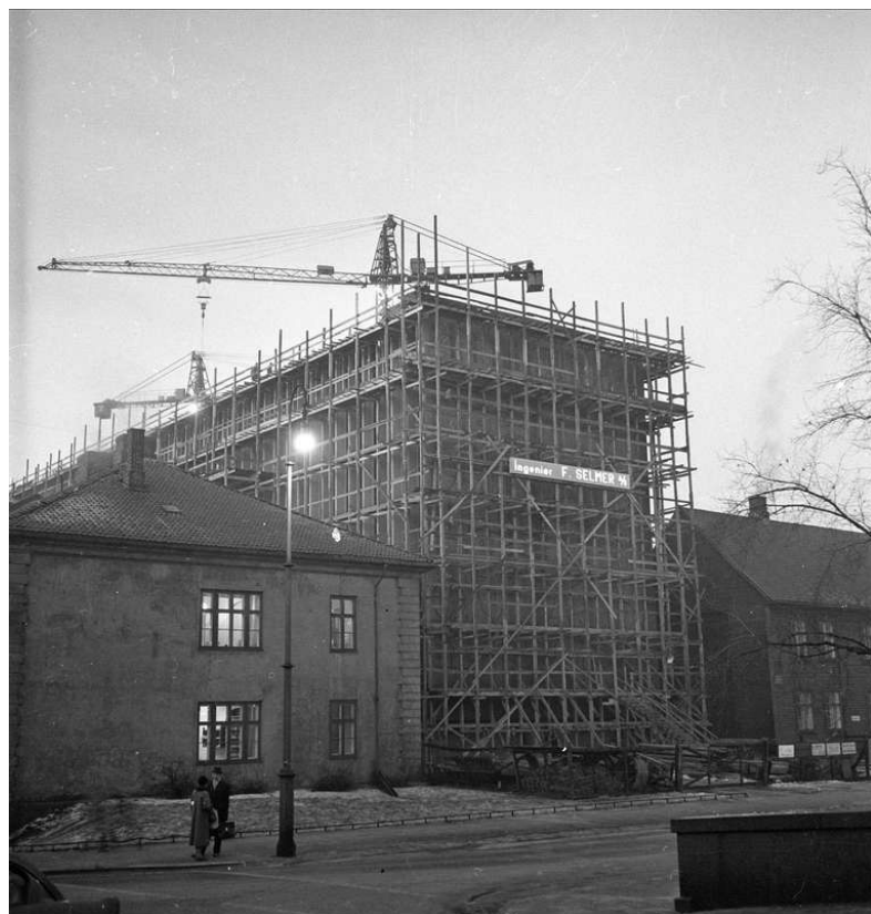
Høyblokka vokser frem mellom de gamle hospitalbygningene. Foto: Dagbladet/Folkemuseet
