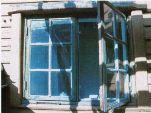
Fig. 11: Vindu i 3.etg sørfasade. Foto: NIKU, B. Wedvik 2006
