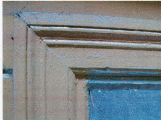
Fig. 12: Vindu i trapperom 2. etg sørfasade Foto: NIKU, B. Wedvik 2006.
