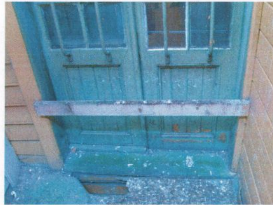
Fig. 14: Nedre del av dør i 2. etasje. Foto: NIKU, B. Wedvik 2006.
