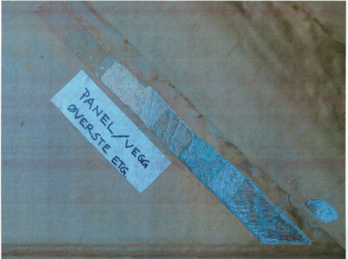
Fig 15: Fargetrapp på panel vestfasade. Foto: NIKU, M. Winness 2006.
