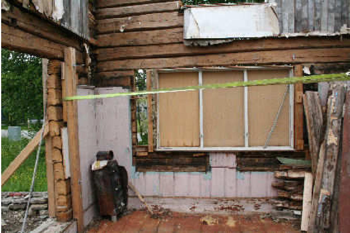
Figur 12. Røros. "Løbør-an", "Sorkenhuset". Bevart eldre panel i østrommet 1. etasje. Nordøsthjørnet. Foto: Brønne. 28.6.2007.
