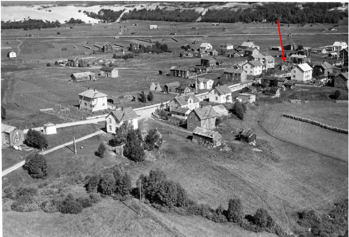
Figur 1. Røros. "Løbør-an", "Sorkenhuset" Sett fra sydvest. Flyfoto trolig tatt i begynnelsen av 1950-årene. "Løbør-an" er vist med en rød pil. Foto: Widerøe?/Rørosmuseet.
