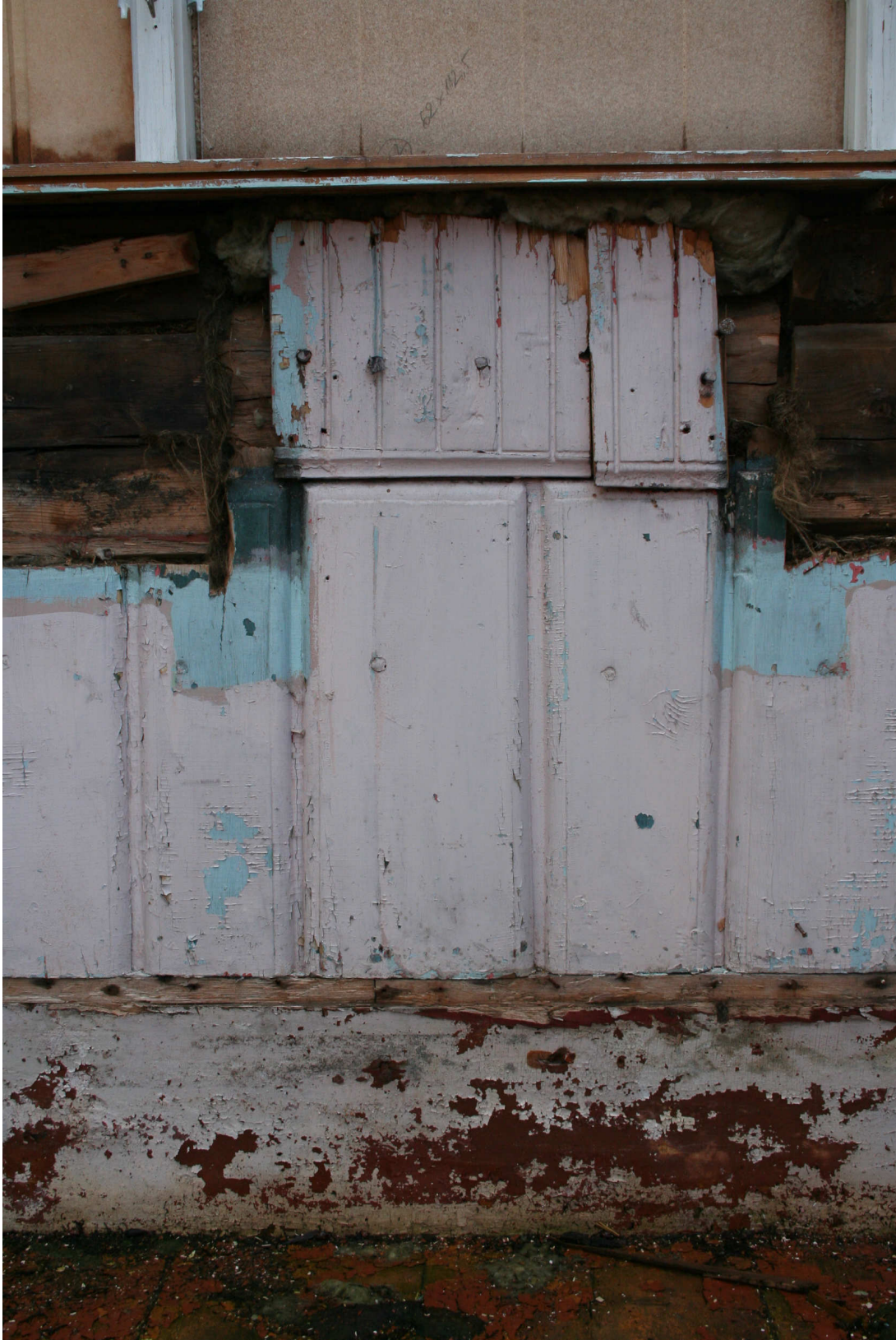
Figur 14. Røros. "Løbør-an", "Sorkenhuset". Bevart eldre panel under opprinnelige? vinduer på østveggen i østrommet 1. etasje. Panelbordene har en høvlet tverrprofil i overkant mot vindusåpningene. Profilen er den samme karnissprofilen som på sidekantene av panelet. Under panelet sees den forhugde dekklisten oppe på fotlista og nederst sees gulvet. De "kannelerte" panelbitene under vinduet og over det eldste panelet er sekundære. Foto: Brænne. 13.9.2007.
