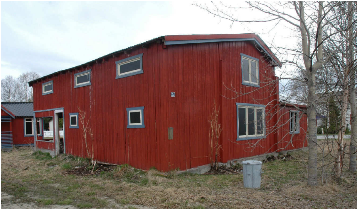
Figur 5. Røros. "Løbør-an", "Sorkenhuset" Sett fra sydøst. Før riving. Foto: Jon Holm Lillegjelten, Rørosmuseet. 2006?
