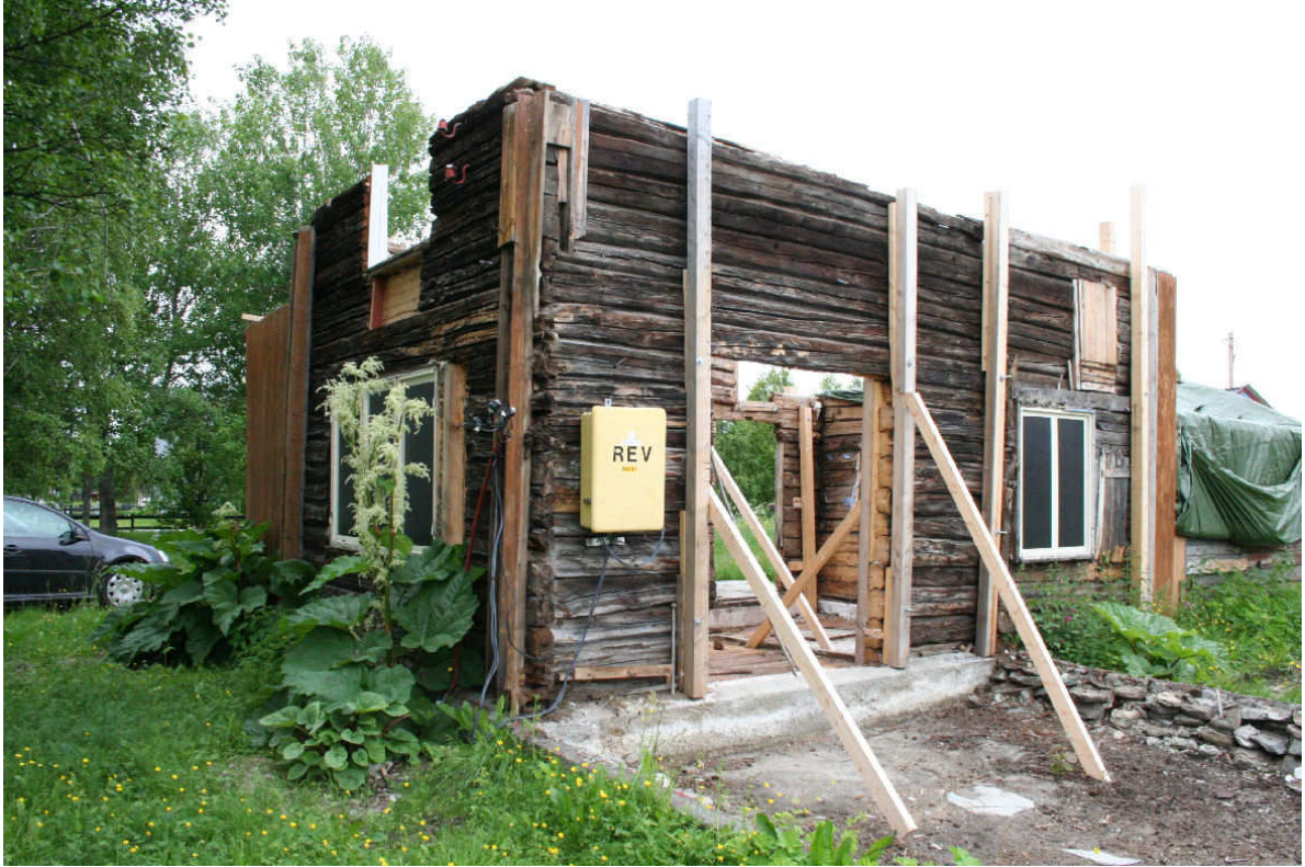
Figur 7. Røros. "Løbør-an", "Sorkenhuset" Sett fra nordøst. Foto: Brønne. 28.6.2007.
