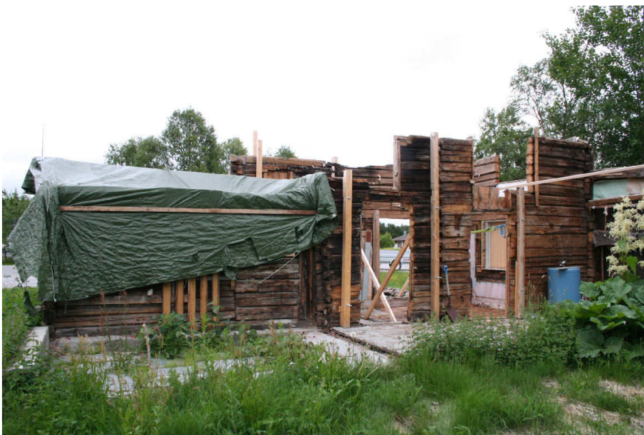
Figur 8. Røros. "Løbør-an", "Sorkenhuset" Sett fra vest. Foto: Brønne. 28.6.2007.
