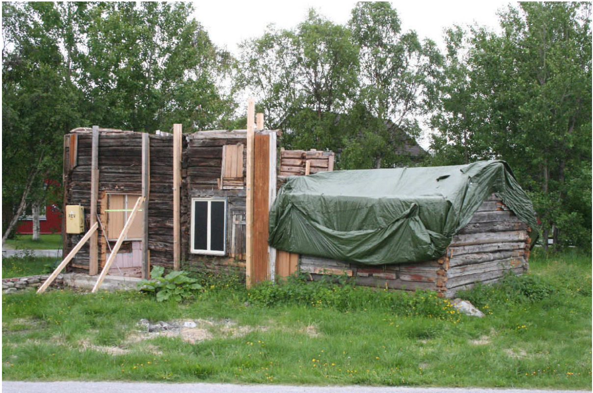
Figur 9. Røros. "Løbør-an", "Sorkenhuset" Sett fra nordvest. Foto: Brønne. 28.6.2007.
