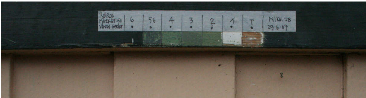
Figur 13. Farge-trapp avdekket på vindusgerikt. Foto. JB. 29.6.2007.
